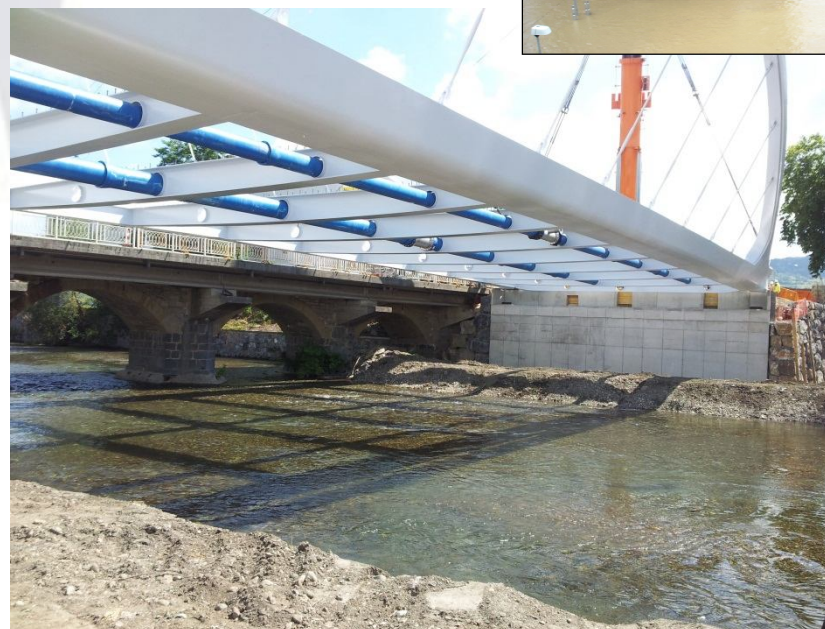
Sustitución del puente Karabel en Hernani 2.345.363 €
