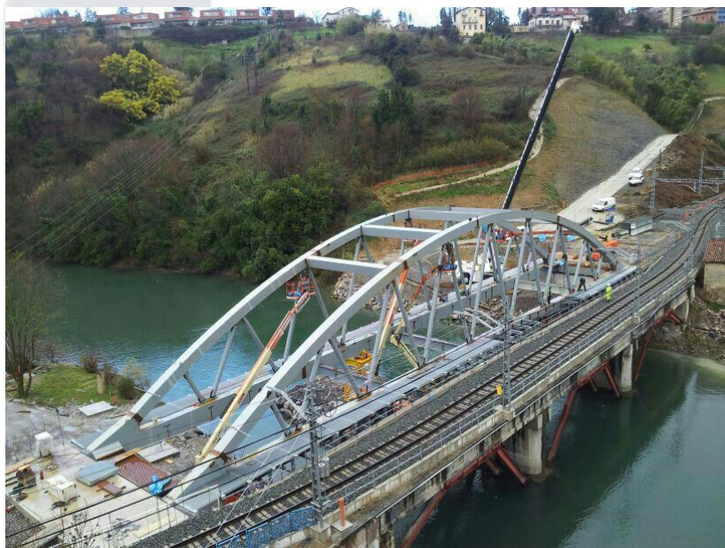
Sustitución del puente del topo sobre el Urumea y demolición del puente-colector de Añarbe 2.308.053 €
