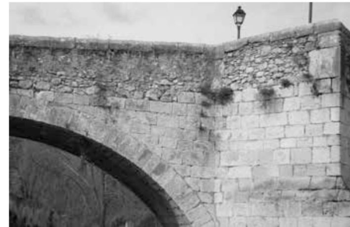
En la riada del 11 de octubre de 1797 el agua superó las barandas del puente con la estatura de un hombre
