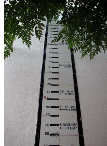
Placas y marcas de calado de eventos de inundación
