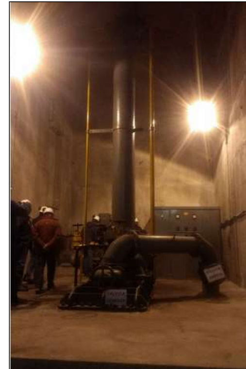
Ensayo de Compuerta Cabecera Central Nihuil I
