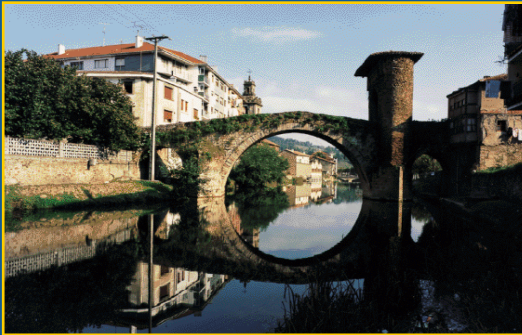
Puente de Zubizaharra sobre el río Cadagua. Balmaseda.
