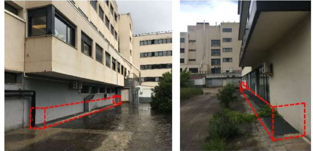
Fig. 25 Murete de protección de rejilla hospital y residencia.
