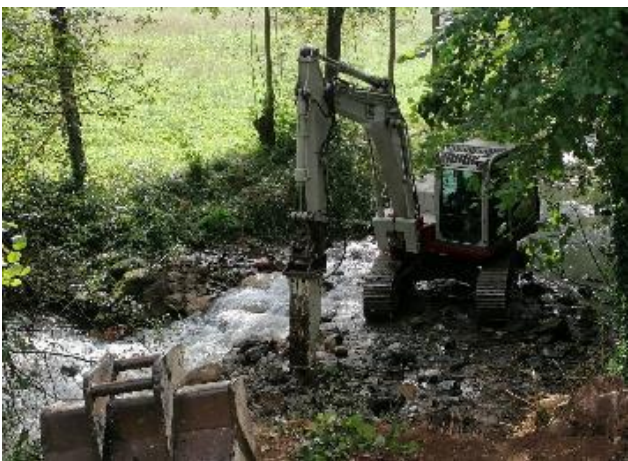
RNF Somiedo. Eliminación de azud.
