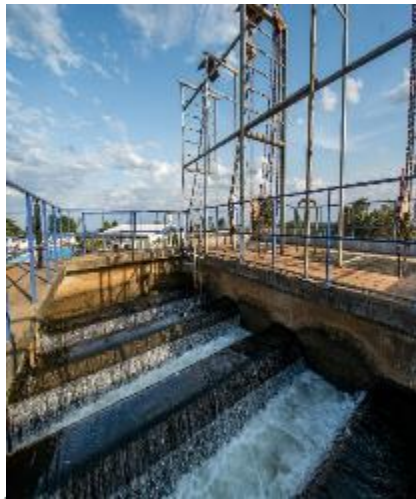
Plantas de tratamiento de agua
