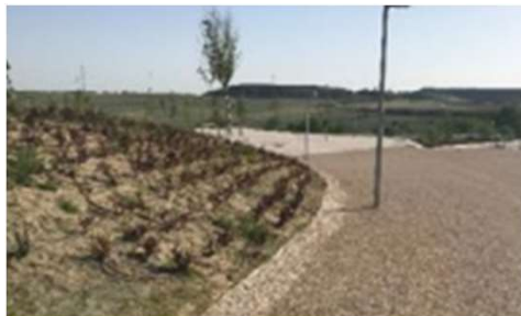
Zanjas de Infiltración.
