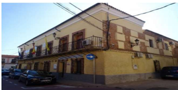
Fachada a Plaza del Ayuntamiento.
