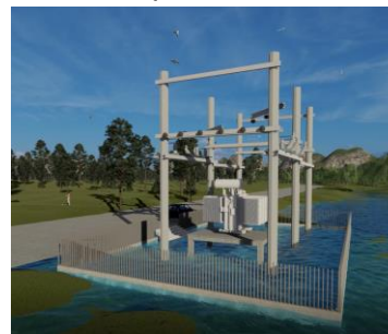
Centro de transformación elevado
