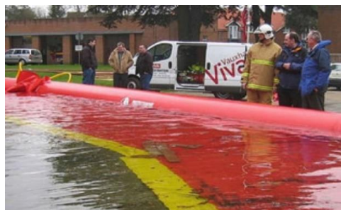
Colocación de barreras temporales hinchables Flood proofing in urban areas. 2019
