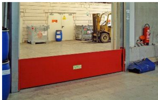
Colocación de barreras temporales
