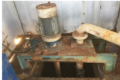
Colocación de bombas de achique Medidas de autoprotección en Teknia
