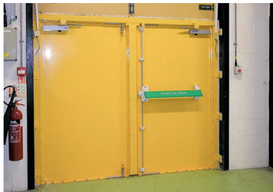
Colocación de puertas estancas
