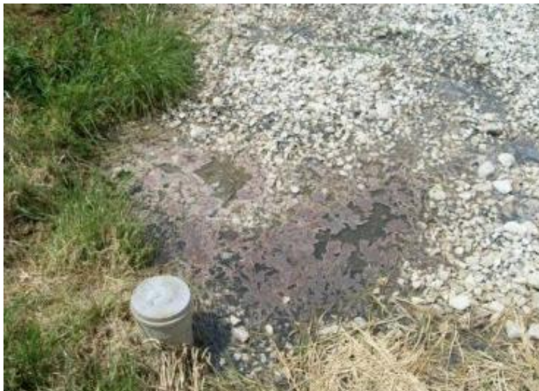
Humedal colmatado EDAR Žminj -Croacia- (Fuente: Constructed Wetlands).
