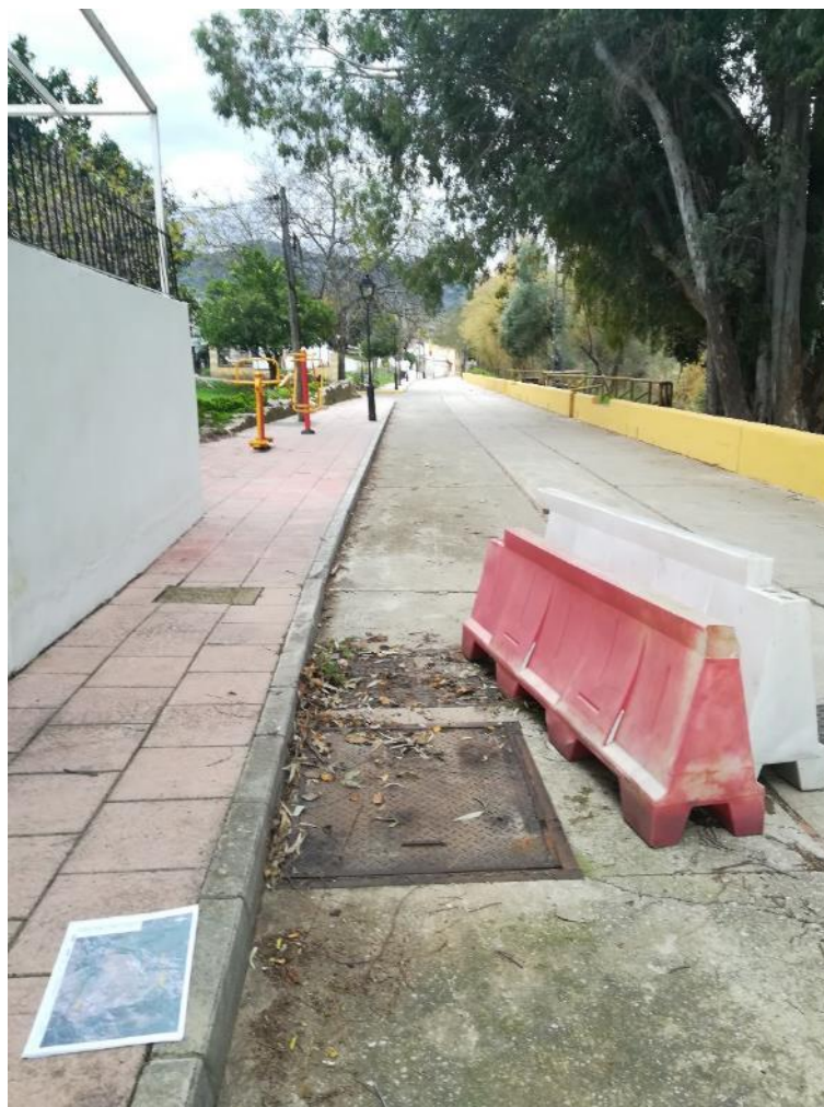
Ubicación EBAR La Estación.
