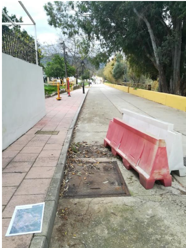
Ubicación EBAR La Estación.
