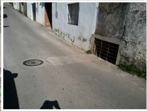
FOTO N°2: POZO PREVIO A PV3
