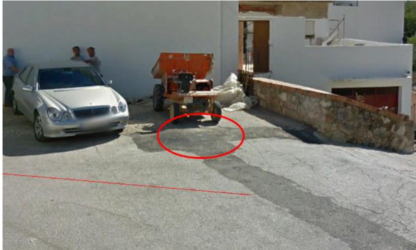
Arqueta A1 para suministro a la EBAR Sur.
