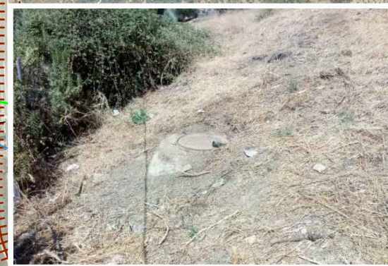
FOTO N°4: POZO PREVIO A PV8
