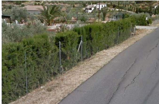
Grietas longitudinales sobre la carretera, originadas por procesos de reptaciones de ladera.
