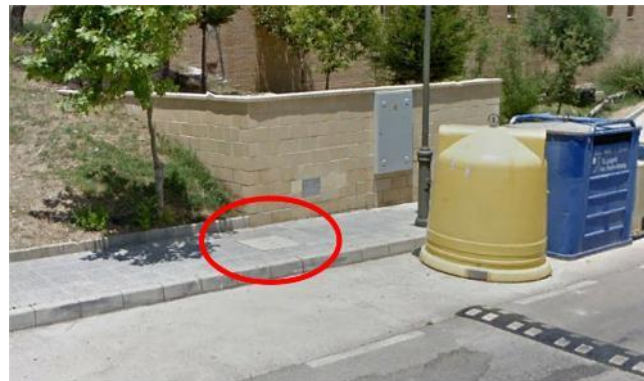
Arqueta A1 para suministro a la EBAR Norte.
