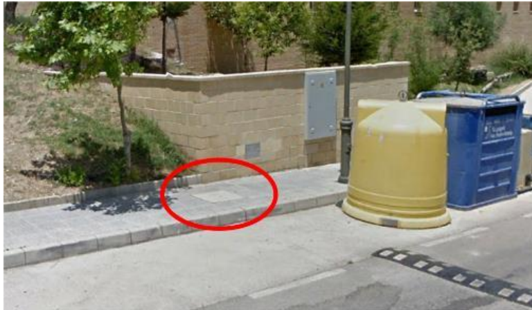
Ilustración 45. Arqueta A1 para suministro a la EBAR Norte
