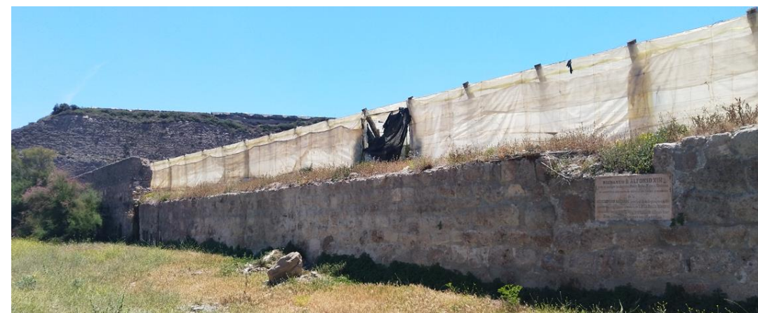
- Vista del muro existente
