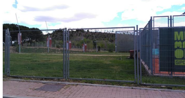
Instalaciones de la Caja Mágica por la que podría pasar el colector de pluviales de margen derecha
