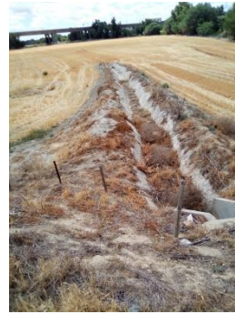
Drenaje de la conducción en terraplén
