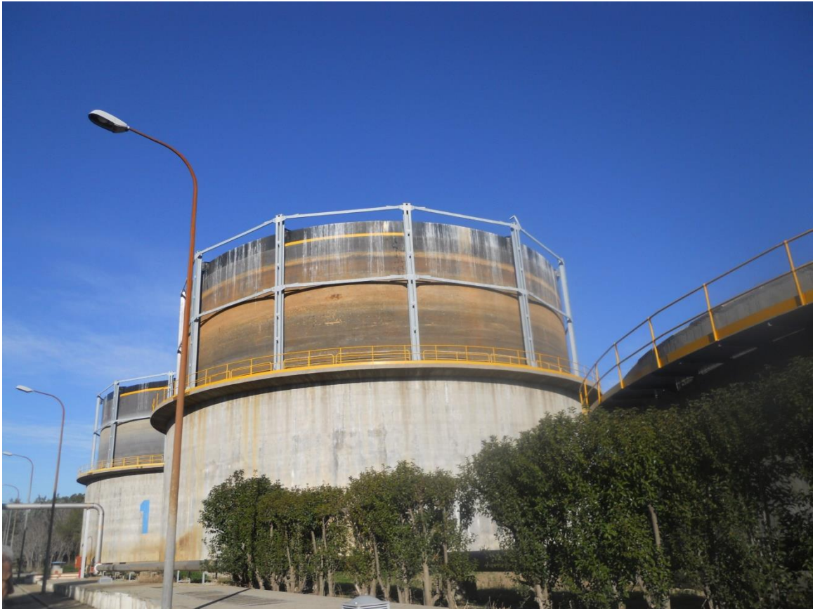
Ilustración 124: Gasómetros de campana
