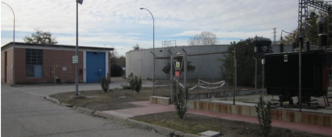
44: Depósito de agua regenerada
