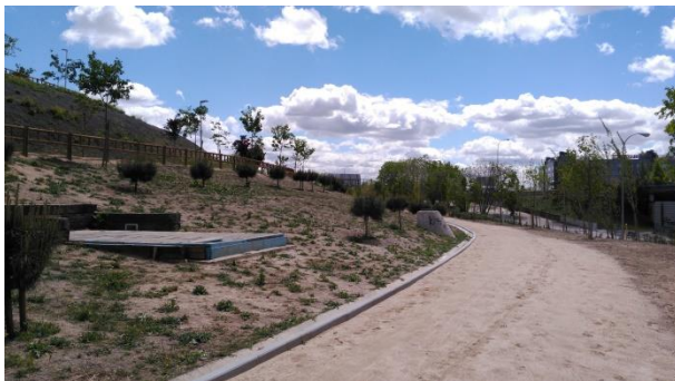
Zona verde por donde podría transcurrir el colector de pluviales propuesta por margen derecha
