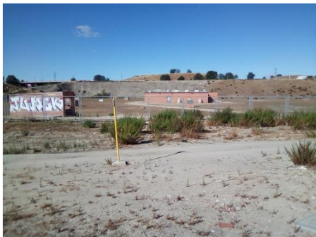
Señalización de gasoducto en el camino. Al fondo el Tanque de Tormentas de Butarque
