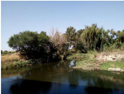
Cauce del río Manzanares bajo viaducto de línea ferroviaria
