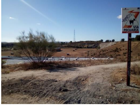
Al fondo Tanque de Tormentas y señalización de Vía Pecuaria
