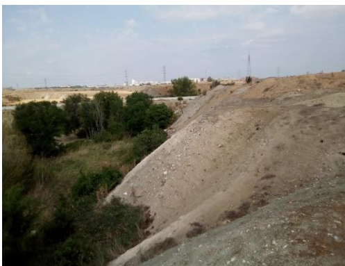
Taludes de tierra 1H:1V vertidos junto al arroyo La Bulera
