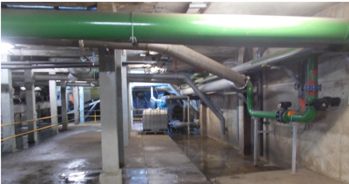
Ilustración 127: Sótano de sala de deshidratación
