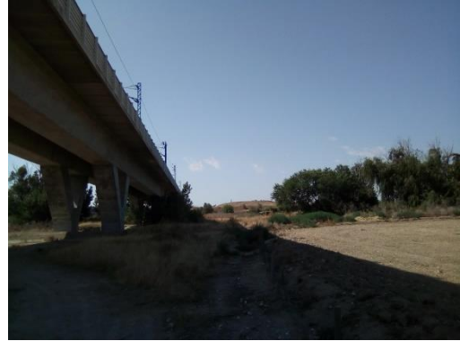
Viaducto línea ferroviaria (izquierda) y vegetación de ribera en el Río Manzanares (derecha)
