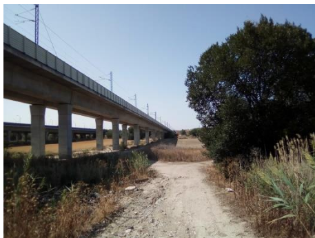
Viaducto de línea ferroviaria (izquierda) y cruce sobre el Real Canal del Manzanares (abajo)
