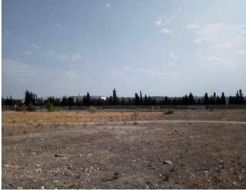
Vista de la EDAR de Butarque desde la superficie propuesta para ampliación de la EDAR
