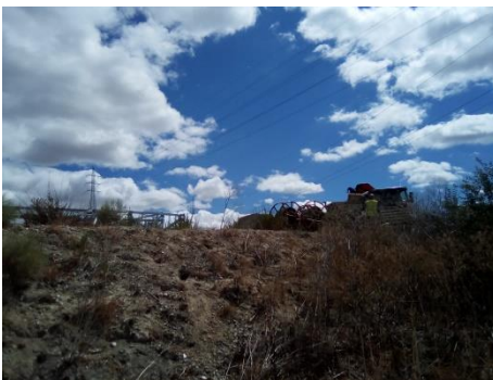
Instalación auxiliar de obras de electricificación
