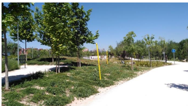
"Respiraderos" del gasoducto
