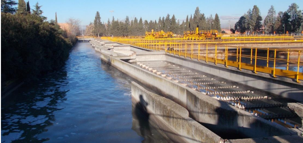
Ilustración 95: Canal recolector de primarios
