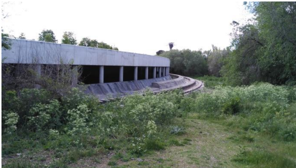
Vista del Aliviadero General de Margen Izquierda (AGMI)
