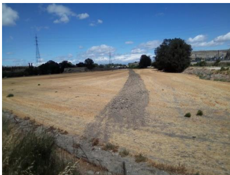
Vista de la zanja de reciente construcción
