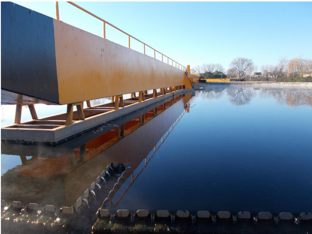
Ilustración 111: Decantador secundario
