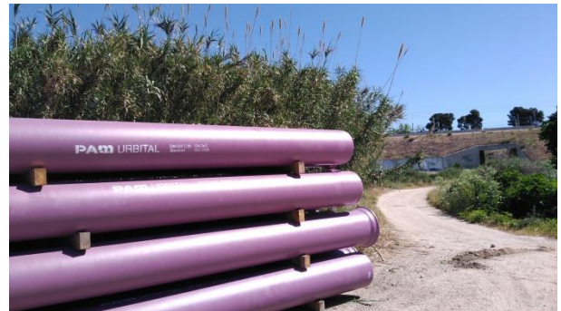
Detalle de las tuberías acopiadas
