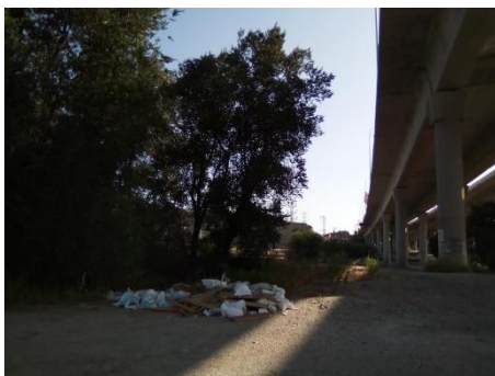
Vertidos bajo el viaducto de la M-45
