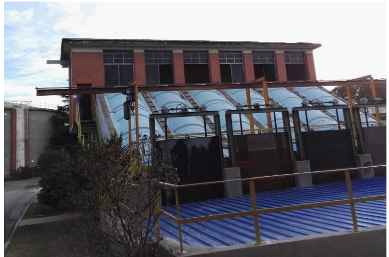
8: Tornillos de elevación a desarenadores
