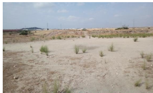
Suelo compactado con evidencias de encharcamiento
