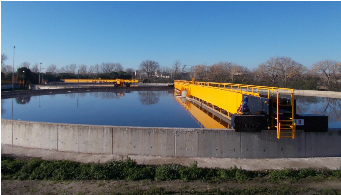
Ilustración 110: Decantador secundario
