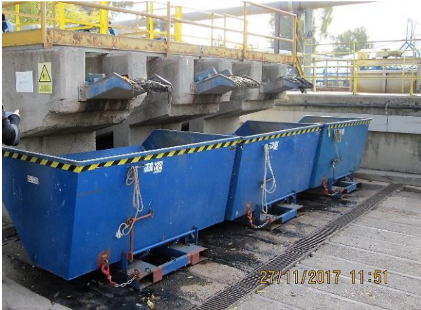
10: Retirada de arenas
