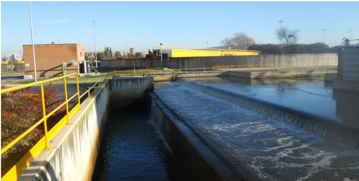
Ilustración 115 Obra de salida
