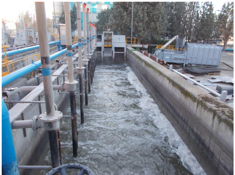
Ilustración 88: Desarenador
