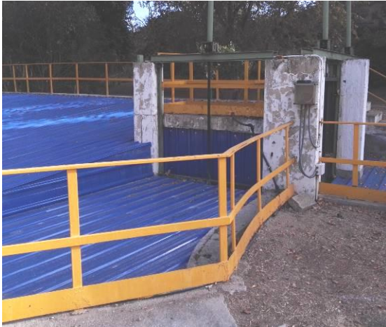
1: Obra de entrada cubierta
