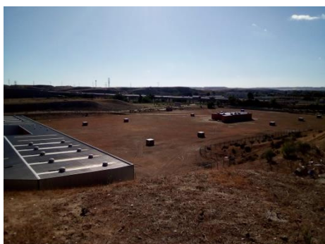
Vista del Tanque de Tormentas de Butarque
