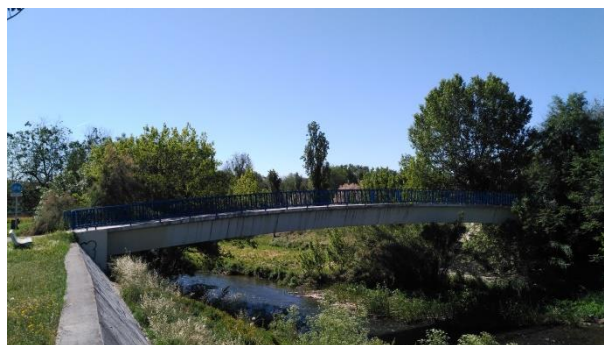
Vista de la pasarela sobre el río Manzanares
