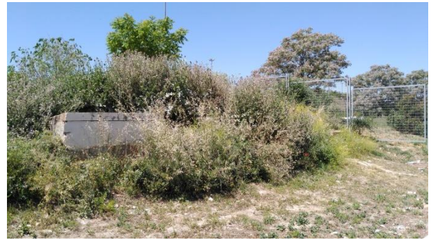
Arqueta existente junto a la zona por la que podría transcurrir el colector de pluviales desde el AGMI, junto al tanque de tormentas de La China
