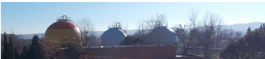
Ilustración 130: Gasómetros de membrana
