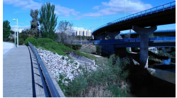
Aliviadero del colector de pluviales junto al Nudo Sur
