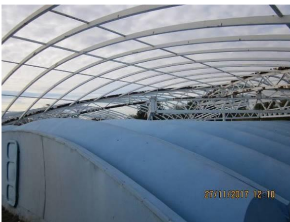
24: Espesador de gravedad cubierto
