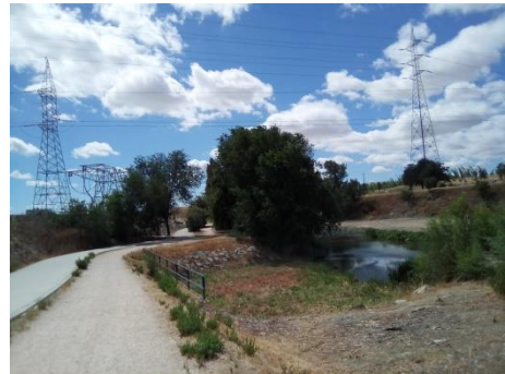
Vista del alivio de la EDAR de la Gavia. Al fondo apoyos de línea eléctrica
