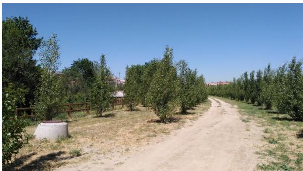
Arqueta por la que pasa el actual colector de pluviales de margen derecha
