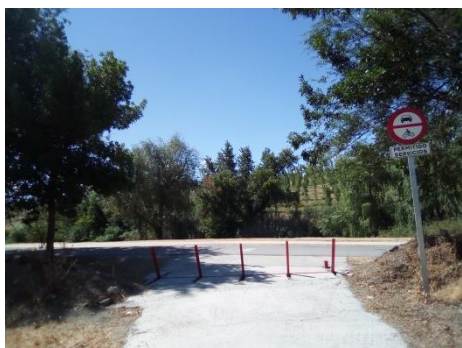
Dispositivo para impedir el acceso de vehículos al Carril del Manzanares
