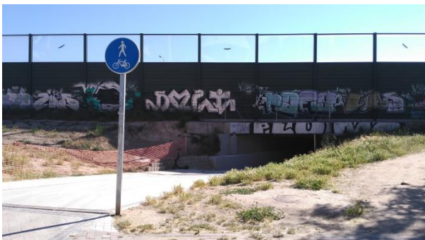
Vista del paso inferior bajo la A-4 que da acceso al Paseo Fluvial del Río Manzanares
