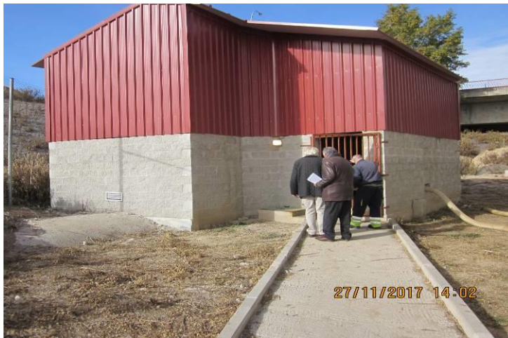
51: Caseta de obra de entrada
