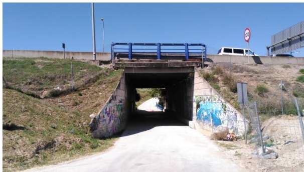
Paso inferior bajo la A-4. Acceso al Parque Lineal y posible acceso a las obras
