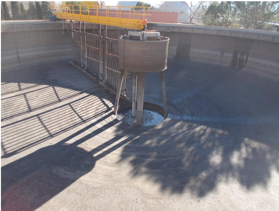
Ilustración 117: Espesador de fangos
