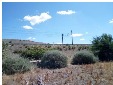
Camino de servicio y plataforma de ferrocarril junto a la parcela planteada para Tanque
