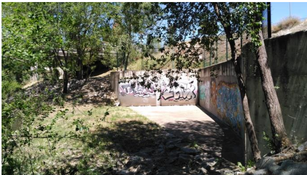
Aliviadero del tanque de tormentas de La China
