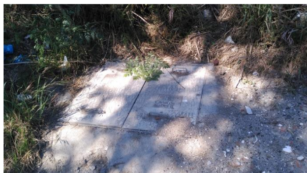
Arqueta del Canal de Isabel II existente junto al camino por el que podría pasar el colector de pluviales procedente de la EDAR China
