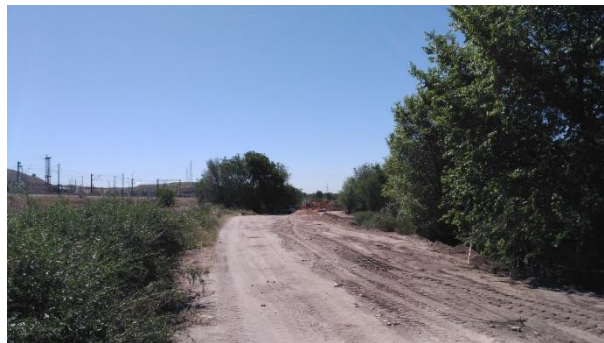
Vista de la zanja rellena de las obras de conducción de aguas regeneradas en el camino por el que previsiblemente podrían transcurrir los trazados de las conducciones de pluviales y fangos entre las EDAR de La China y Butarque
