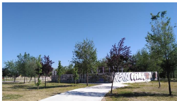
Arqueta de colector actual en zona verde en el PF
