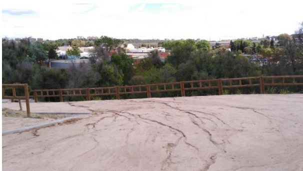
Vista desde zona verde del Parque Lineal del Manzanares de la EDAR De La China
