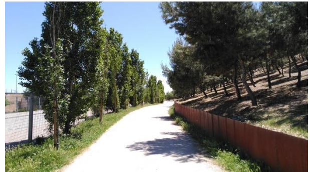
Vial del Parque Lineal del Manzanares junto al tanque de tormentas de La China
