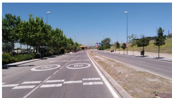
Carretera de acceso al Parque Lineal del Manzanares. A la izquierda de la fotografía está el carril bici
