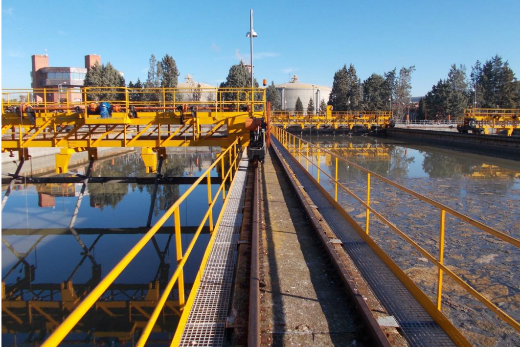
Ilustración 91: Decantadores primarios
