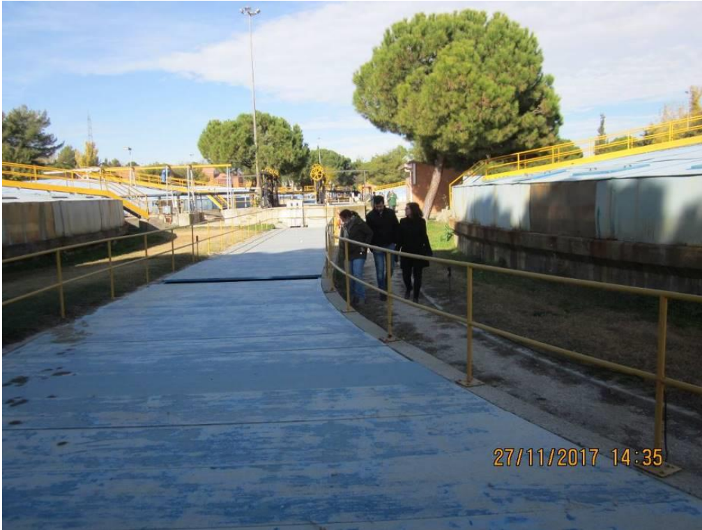
68: Canal de reparto entre decantadores
