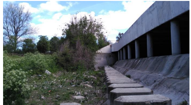
Vista del Aliviadero General de Margen Izquierda (AGMI)
