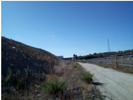
Camino entre el Tanque de Tormentas (a la derecha) y depósito de tierras (izquierda)
