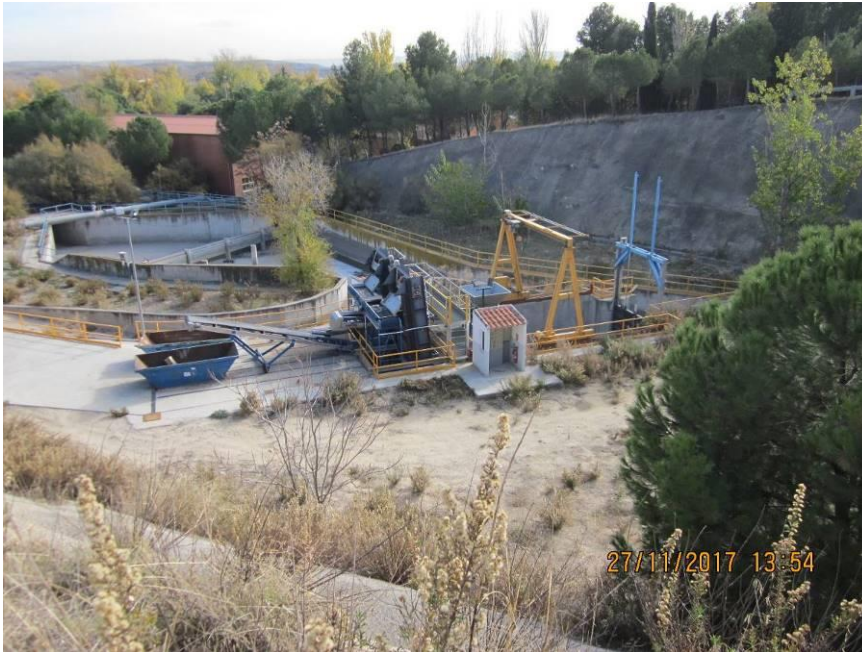
64: Conexión colector Butarque
