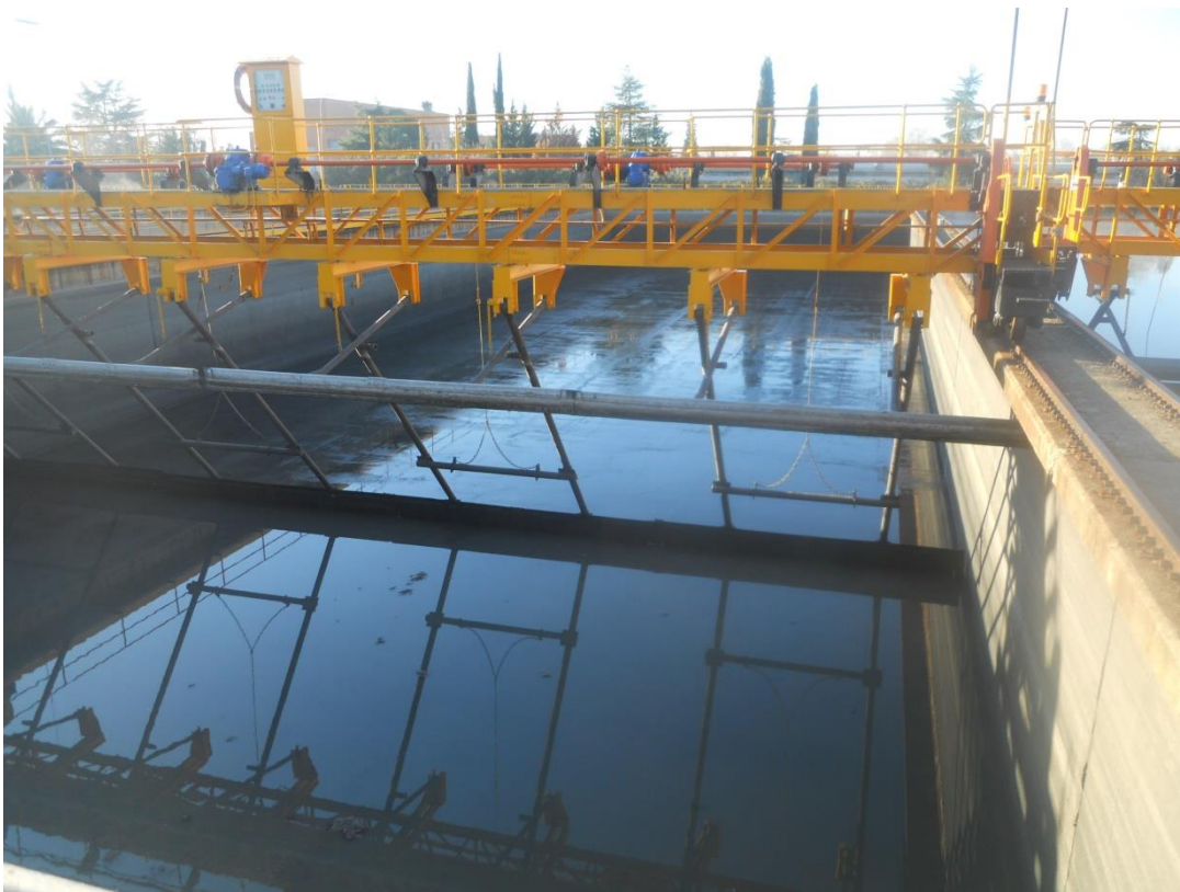
Ilustración 92: Decantador primario
