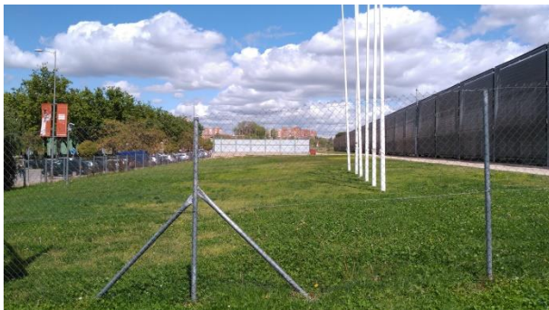
Instalaciones de la Caja Mágica por la que podría pasar el colector de pluviales de margen derecha
