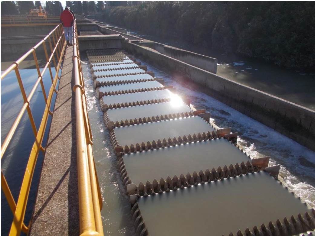
Ilustración 94: vertederos y salida de decantadores primarios
