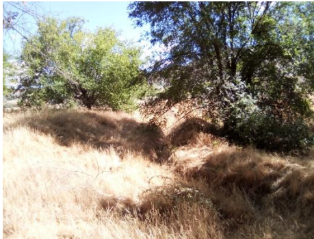
Acequia junto a la parcela en la que se plantea ubicación de Tanque de Tormentas
