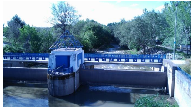
Infraestructura hidráulica en el río Manzanares
