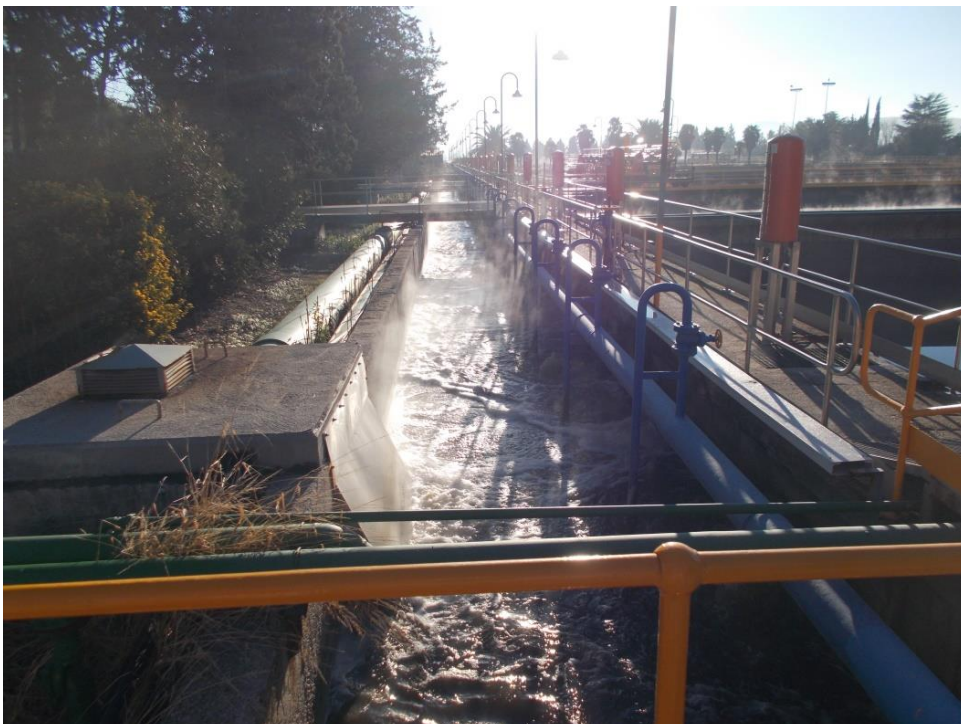
Ilustración 90: Canal de reparto a primarios
