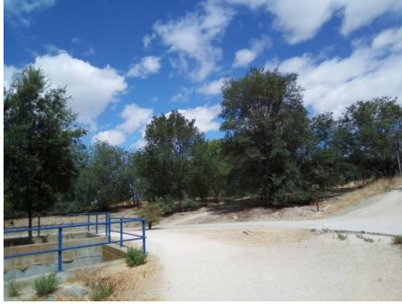
Vista de zona posible para aliviadero de Tanque de tormentas propuesto
