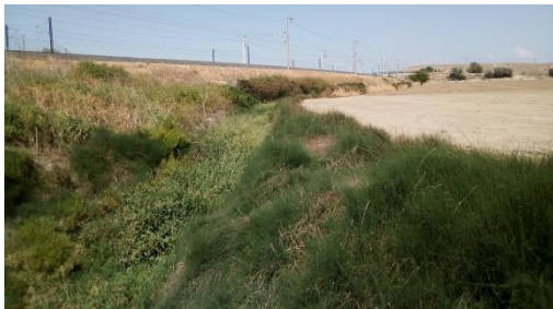
Cuneta/Acequia entre plataforma ferroviaria y tierra de labor
