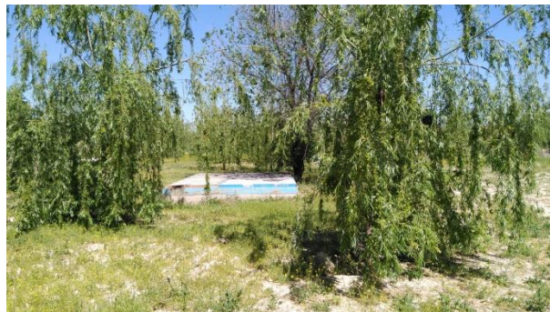
Arqueta de actual colector de pluviales entre sauces llorones del Parque Lineal
