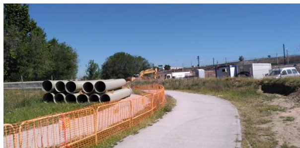
Zona auxiliar de acopio y oficinas junto al río Manzanares
