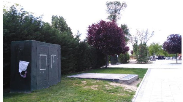
Arqueta del actual colector de pluviales
