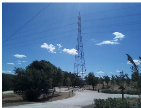
Zona verde en margen derecha del río Manzanares. Y apoyo de línea eléctrica
