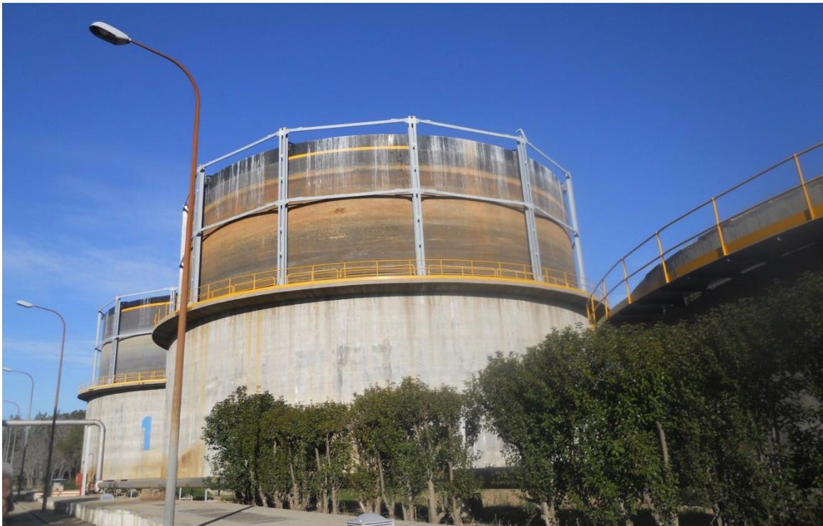
Ilustración 136: Gasómetro de campana
