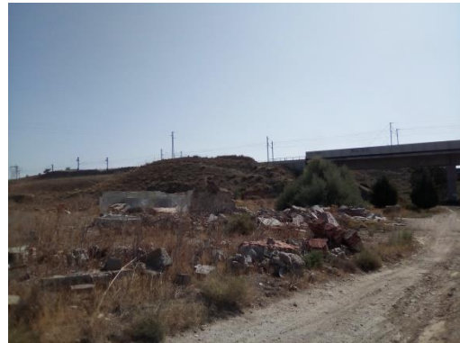
Residuos de demolición junto al Camino de Vinateros
