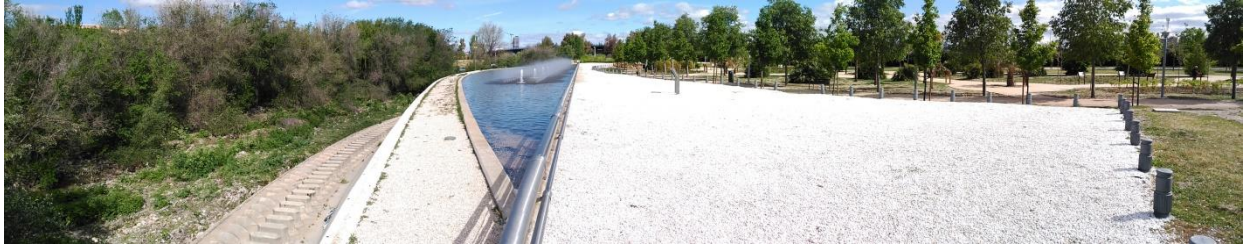
Vista de la parte superior del Aliviadero General de Margen Izquierda (AGMI)
