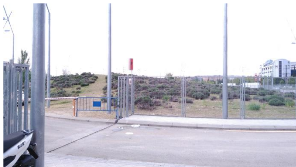
Entrada a las instalaciones de la Caja Mágica y por dónde podría pasar el colector de pluviales propuesto por margen derecha
