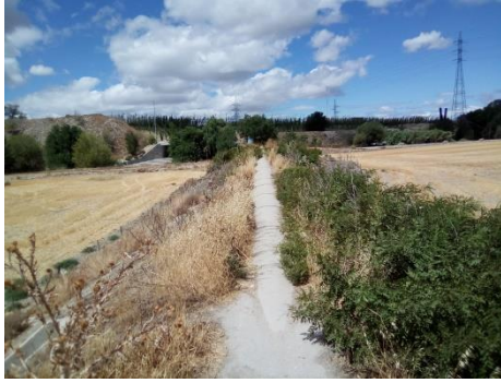
Conducción en terraplén cruza el trazado del colector de fangos propuesto por margen izquierda
