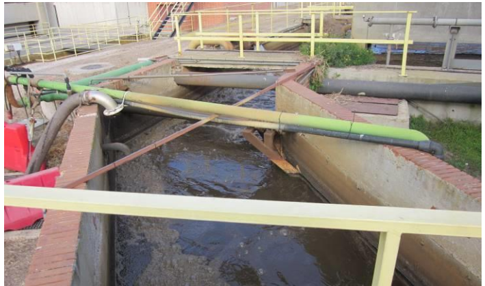
20: Canal de reparto
