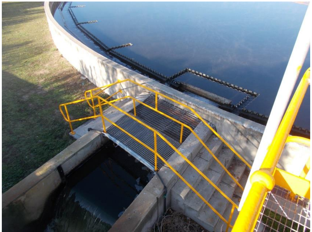
Ilustración 113: Salida agua tratada
