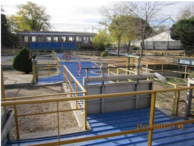
5: Canales de transporte a desarenador. (Antiguos desarenadores)
