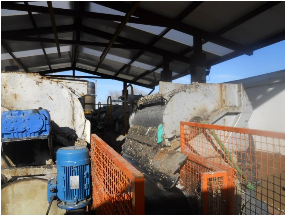
Ilustración 121: Tamizado de fangos primarios
