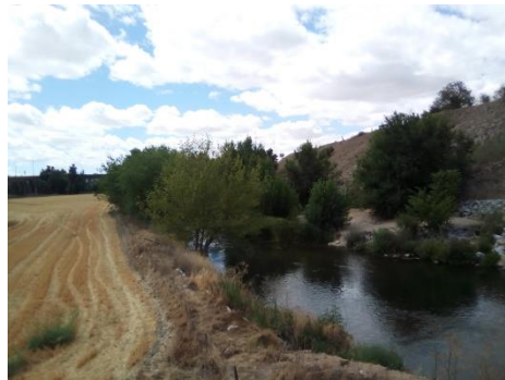
Margen izquierda del Manzanares desde la conducción en terraplén
