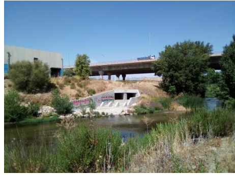
Aliviadero en la EDAR de Butarque
