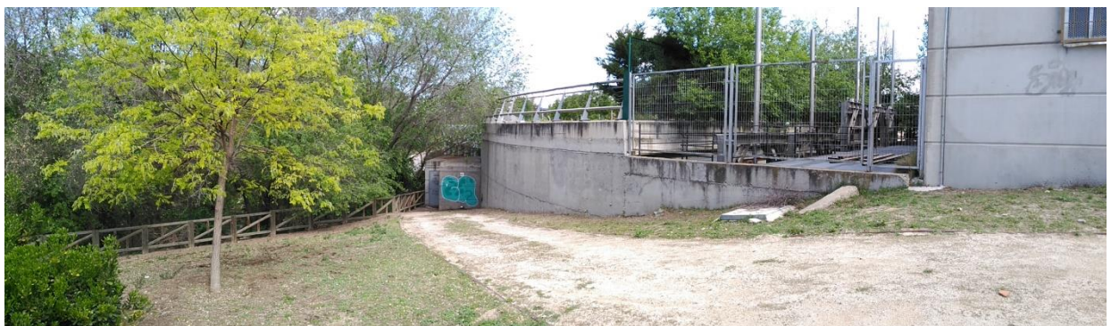
Vista del Aliviadero General de Margen Izquierda (AGMI)
