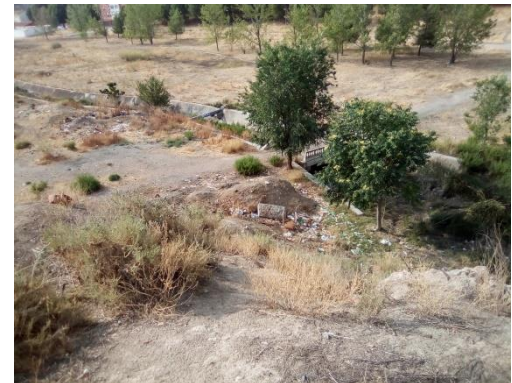
Arroyo La Bulera desde el terreno contiguo
