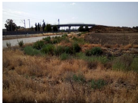
Zona por la que podría pasar la conducción de fangos hacia la EDAR Sur. Al fondo paso superior sobre línea férrea
