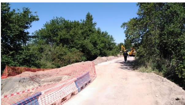
Obras de conducción de aguas regeneradas en el camino por el que previsiblemente podrían transcurrir los trazados de las conducciones de pluviales y fangos entre las EDAR de La China y Butarque
