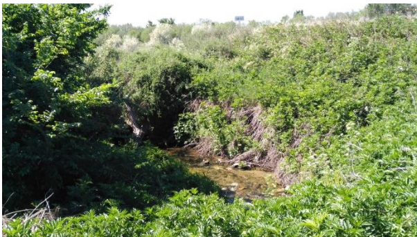
Salida de obra de drenaje transversal del camino por el que podrían transcurrir los trazados de las conducciones de pluviales y fangos entre las EDAR de La China y Butarque
