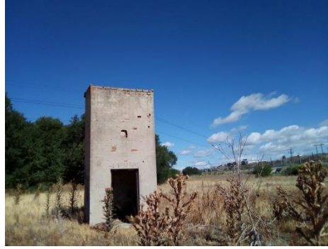
Edificación abandonada en en la parcela en la que se plantea ubicación de Tanque de Tormentas
