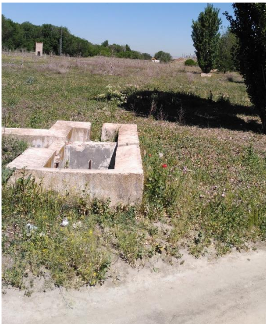
Arqueta perteneciente a un sistema de acequias abandonado existente en la parcela para posible ubicación de tanque de tormentas
