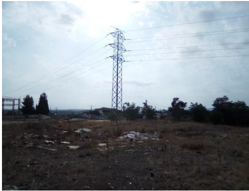
Línea eléctrica contigua al terreno previsto para ampliación de EDAR
