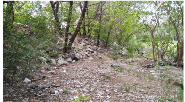
Escollera junto a la confluencia del agua de salida del AGMI con el río Manzanares
