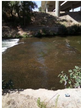
Losa de hormigón bajo el río Manzanares
