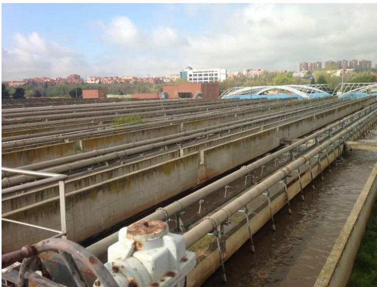
14: Reactores biológicos y conducciones de aire
