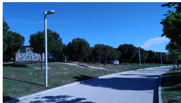
Vial del Parque Lineal y zona por la que pasa el actual colector de pluviales
