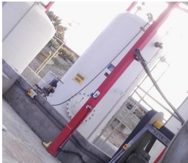
27: Desodorización espesadores
