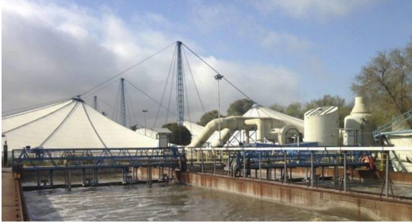
13: Cubierta de decantadores y desodorización
