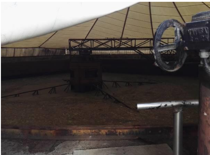
12: Vista de decantador dentro de las cubiertas
