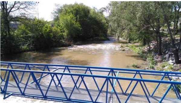
Vista del río Manzanares junto a infraestructura hidráulica
