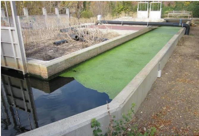
45: Entrada a Terciario
