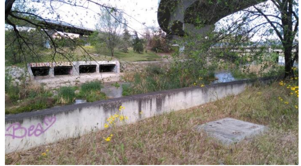
Aliviadero al río Manzanares
