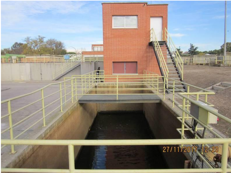
41: Canal de reparto
