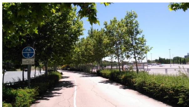
Carril bici (en el centro) junto al tanque de tormentas de La China (a la derecha de la fotografía) y por el que podría transcurrir el colector de pluviales desde el AGMI
