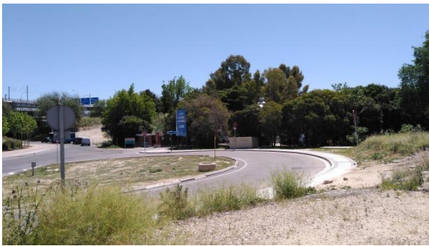
Acceso a la EDAR La China
