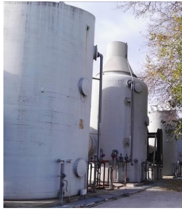
11: Desodorización de primarios
