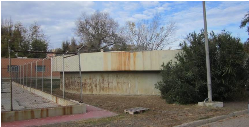
26: Espesador de flotación
