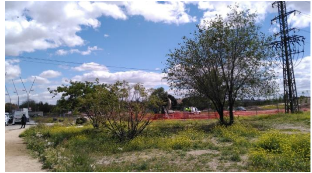
Obras del Proyecto de Riego de los Taludes del Parque Lineal del Manzanares entre la M-40 y la Caja Mágica. Posible servicio afectado en caso de ejecutar el colector de pluviales por margen derecha
