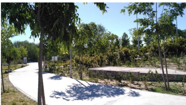
Otra arqueta de colector actual en zona verde en el PF
