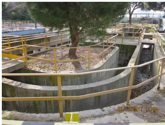
6: Canales de reparto antiguos sin utilización
