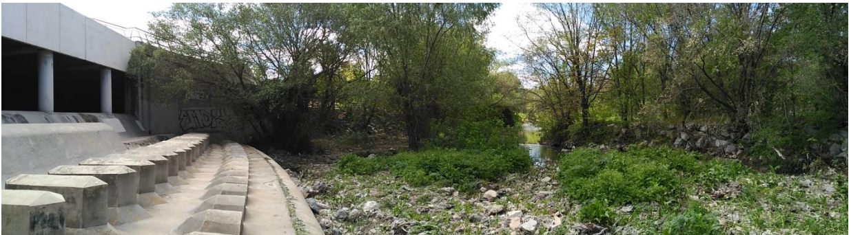
Vista del Aliviadero General de Margen Izquierda (AGMI)
