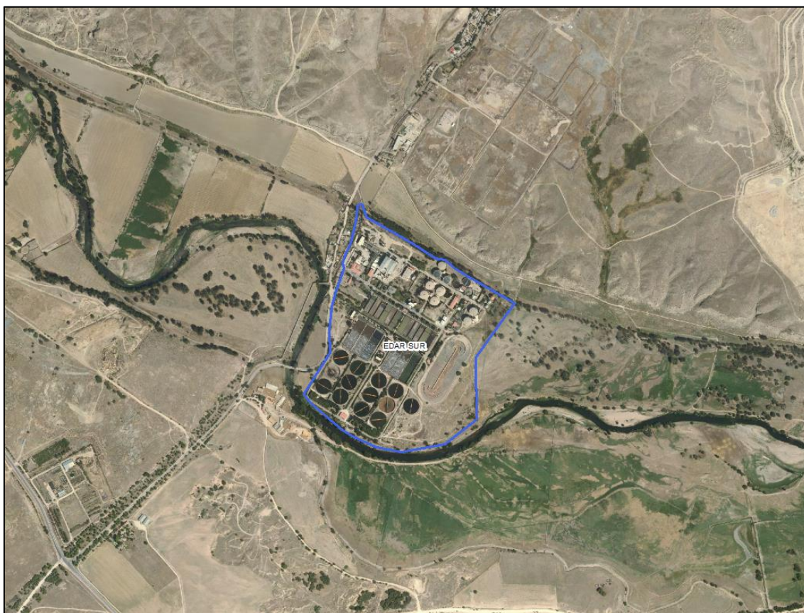
Ilustración 3: Imagen aérea de la instalación actual EDAR Sur (Ortofoto obtenida de PNOA)
