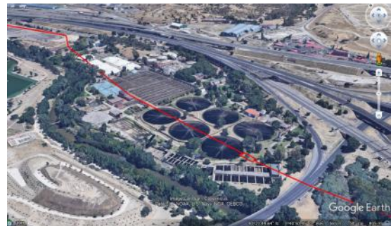
Ilustración 104. Vista del tramo del colector por margen izquierda, desde el tanque de tormentas hasta la EDAR de La China
