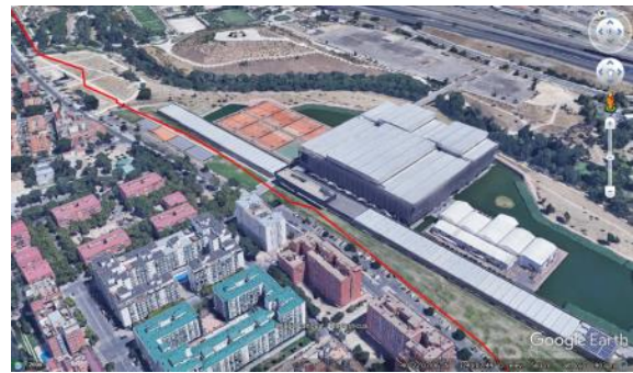
Ilustración 118. Vista del tramo de colector por margen derecha desde figura anterior pasando junto a la Caja Mágica y por el Barrio de San Fermín
