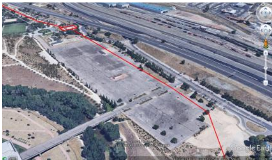
Ilustración 103. Vista del tramo del colector por margen izquierda, desde la rotonda, pasando junto al tanque de tormentas existente
