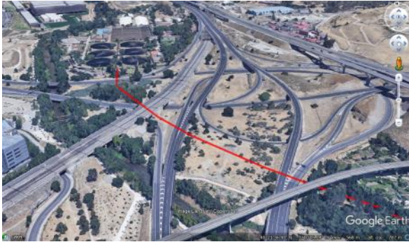
Ilustración 27. Salida de la impulsión de la EDAR La China y cruce del nudo viario y ferroviario
