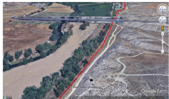
Ilustración 38. Impulsión subterránea por el pie de talud del camino. Colindante al Canal del Manzanares
