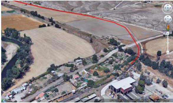
Ilustración 41. Llegada de la impulsión subterránea a la EDAR Sur
