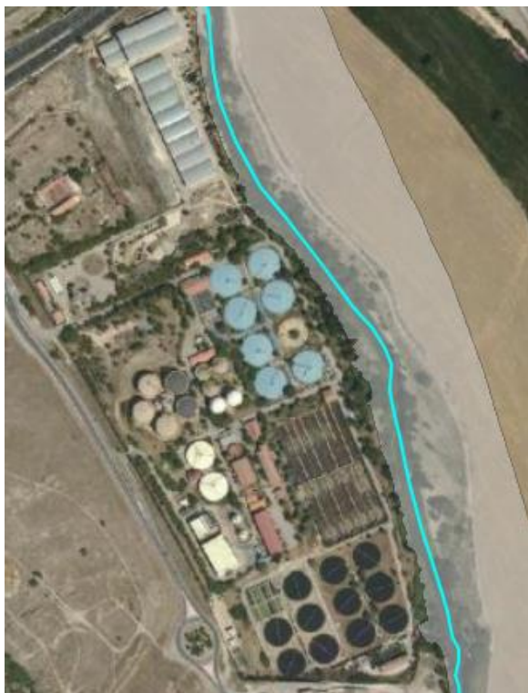
Ilustración 8. EDAR Butarque actual. Zona de Flujo Preferente
