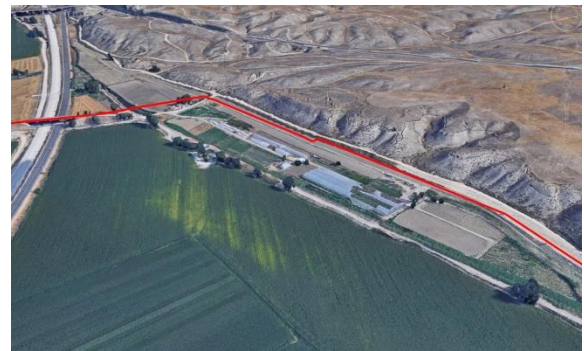
Ilustración 36. La impulsión subterránea continua adyacente al camino existente dirección a la EDAR Sur
