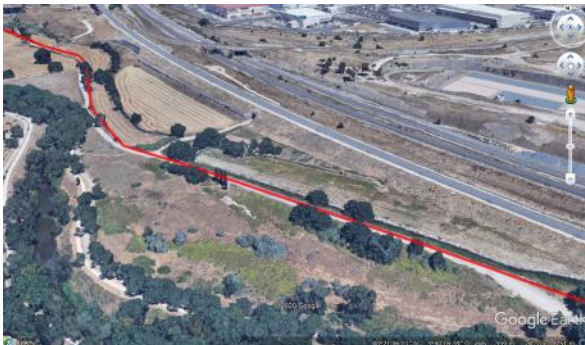
Ilustración 74. Continuación de la impulsión por camino
