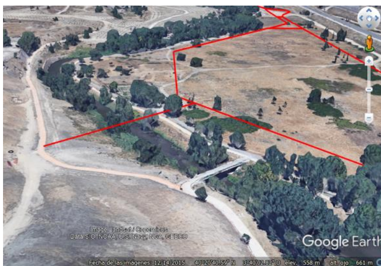
Ilustración 114. Vista del cruce aérea de la conducción de vaciado del tanque de tormentas U2
