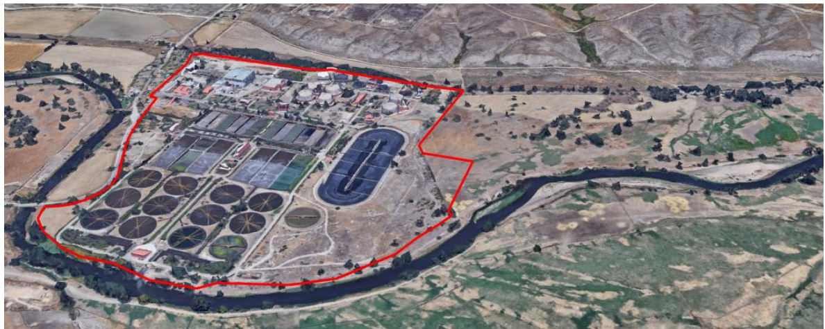
Ilustración 52. Vista general del nuevo perímetro de la EDAR Sur renovada (línea de color rojo)
