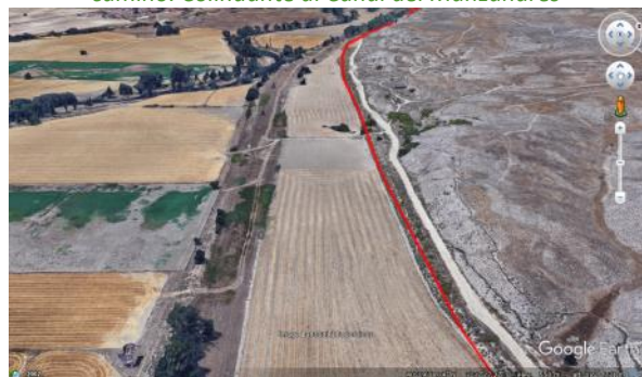
Ilustración 40. Impulsión subterránea junto a talud de camino existente
