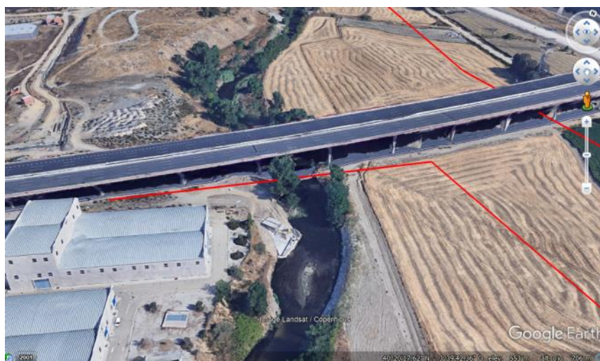
Ilustración 112. Vista de obra de salida de la EDAR existente en margen derecha y a la que previsiblemente llegará el cruce del colector previsto desde margen izquierda
