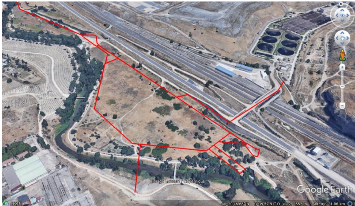
Ilustración 125. Vista de la ubicación del tanque de tormentas U2 con la conducción que va a la EDAR La Gavia y la que cruza el río Manzanares, así como con sus cámaras de reparto y aliviaderos
