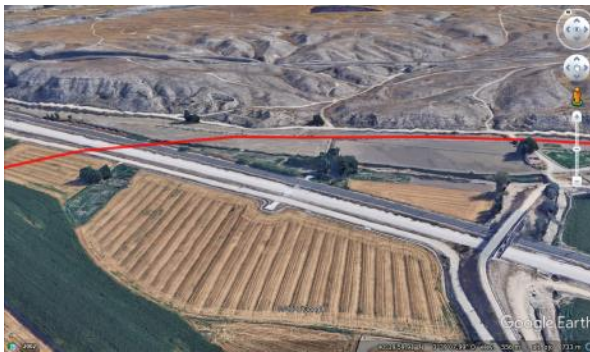
Ilustración 80. Cruce de la impulsión subterránea de la línea de Alta Velocidad (LAV). Y del Canal del Manzanares
