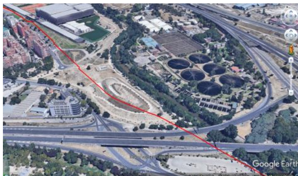
Ilustración 119. Vista del tramo de colector por margen derecha desde figura anterior pasando por una zona verde de reciente ejecución y junto al Tanatorio existente
