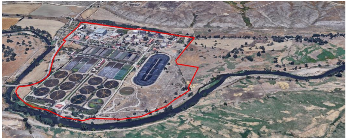
Ilustración 17. Vista general del nuevo perímetro de la EDAR Sur renovada (línea de color rojo)
