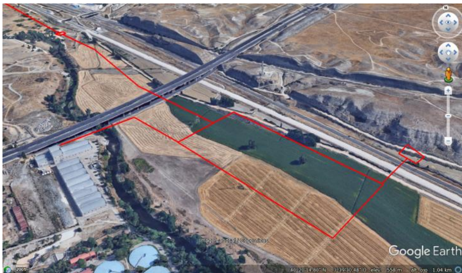
Ilustración 111. Vista del tramo del colector por margen izquierda llegando a la ubicación propuesta para el tanque de tormentas
