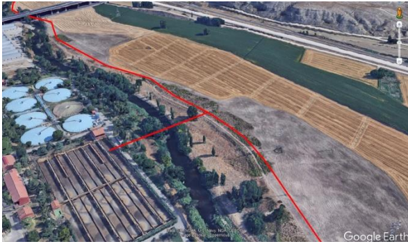
Ilustración 33. Llegada de la impulsión subterránea a la EDAR Butarque. Cruce aéreo del río Manzanares
