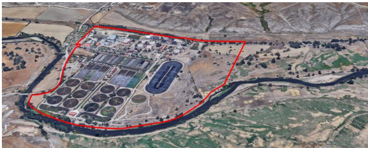
Ilustración 100. Comparación entre la ocupación de la EDAR Sur en las alternativas 2, 3 y 4 (primera foto) y la ocupación en la alternativa 12 (segunda foto)
