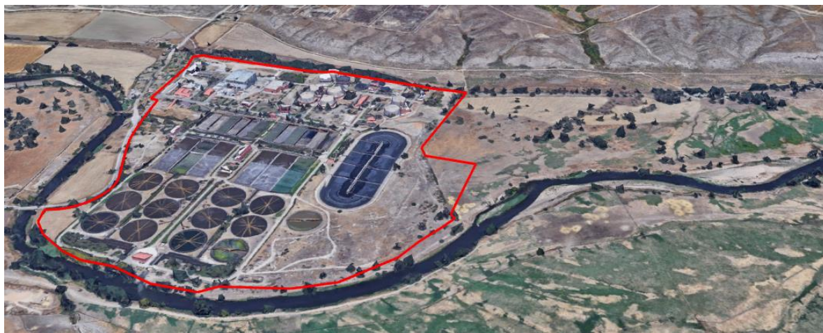
Ilustración 62. Vista general del nuevo perímetro de la EDAR Sur renovada (línea de color rojo)
