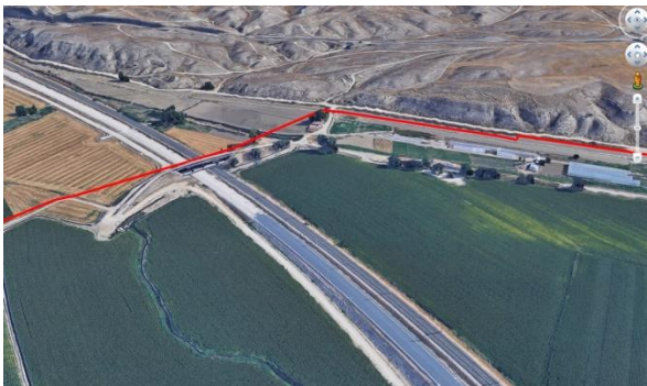
Ilustración 35. Cruce de la impulsión subterránea de la línea de Alta Velocidad (LAV). Y del Canal del Manzanares
