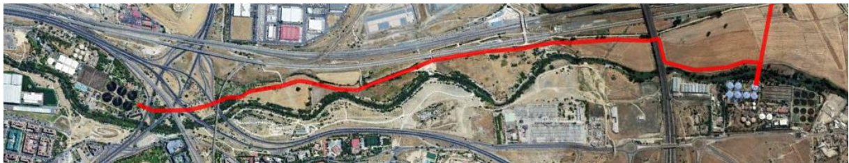
Ilustración 70. Vista del primer tramo del trazado del colector entre la EDAR La China y la EDAR Butarque
