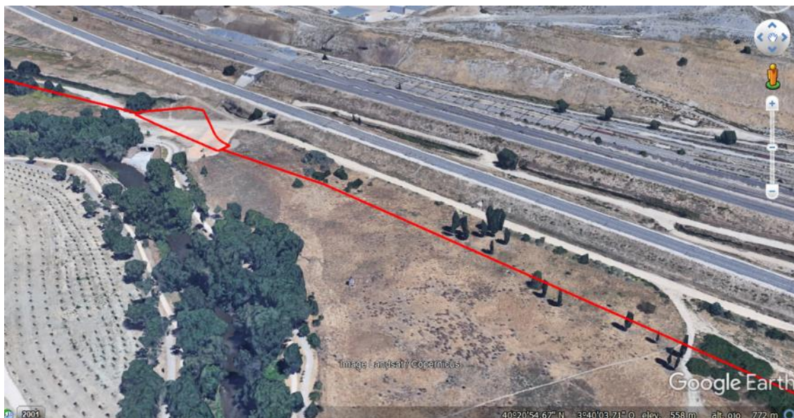
Ilustración 109. Vista del tramo del colector por margen izquierda continuando por los terrenos de cultivo, en dirección sureste, hacia el tanque de tormentas
