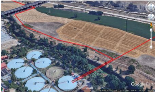
Ilustración 78. Llegada de la impulsión subterránea a la EDAR Butarque. Cruce aéreo del río Manzanares
