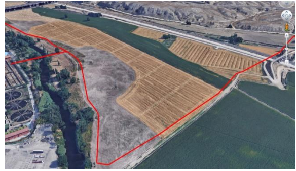
Ilustración 34. Inicio de la impulsión subterránea de fangos hacia EDAR Sur. Cruce aéreo del río Manzanares
