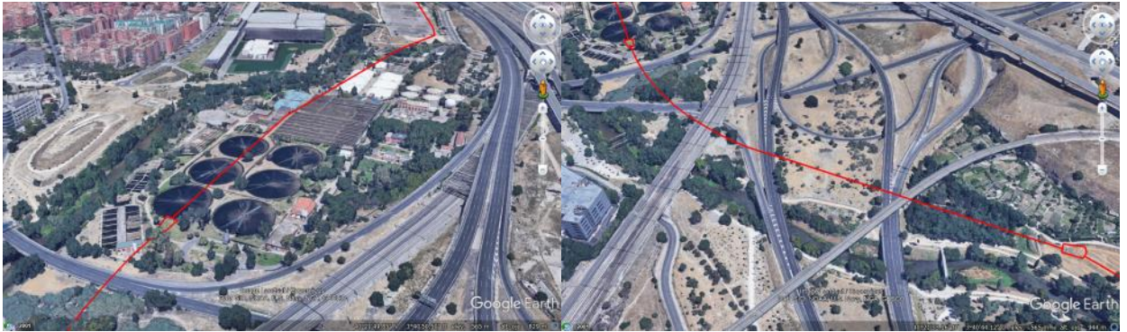
Ilustración 105. Vista del tramo del colector por margen izquierda a su paso por la EDAR de La China
