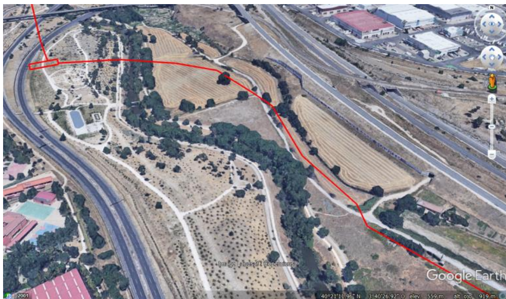
Ilustración 121. Vista del tramo de colector por margen derecha que cruza el río Manzanares para continuar por margen izquierda
