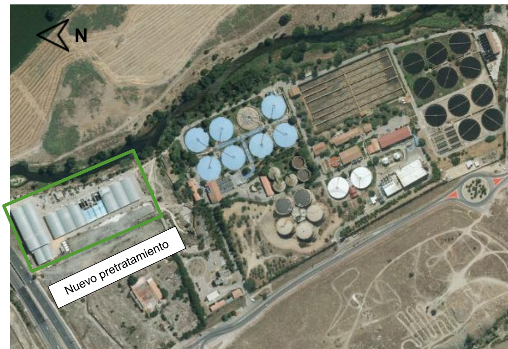
Ilustración 7. EDAR Butarque, planta tomada de ortoimagen.
