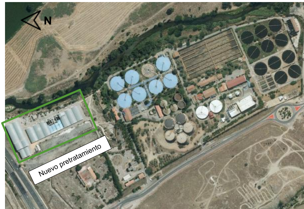
Ilustración 1. EDAR Butarque, planta tomada de ortoimagen.
