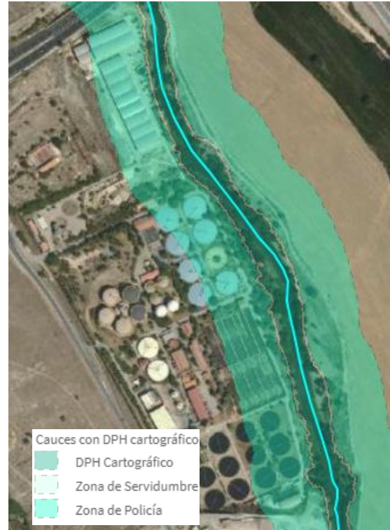
Ilustración 3 EDAR Butarque actual. Dominio Público Hidráulico Cartográfico
