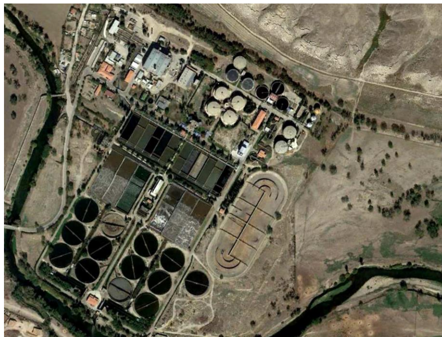
Plano y foto aérea de situación y distribución de equipos de la EDAR Sur
