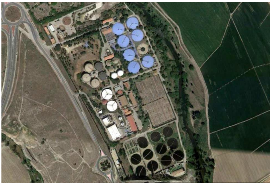
Plano y foto aérea con la situación y distribución de equipos de la EDAR de Butarque
