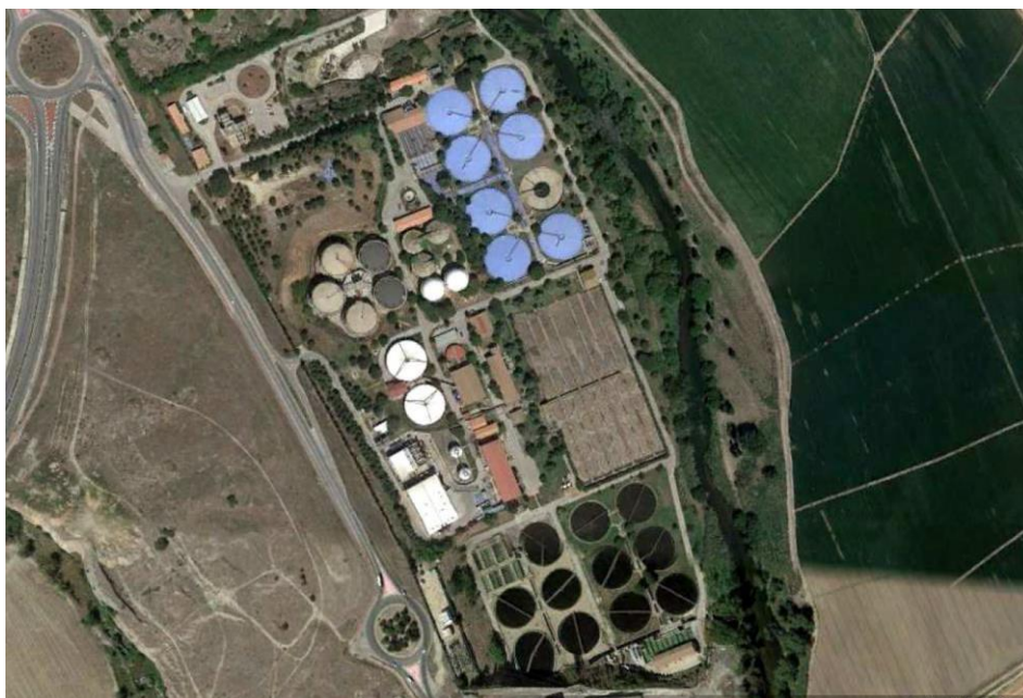
Plano y foto aérea con la situación y distribución de equipos de la EDAR de Butarque
