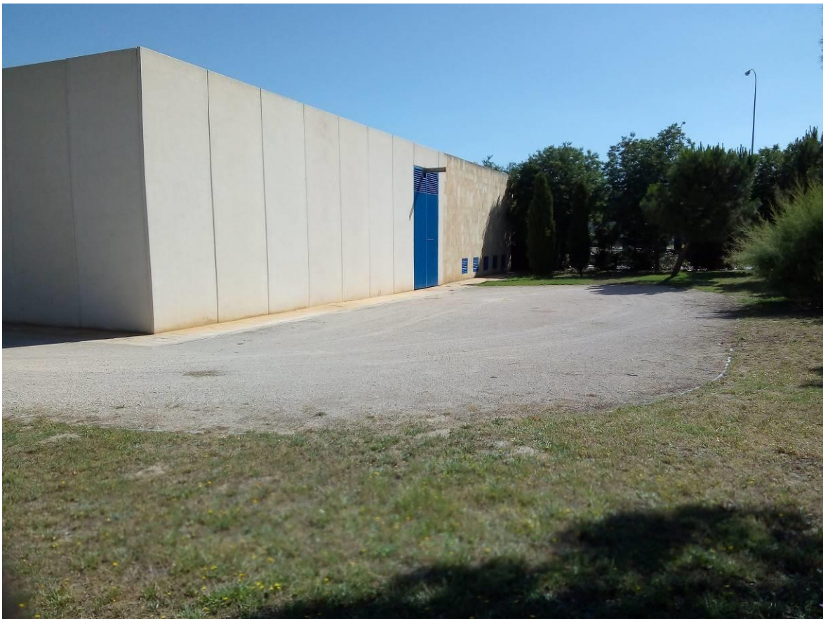
Ilustración 10. Partidor del La China. Vista exterior desde aguas abajo margen derecha.
