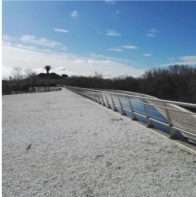
Ilustración 5. AGMI. Vista del forjado superior desde aguas abajo
