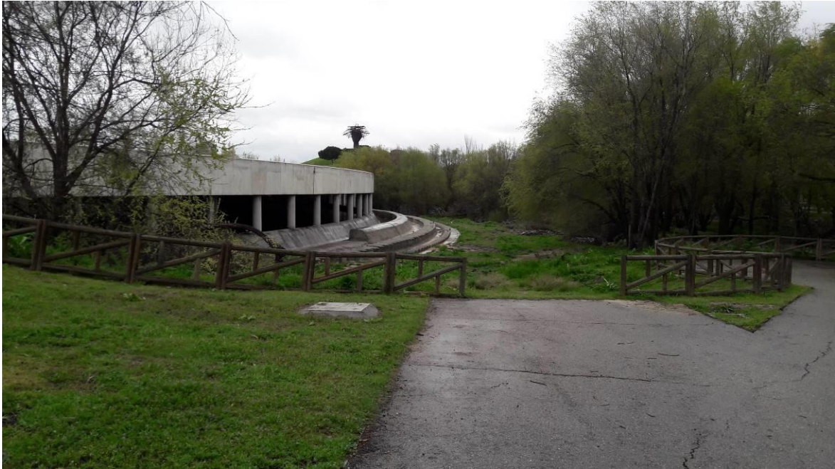
Ilustración 1. Aliviadero General de Margen Izquierda (AGMI). Vista desde aguas arriba
