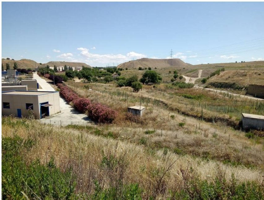
Ilustración 14. Conexión entre el Colector de la Gavia y Colector Sur. A la izquierda de la imagen edificio del bombeo sobre la Gavia y EDAR del La Gavia al fondo.
