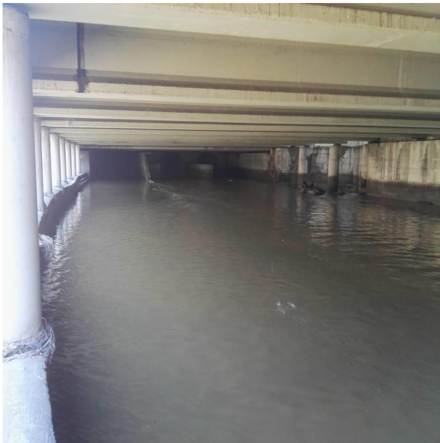
Ilustración 4. AGMI. Vista interior desde agua abajo
