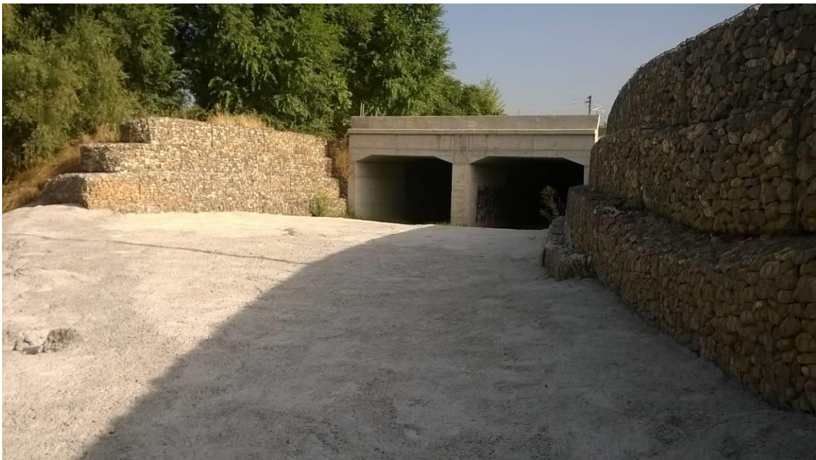
Ilustración 12. Aliviadero de Abroñigales. Salida a cauce de los dos marcos 5x3.5.
