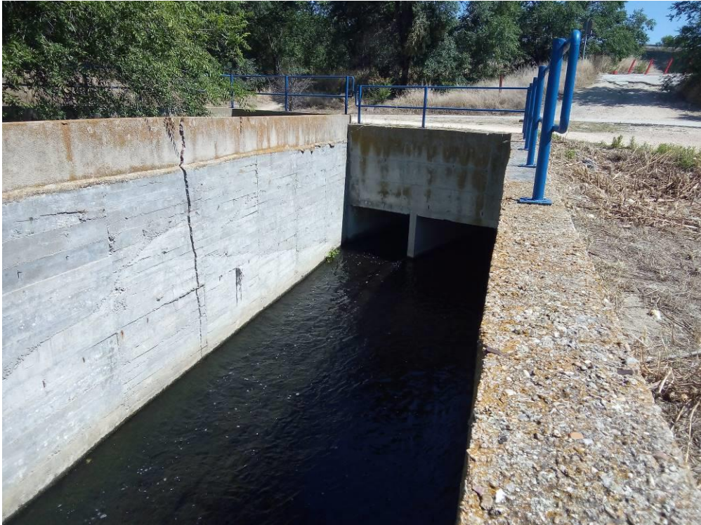
Ilustración 13. Aliviadero de La Gavia. Salida a cauce. En la imagen dos marco de margen izquierda.
