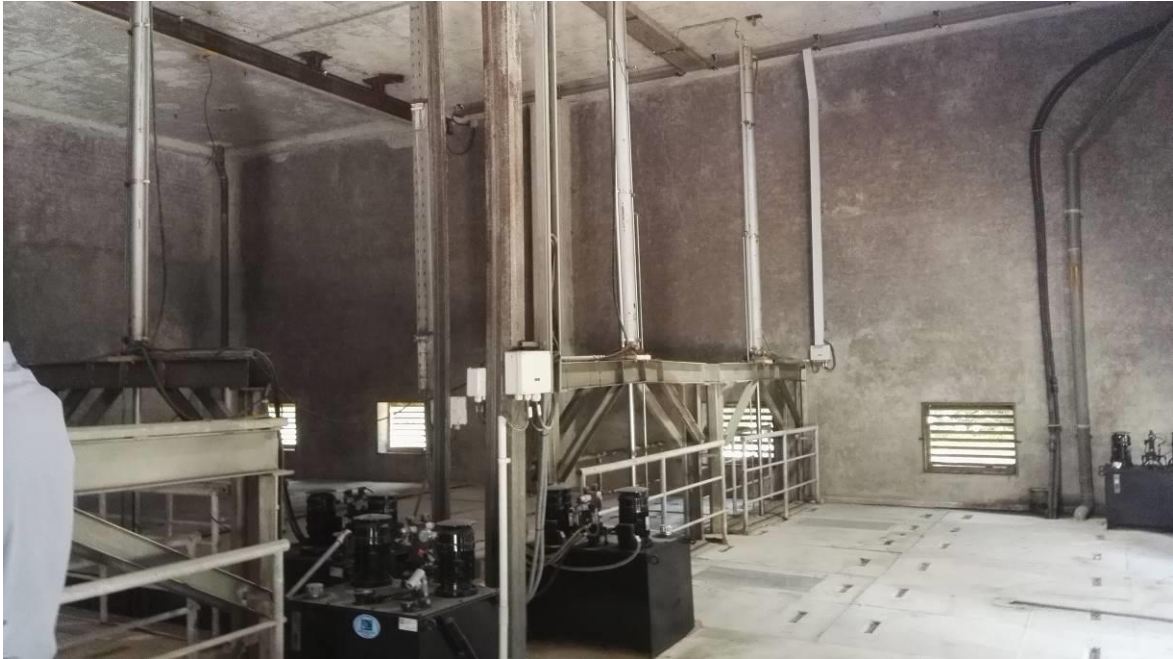
Ilustración 11. Partidor del La China. Vista interior de las compuertas de regulación entre el colector de La China y el Colector Sur actual.
