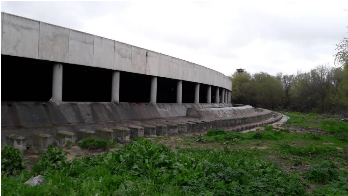
Ilustración 2. AGMI. Vista desde aguas arriba II
