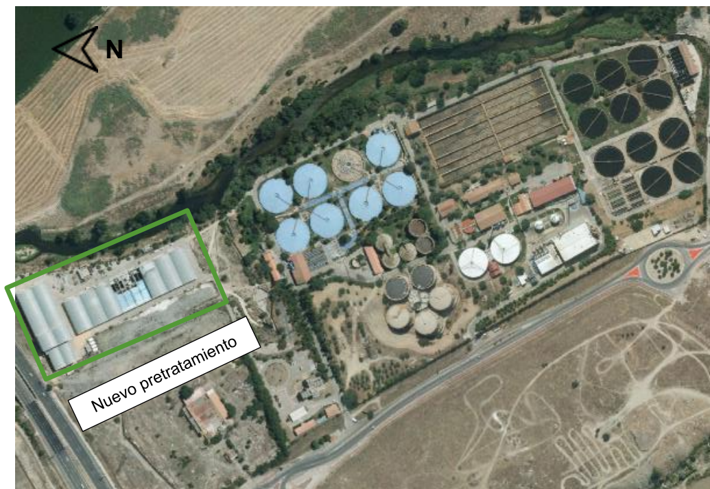
Ilustración 8. EDAR Butarque, planta tomada de ortoimagen.
