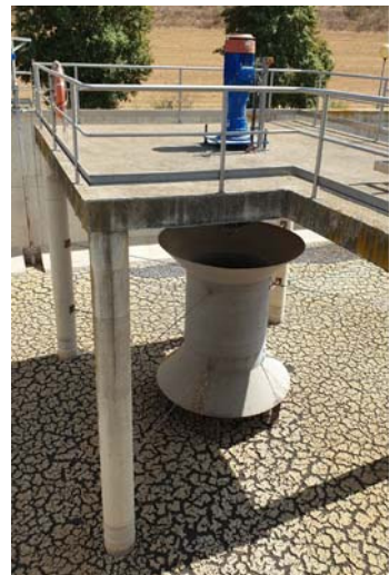
AIREADORES SUPERFICIALES (TURBINAS) (4)
