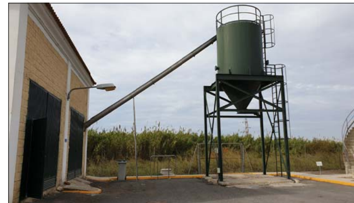
FOTOGRAFÍA 1: SILO DE ALMACENAMIENTO DE FANGOS DESHIDRATADOS
