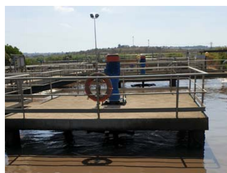
AIREADORES SUPERFICIALES (TURBINAS) (4)
