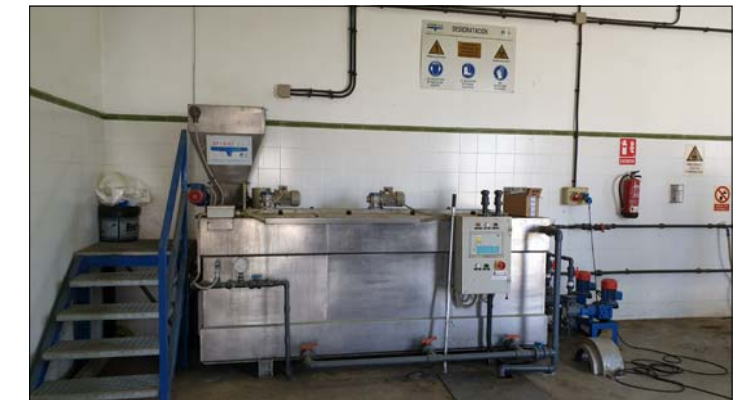
FOTOGRAFÍA 2: GRUPO DE PREPARACIÓN DE POLIELECTROLITO ANIÓNICO
