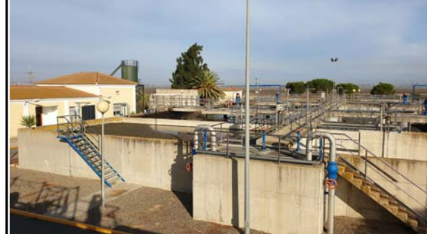
REACTOR BIOLÓGICO. VISTA GENERAL. ZONA ENTRADA (II/II)
