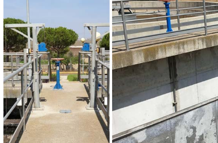
COMPUERTA MURAL. ACCIONAMIENTO MANUAL (7)
