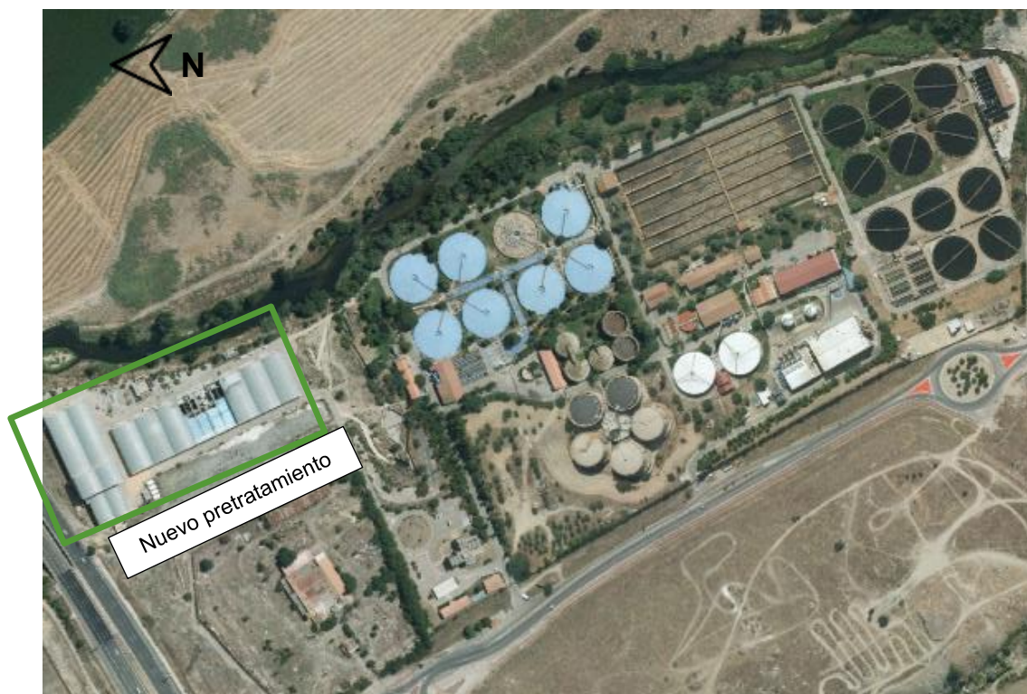
Ilustración 6. EDAR Butarque, planta tomada de ortoimagen.
