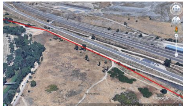
Ilustración 134. Impulsión subterránea por camino
