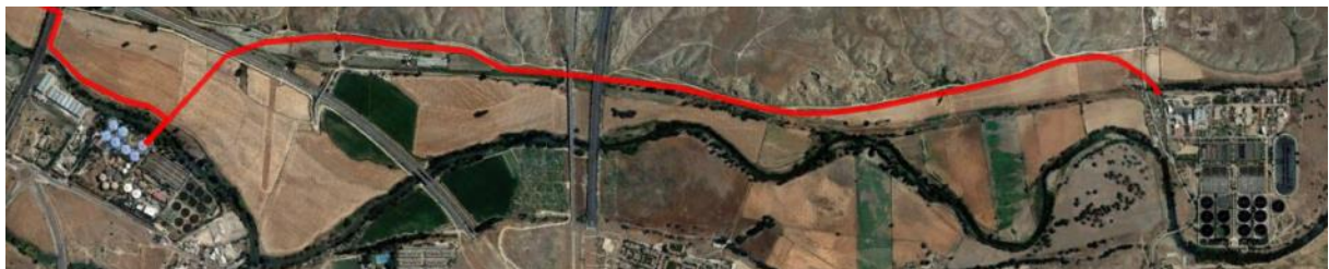
Ilustración 130. Vista del segundo tramo del trazado del colector entre la EDAR Butarque y la EDAR Sur
