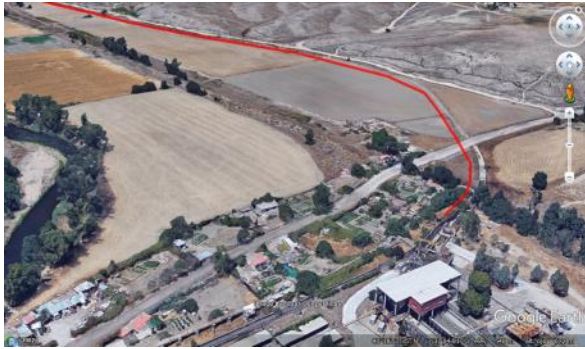
Ilustración 145. Llegada de la impulsión subterránea a la EDAR Sur
