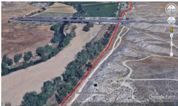
Ilustración 142. Impulsión subterránea por el pie de talud del camino. Colindante al Canal del Manzanares
