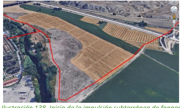
Ilustración 138. Inicio de la impulsión subterránea de fangos hacia EDAR Sur. Cruce aéreo del río Manzanares
