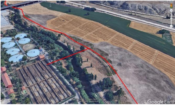
Ilustración 137. Llegada de la impulsión subterránea a la EDAR Butarque. Cruce aéreo del río Manzanares
