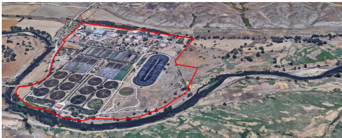
Ilustración 121. Vista general del nuevo perímetro de la EDAR Sur renovada (línea de color rojo)
