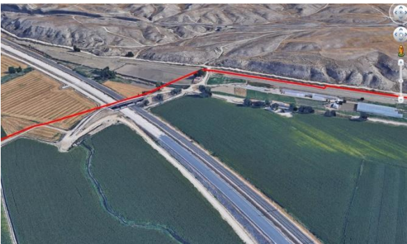
Ilustración 139. Cruce de la impulsión subterránea de la línea de Alta Velocidad (LAV). Y del Canal del Manzanares
