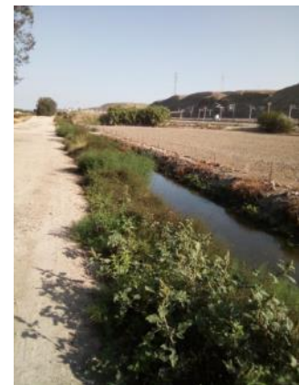
Ilustración 88. Vista del estado actual del Canal del Manzanares junto a camino
