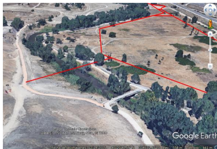
Ilustración 162. Vista del cruce aéreo de la conducción de vaciado del tanque de tormentas U2
