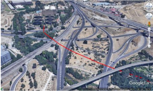
Ilustración 131. Salida de la impulsión de la EDAR La China y cruce del nudo viario y ferroviario
