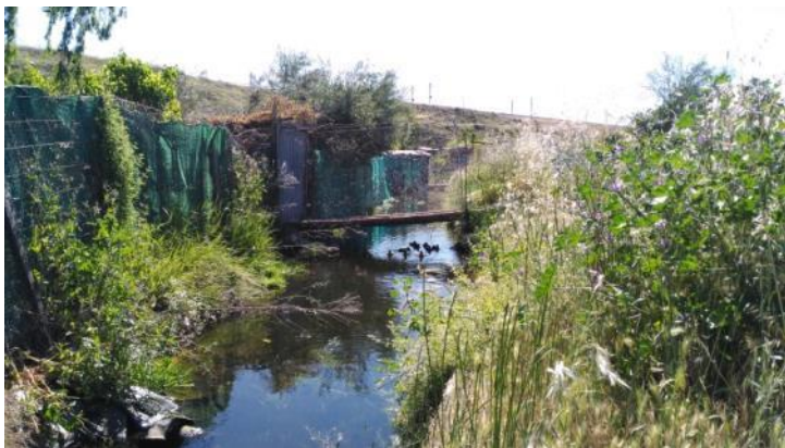
Ilustración 87. Vista del estado actual del Canal del Manzanares en zona entre huertos
