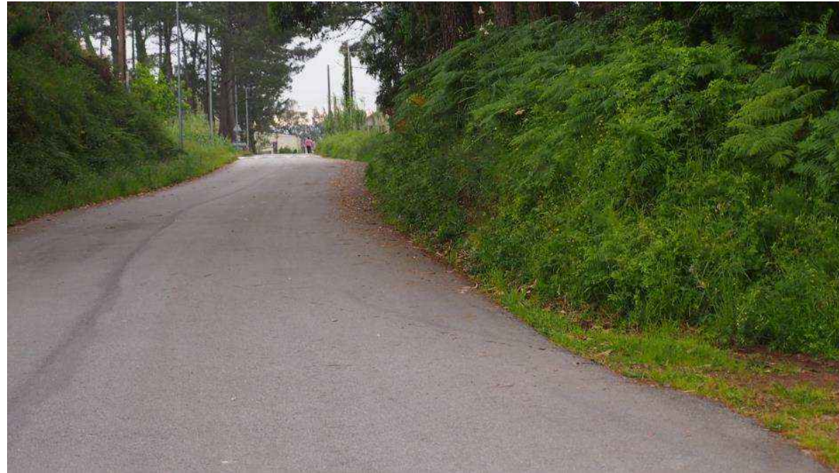
Tramo de nueva impulsión
