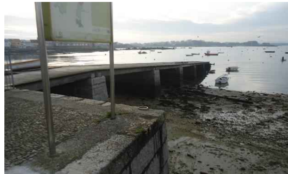
Imagen 8. Rampa Muelle de Pau. Debajo de dicha rampa colector-emisario PVC DN-400
