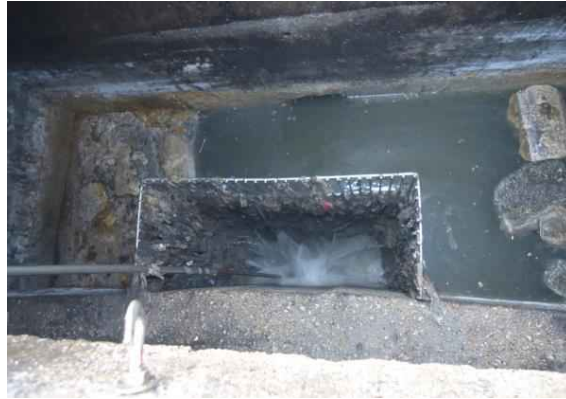
Imagen 16. EBAR Praza do Regueiro Desbaste
