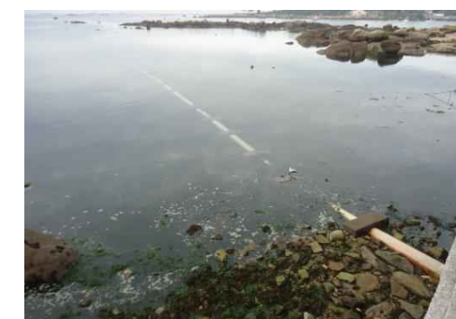
Imagen 15. Salida Pluviales Bombeo Praza do Regueiro H-500
