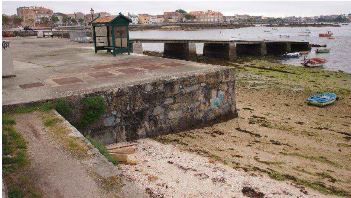
Ubicación y estado actual de la EBAR a reconfigurar
