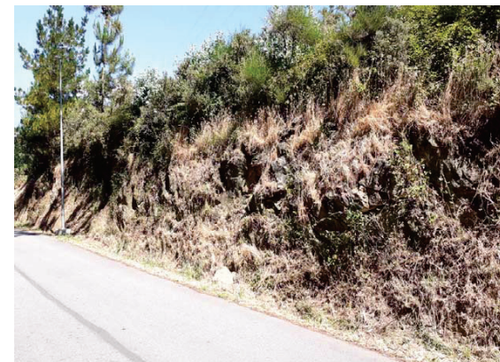
Afloramiento de sustrato rocoso moderadamente alterado (Grado de alteración III), en zona por donde discurrirá la canalización de impulsión. Altura de talud estimada ~ 3,00 metros.
