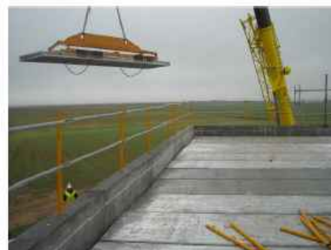
FINZA PARA TRANSPORTE DE PLACA ALVEOLAR
