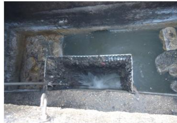
Imagen 9. EBAR Praza do Regueiro Desbaste
