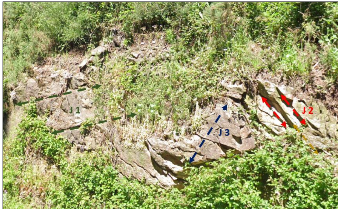
Imagen 7: Identificación de las familias de litoclasas J1, J2 y J3, en los afloramientos rocosos del talud de la carretera adyacente a la parcela de la EDAR
