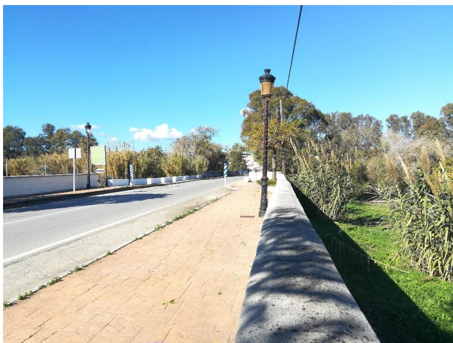
Zona de cruce en la carretera A-2102 (en las proximidades del puente sobre el río Guadiaro).
