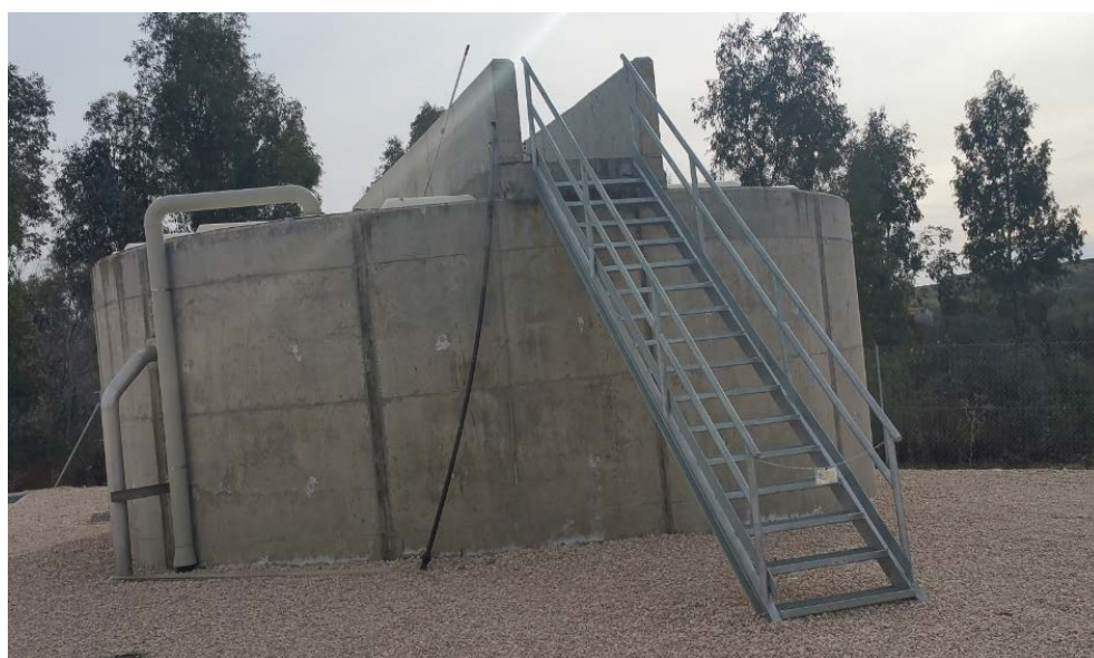
Espesador EDAR Aznalcóllar (Fuente: fabricante)
