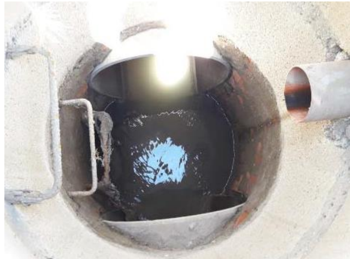
Pozo previo al vertido del PV1 en el que se llevó a cabo la campaña de aforos y toma de muestras
