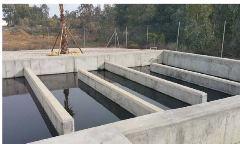
Laberinto de cloración EDAR Aznalcóllar (Fuente: elaboración propia)
