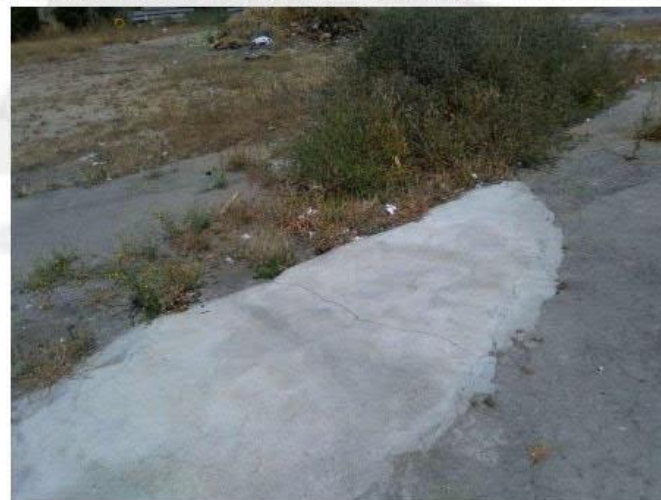
En la fotografía se observa el punto dónde debería encontrarse el pozo indicado por IDOM.
