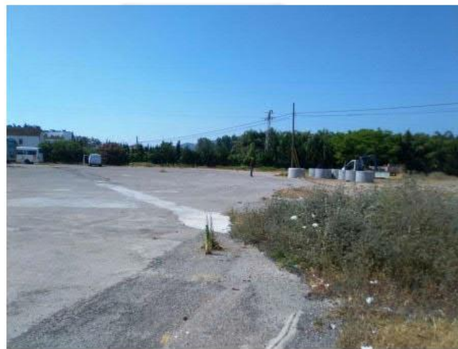
Fotografía de la explanada dónde se encuentra el pozo de registro anterior al punto de vertido. En la fotografía se observa el punto dónde debería encontrarse el pozo indicado por IDOM.
