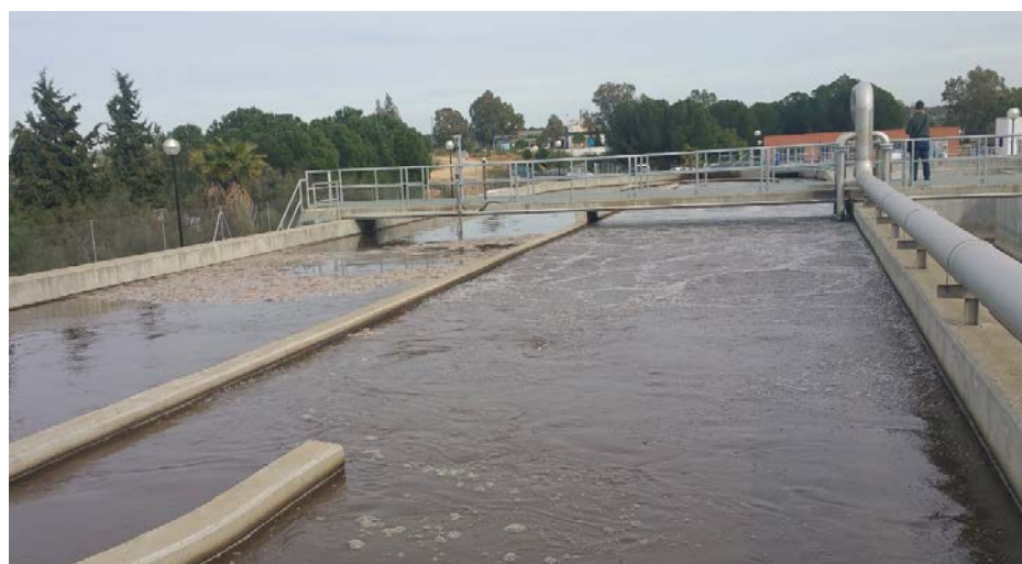
Reactor biológico EDAR Aznalcóllar (Fuente: elaboración propia)
