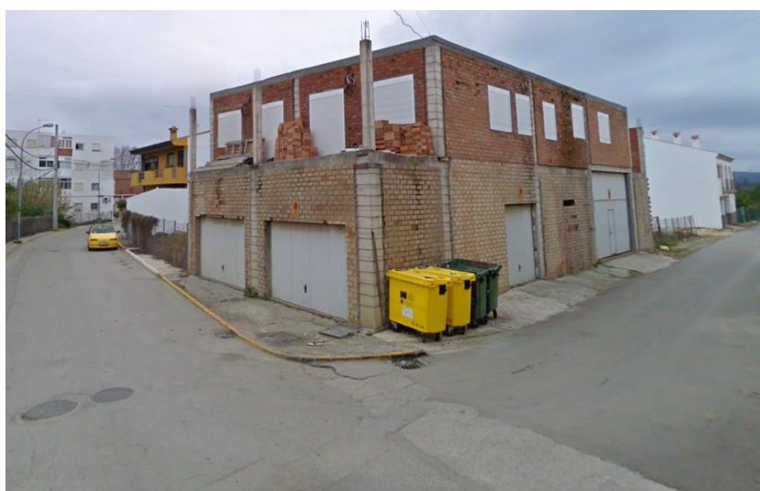
Intersección calle Las Vegas con calle Málaga. Afectación por proximidad tramo I2
