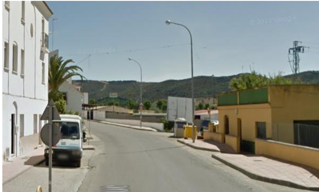
Calle San Roque: colector de 300 mm afectado por el trazado del colector de impulsión.
