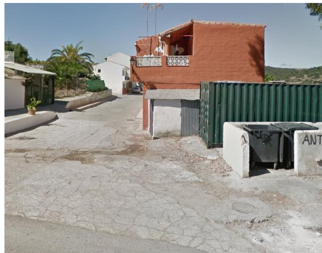
Calle San Martín: colector de 400 mm afectado por el trazado del colector de impulsión.
