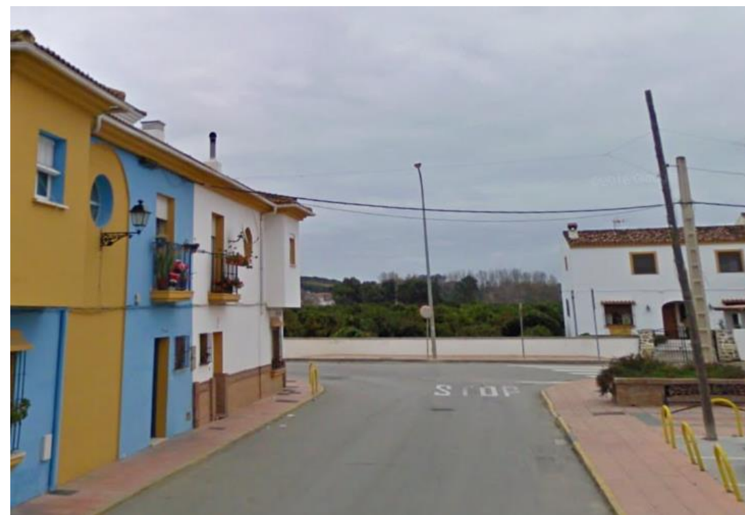
Calle Las Vegas: colector de 300 mm afectado por el trazado del colector de impulsión.
