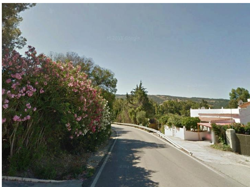
Calle San Martín: Afectación por proximidad tramo I2
