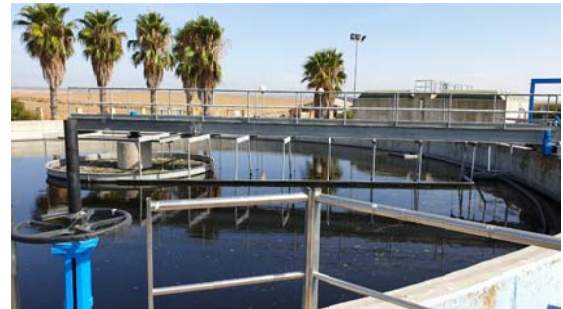
VÁLVULA DE GUILLOTINA. ACCIONAMIENTO MANUAL (4)
