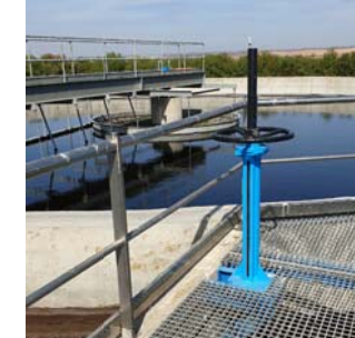
VÁLVULA DE GUILLOTINA. ACCIONAMIENTO MANUAL (8)
