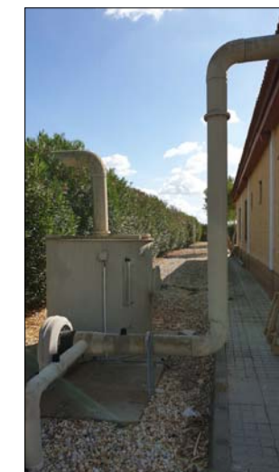
FOTOGRAFÍA 6: DESODORIZACIÓN POR CARBÓN ACTIVO
