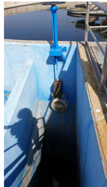
VÁLVULA DE GUILLOTINA. ACCIONAMIENTO MANUAL (4)
