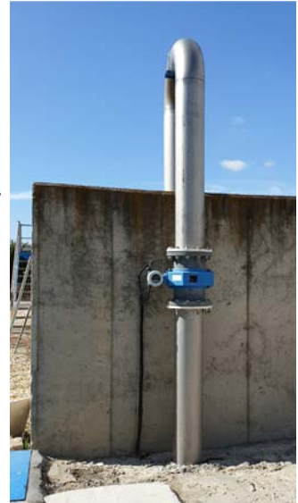
MEDIDOR ELECTROMAGNÉTICO FANGOS EN RECIRCULACIÓN (10)
