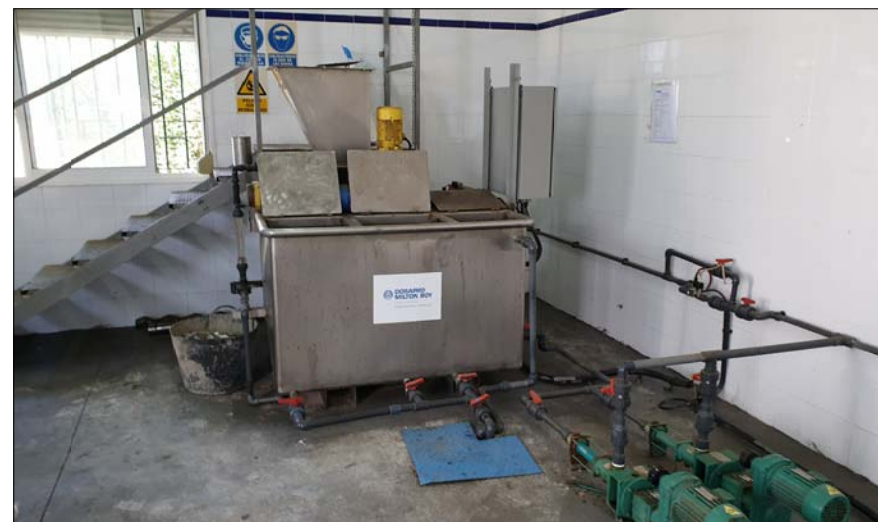
FOTOGRAFÍA 4: GRUPO DE PREPARACIÓN DE POLIELECTROLITO ANIÓNICO Y BOMBEO
