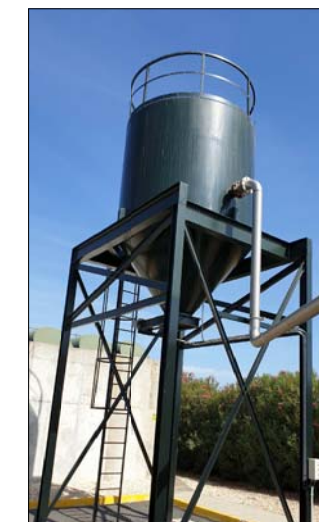
FOTOGRAFÍA 5: SILO DE ALMACENAMIENTO DE FANGOS
