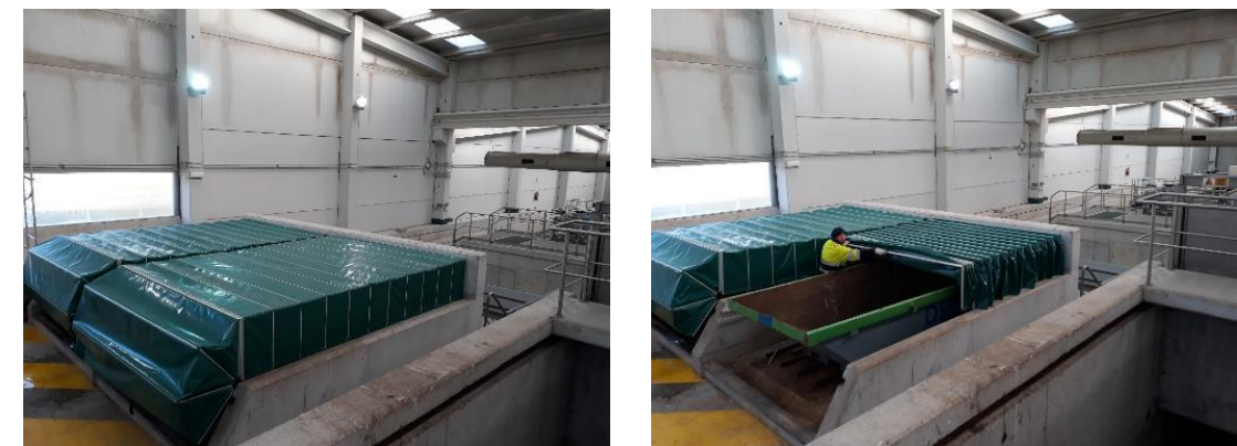
Cubierta retráctil para contenedor de residuos de pozo de gruesos. Cerrada y abriendo.
