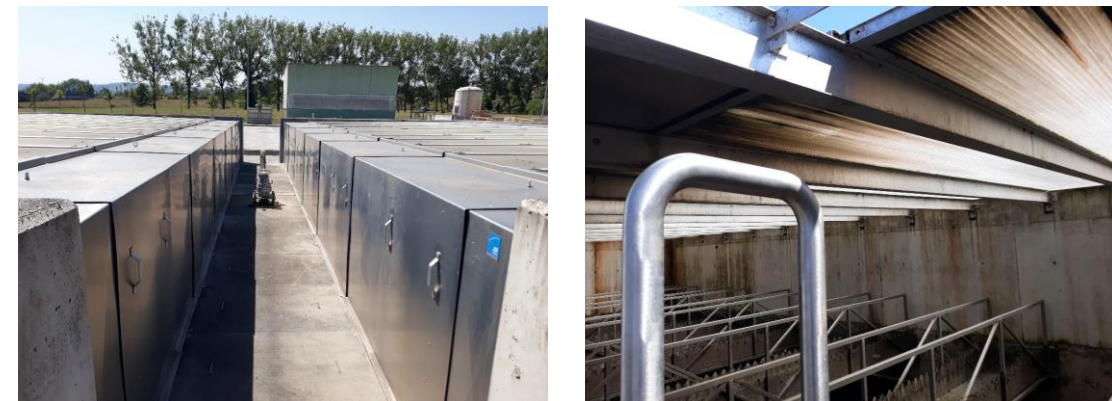
Vistas exterior e interior de la cubierta del decantador lamelar
