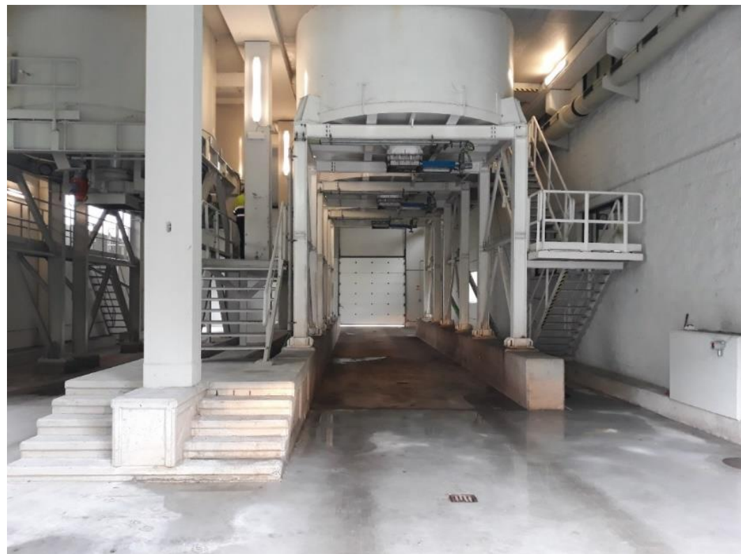
Vista del túnel de descarga de silos
