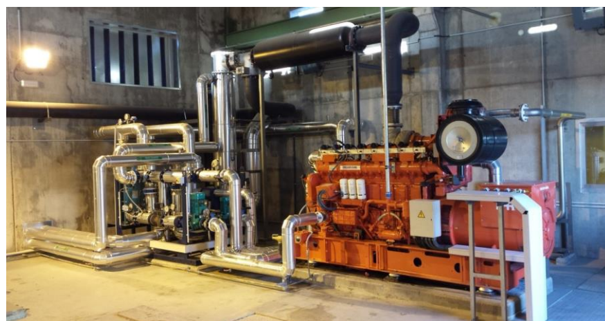
EDAR Torrejón de Ardoz
