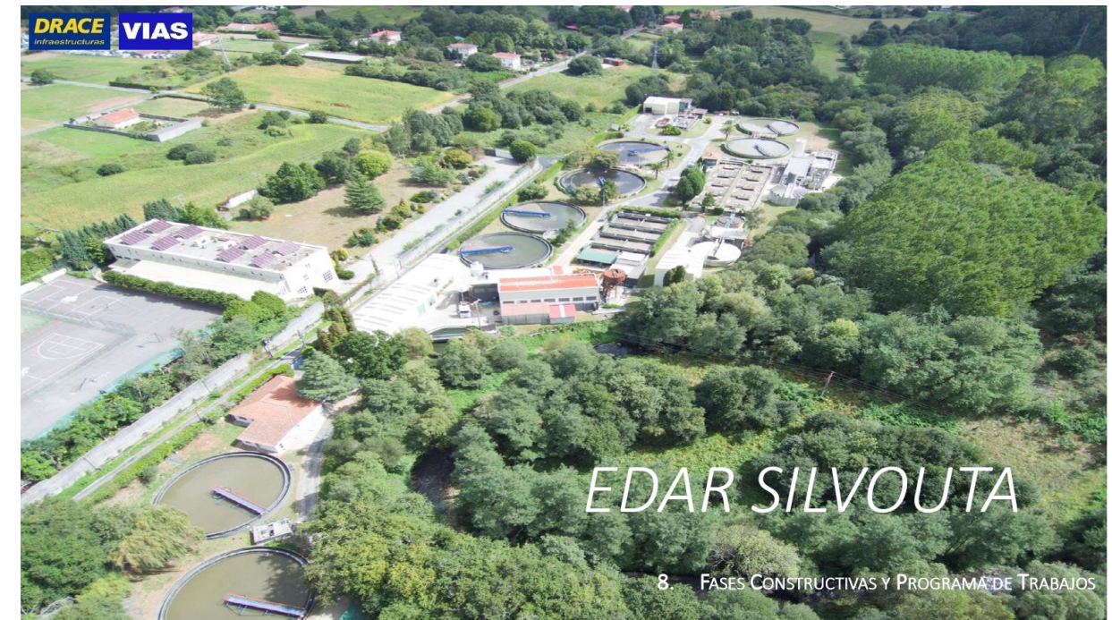
Vista aérea actual EDAR Silvouta
