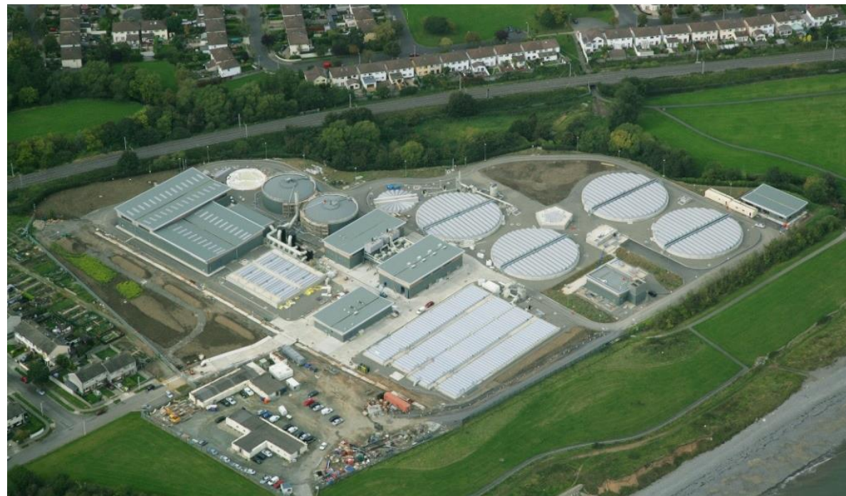
EDAR Shanganagh – Vista aérea de cubriciones – 1 UOE/m3 en límite de parcela
