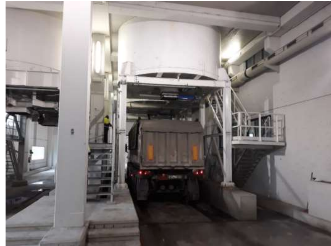
Operación de carga de camión
