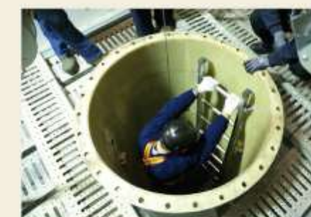
Acceso a un espacio confinado
