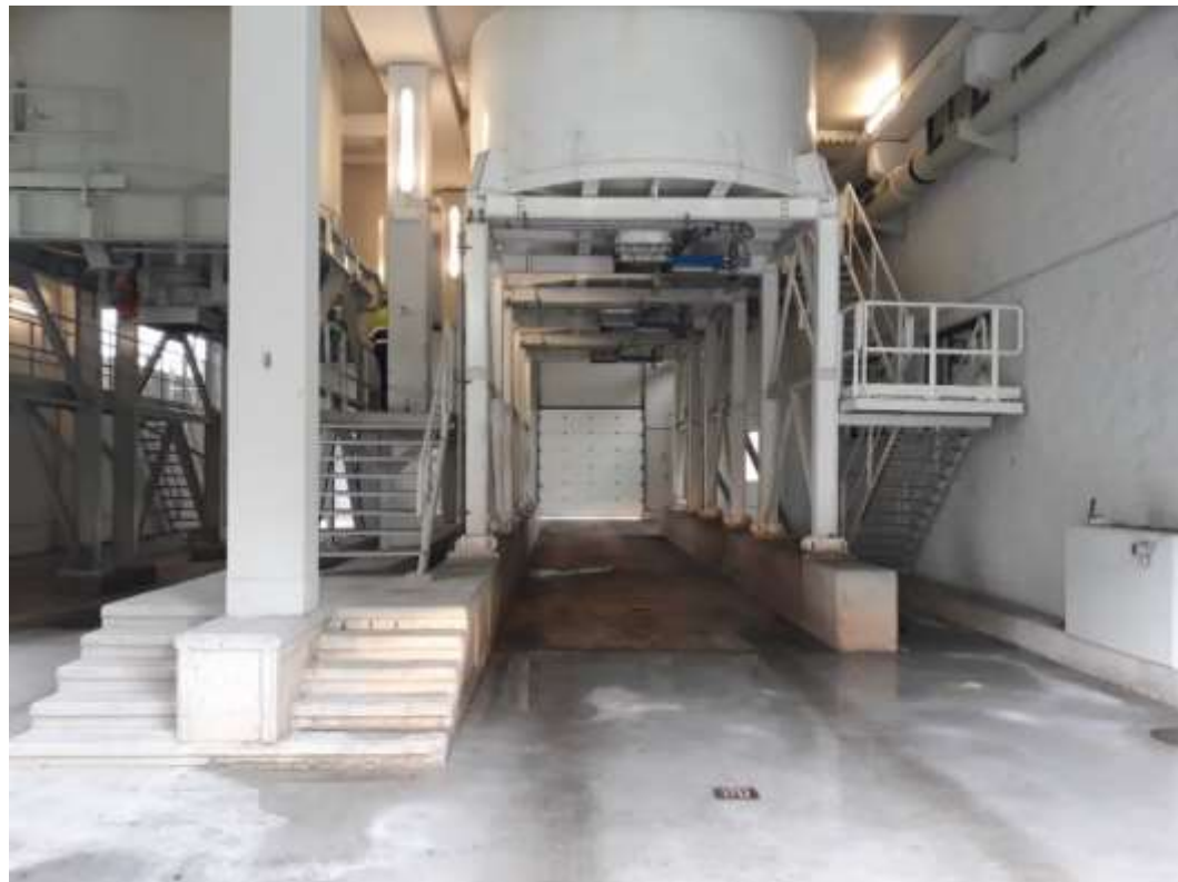
Vista del túnel de descarga de silos
