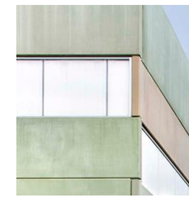
Combinación de panel de hormigón prefabricado y policarbonato celular
