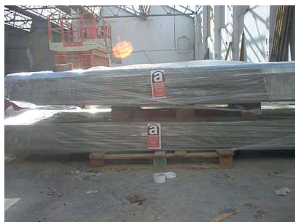
Detalles de Macroencapsulado y etiquetado de amianto.
