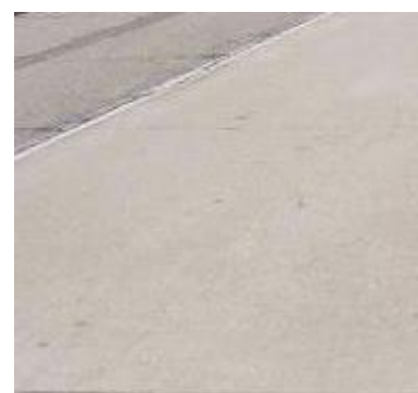
Pavimento de hormigón
