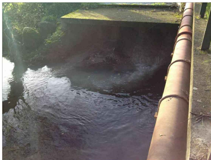
FOTO 2. Alivio en colector existente en Laraño.
