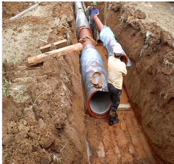
Instalación de colector
