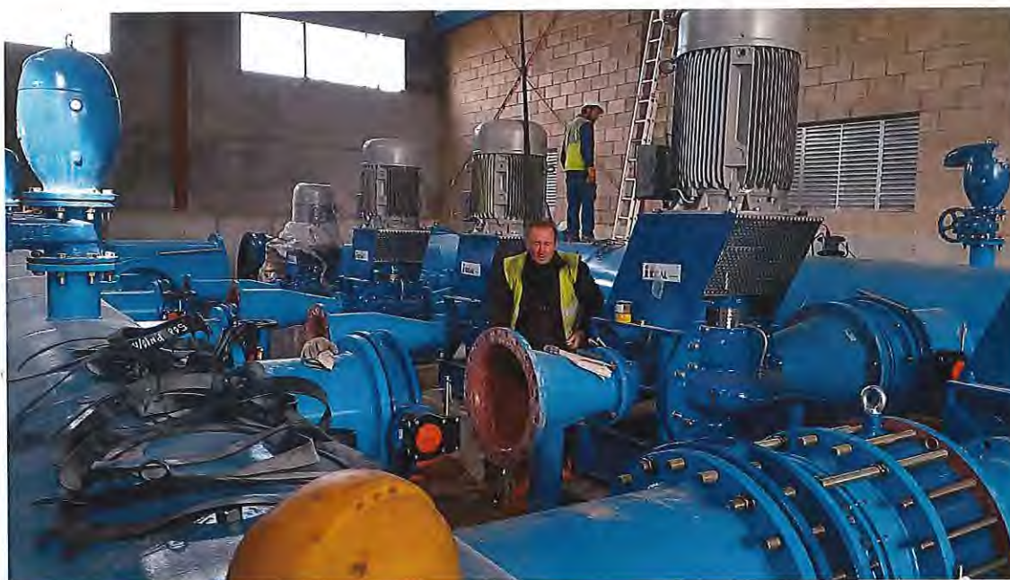
Imagen del momento de la construcción en las infraestructuras de la obra, a las afueras de la localidad
