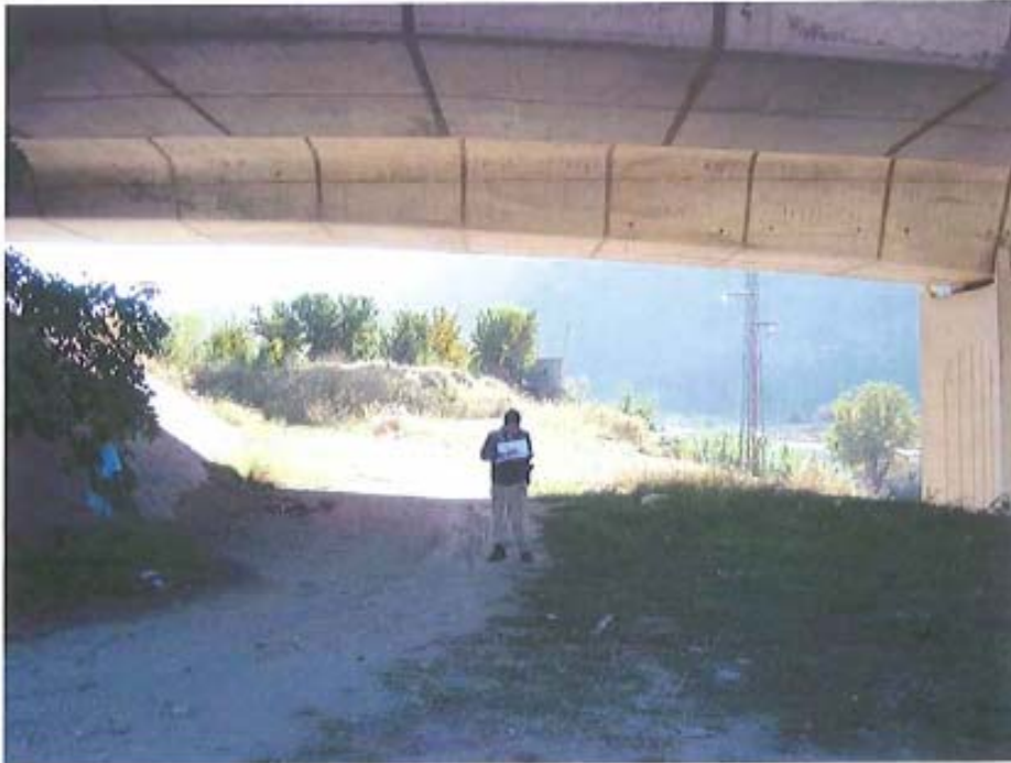
II.7.- Paso bajo el puente de la Ronda Sur
