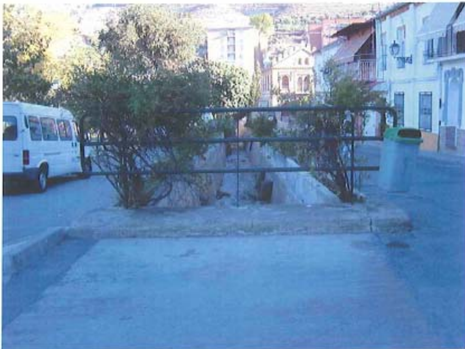
I.6.- Tramo entre el vial y la arqueta de entrada al río
