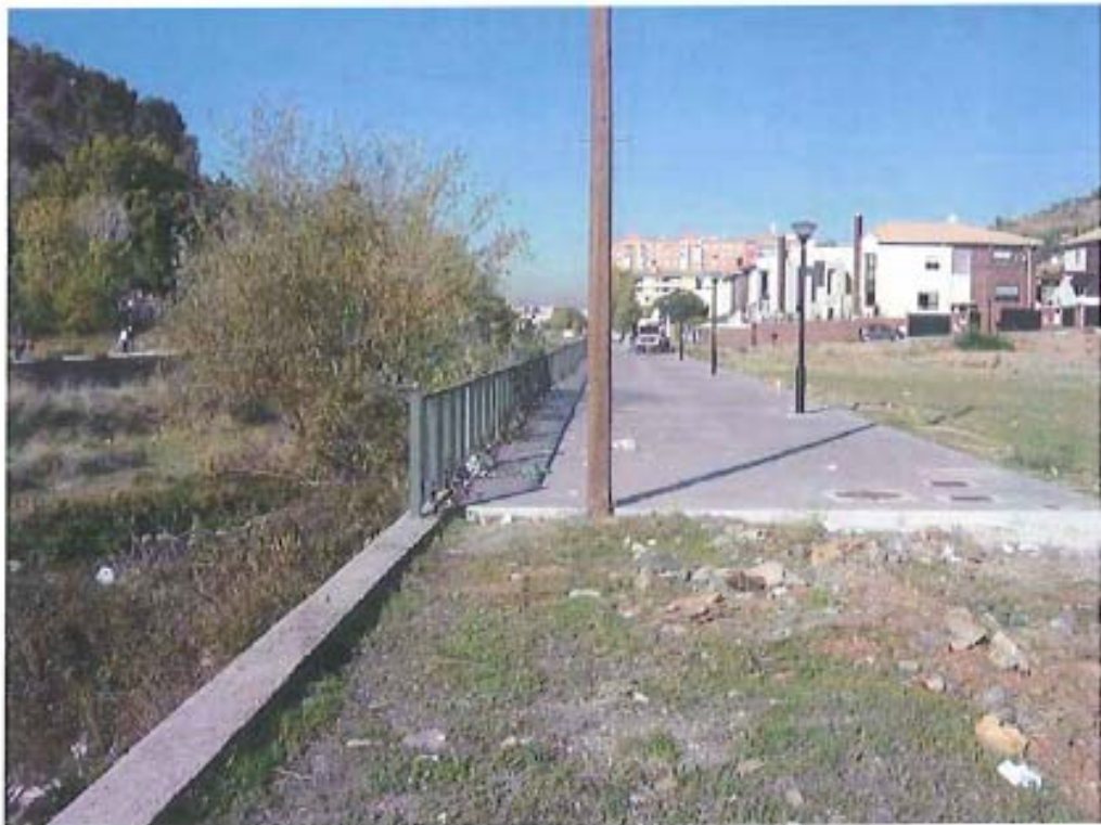
II.4.- Fin del tramo acondicionado en suelo urbano
