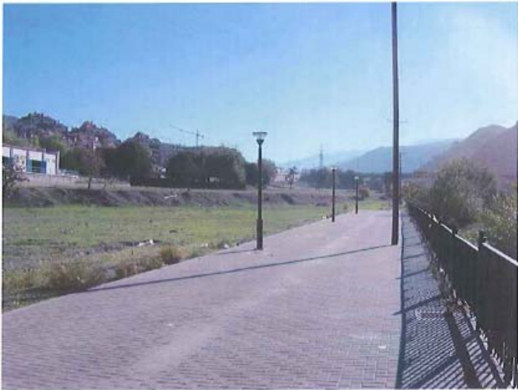
II.3.- Tramo del camino ya acondicionado en suelo urbano equipamiento
