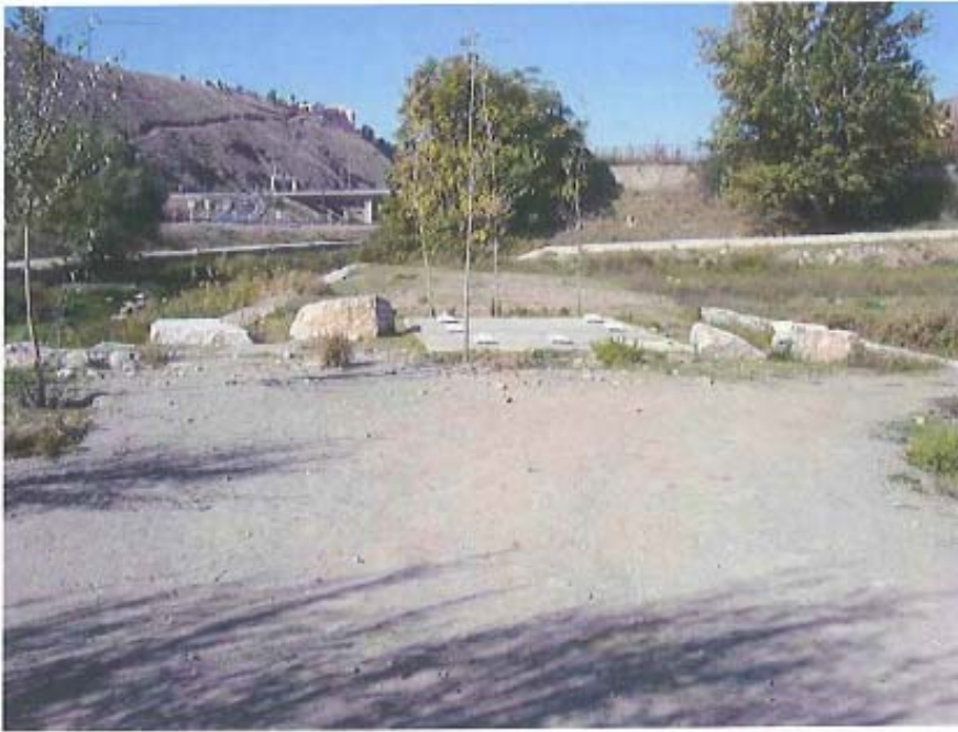
II.9.- Fin del tramo a acondicionar. Arqueta de Loaysa
