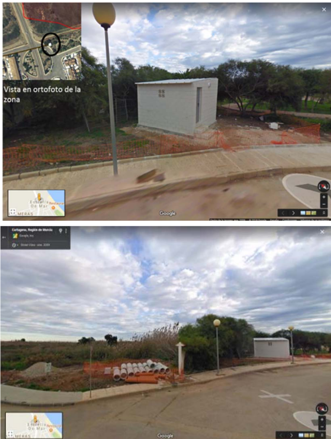
Figura: Vista del trazado de las conducciones y transporte a planta de tratamiento (zona Sur) en el entorno del núcleo de población Estrella de Mar y la ZEPA “Mar Menor”. Fuente: Google Street View.
