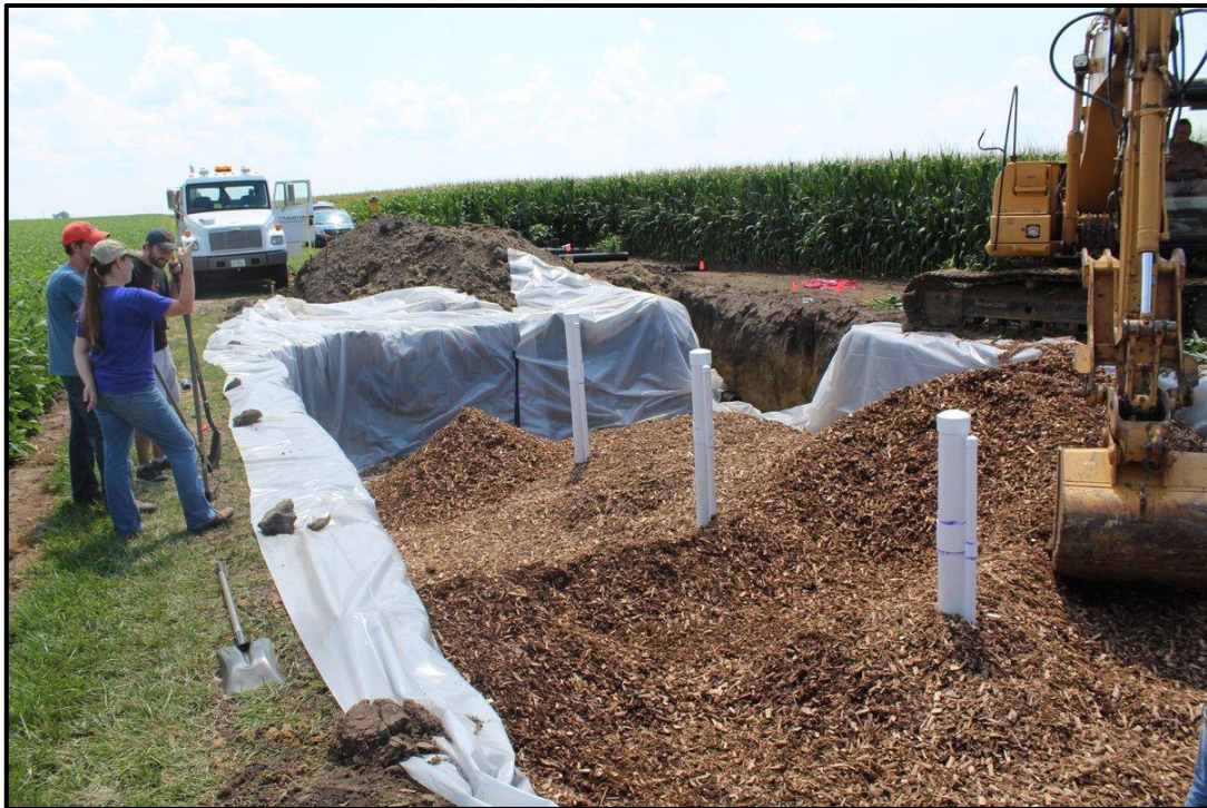
Figura 3. Relleno de un biorreactor con astillas de madera (EEUU). Foto: Janith M. Chadrasoma.
