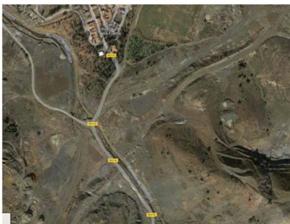
Figura 148: Ejemplo de tramo de posible emplazamiento de diques de retención y plazoletas de sedimentos, aguas arriba del encauzamiento de la rambla de Mendoza (o del Beal), al sur de El Llano del Beal.
