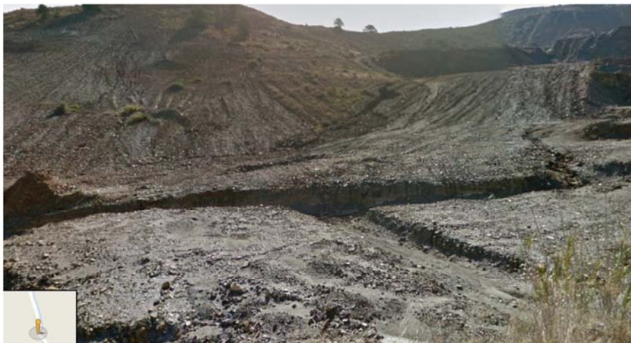
Figura 150: Coladas de sedimentos en el tramo superior del encauzamiento de la rambla del Beal
