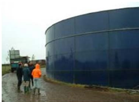
Figura: Tanque de almacenamiento de purines
