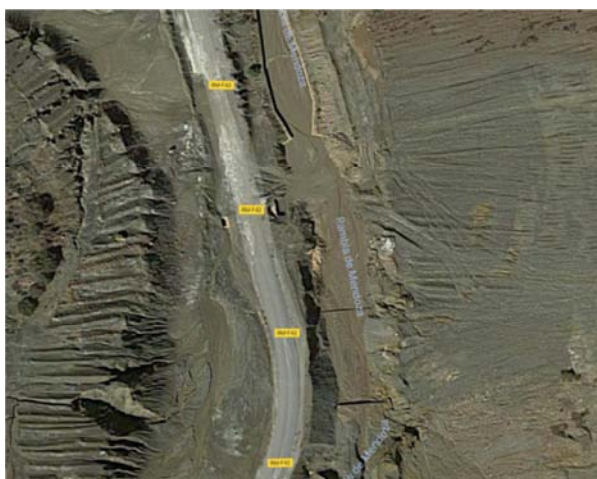
Figura 149: Tramo superior del encauzamiento de la rambla del Beal, aterrado
