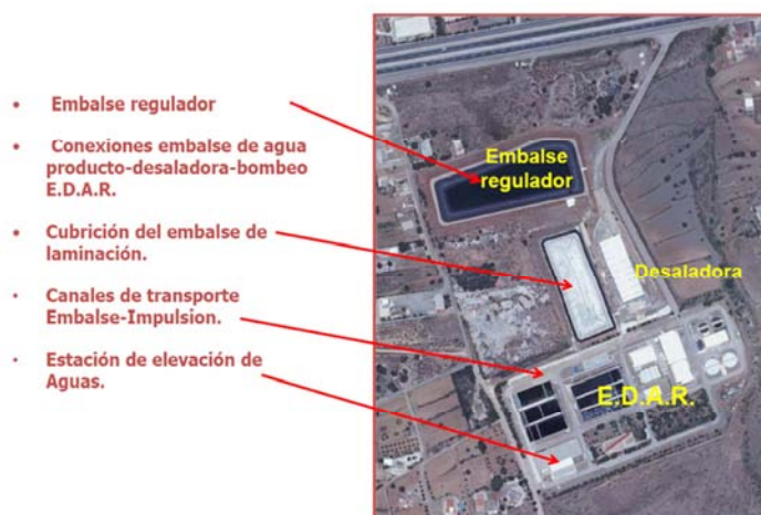
Figura 140: Vista general de la Instalaciones de Arco Sur.
