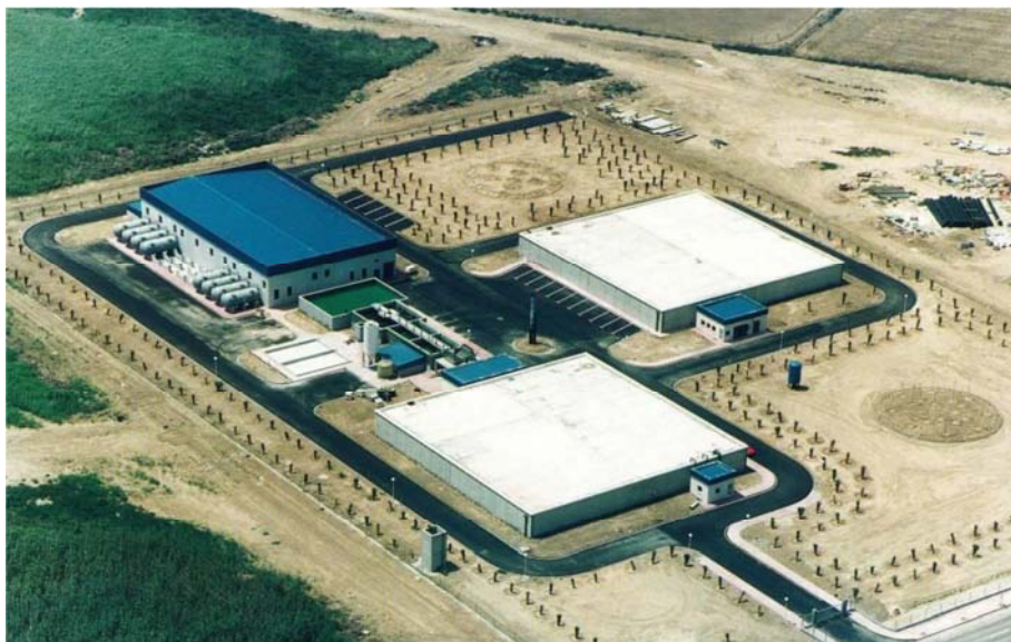
Figura 139: Vista general de la Planta Desalobradora de El Mojón
