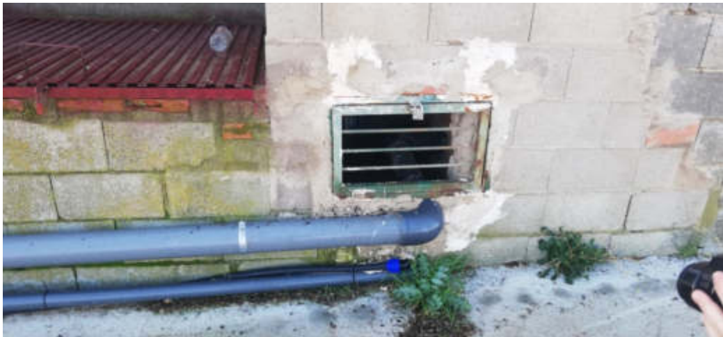
Figura 4.10. Correcto. Registro en el centro. La captación en la arqueta a la izquierda.
