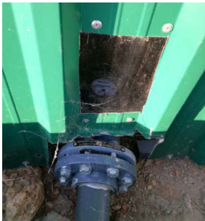
Figura 4.9. Correcto. Ventana tapada con metacrilato. Se aconseja vigilar suciedad en la misma.
