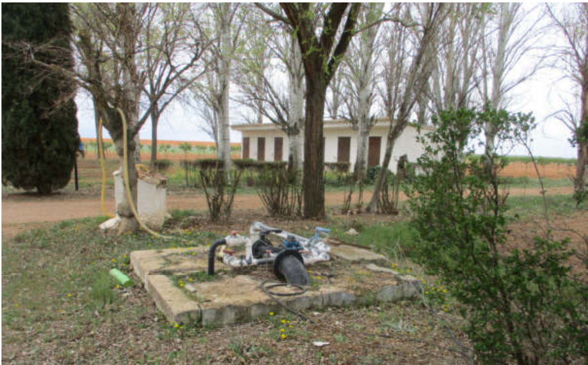
Figura 6.1. Contador accesible. Si se decide cerrar el complejo debe diseñarse el sistema que permita garantizar la accesibilidad del contador.
