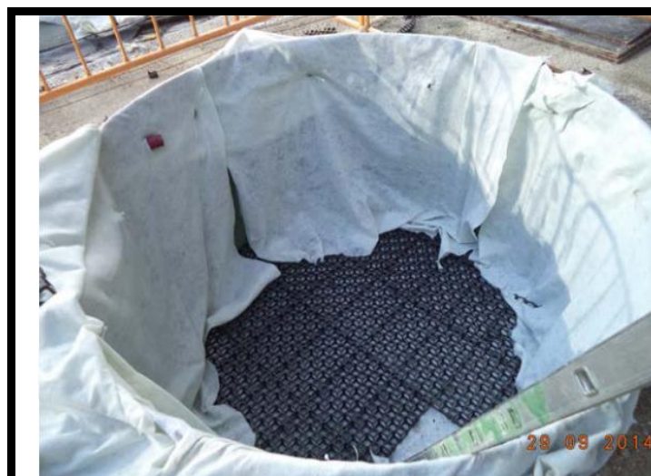
Celdas drenantes Atlantis en interior alcorque. Nueva Sede BBVA en el Barrio de Las Tablas Madrid (Fase I y Fase II). Años 2013-2015. Cortesía de «SUDS S.L - Atlantis».
