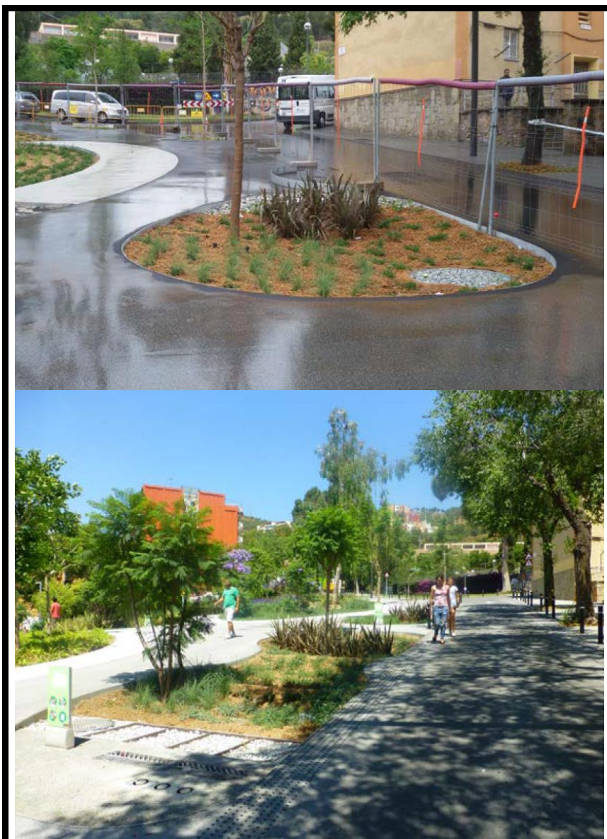
Jardín de lluvia. Transformación de un patio-aparcamiento en un parque en el Barrio Les Roquetes, Distrito Nou Barris (Barcelona). Bordillos enrasados para que el agua pluvial de escorrentía vierta a las zonas terrizas, y cuencos de retención (ondulaciones cóncavas que actúan como represas) o a las gravas que dirige el agua al Depósito de infiltración. Una vez se supera la capacidad de retención/infiltración el agua llega a los sumideros que conectan con el sistema de saneamiento. Año 2017. Cortesía de «SUDS S.L - Atlantis».
