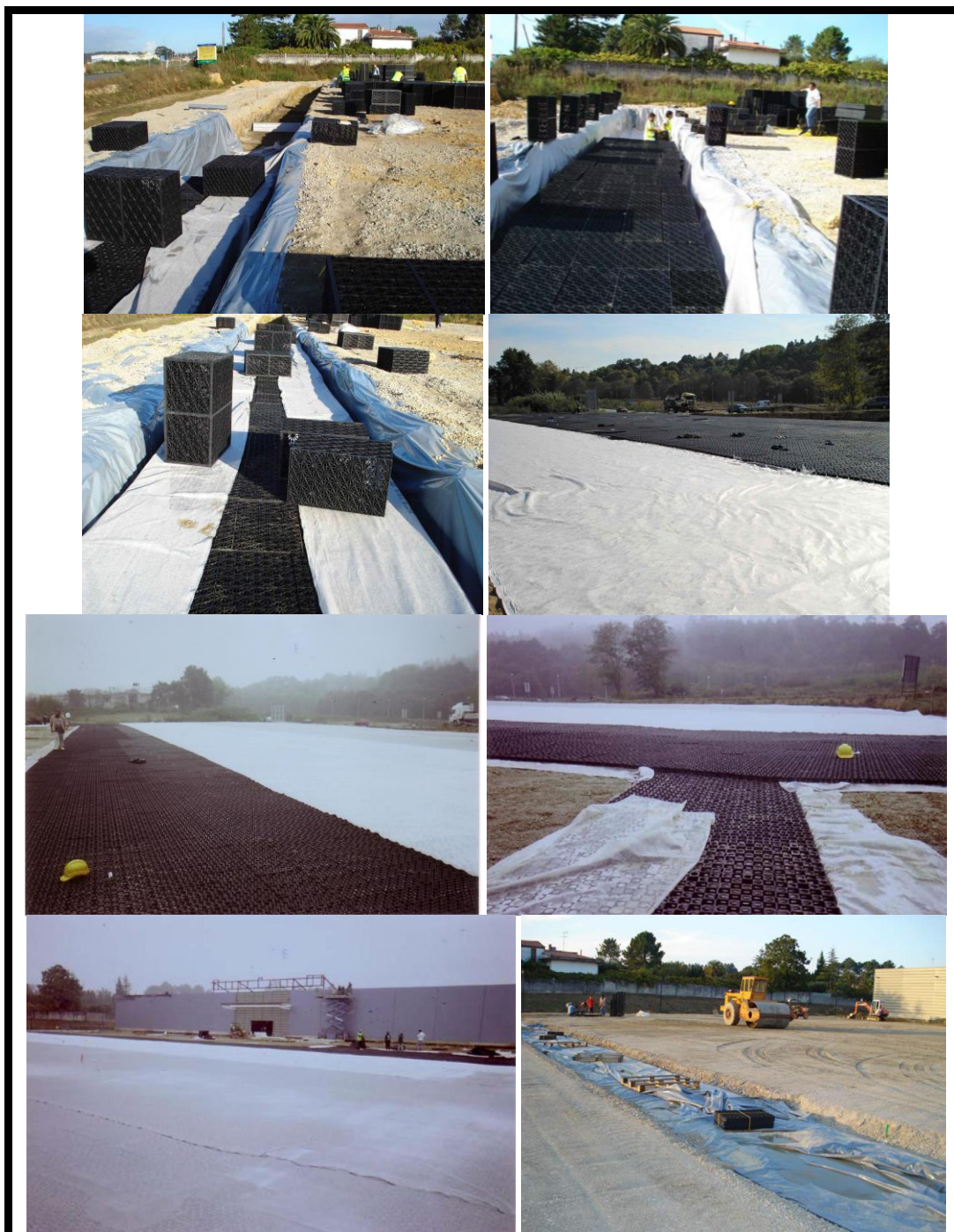
Ecoparking. Centro Comercial Carrefour Oleiros (A Coruña). Aparcamiento permeable que filtra, retiene e infiltra el agua de lluvia del tejado y aparcamiento. Bajo el asfalto permeable se dispone una capa de celdas drenantes que permiten la infiltración al terreno, y aportando un flujo subsuperficial. El agua no infiltrada en su recorrido llega hasta un depósito permeable dotado con una tubería de rebose en caso de saturación. Año 2007. Cortesía de «SUDS S.L - Atlantis».
