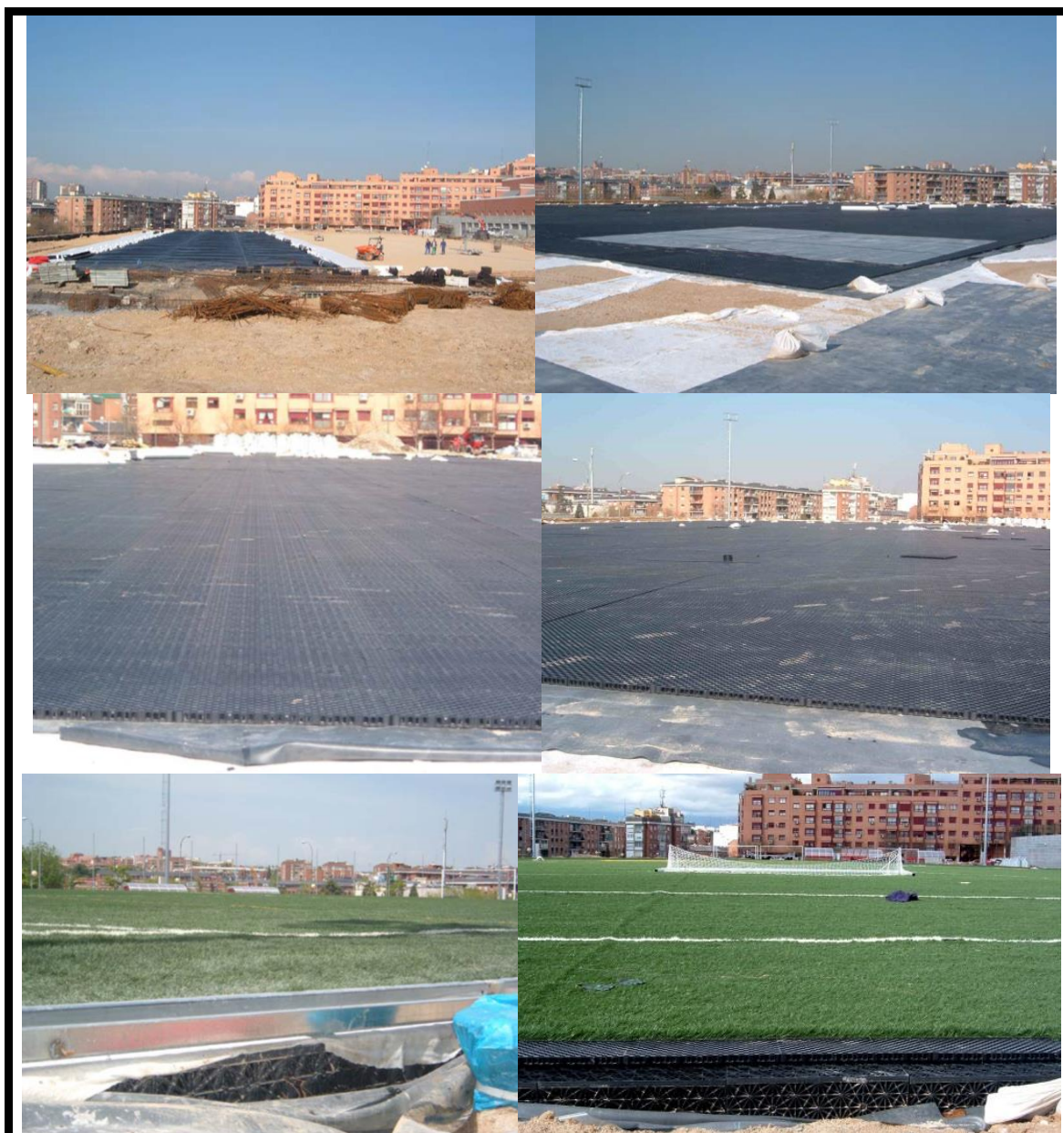
Celdas drenantes (o conductos planos) para drenaje horizontal. Polideportivo Marqués de Samaranch (Arganzuela – Madrid – España). Se utilizaron celdas drenantes de 30 mm bajo el terreno de juego para la captación y evacuación del agua de lluvia y riego a depósitos modulares perimetrales para su acumulación y posterior reciclado. Año 2006. Cortesía de «SUDS S.L - Atlantis».
