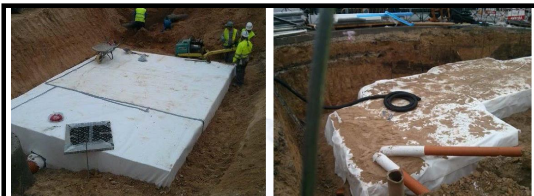
El agua previamente filtrada en los SUDS puede ser almacenada en depósitos. Depósito modular permeable constituido con cajas drenantes y geotextil. Nueva Sede BBVA en el Barrio de Las Tablas Madrid (Fase I y Fase II). Drenaje horizontal de las aguas pluviales mediante un pavimento permeable, el agua previamente filtrada llega al depósito de almacenamiento e infiltración. Años 2013-2015. Cortesía de «SUDS S.L - Atlantis».
