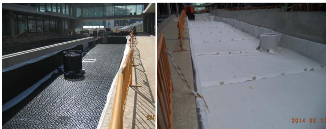
Celdas drenantes (drenaje horizontal) en Jardinería. Nueva Sede BBVA en el Barrio de Las Tablas Madrid (Fase I y Fase II). El agua se desplaza inferiormente por las celdas (creando un nivel freático en suspensión) y evitando filtraciones o humedades a la infraestructura inferior. Años 2013-2015. Cortesía de «SUDS S.L - Atlantis».
