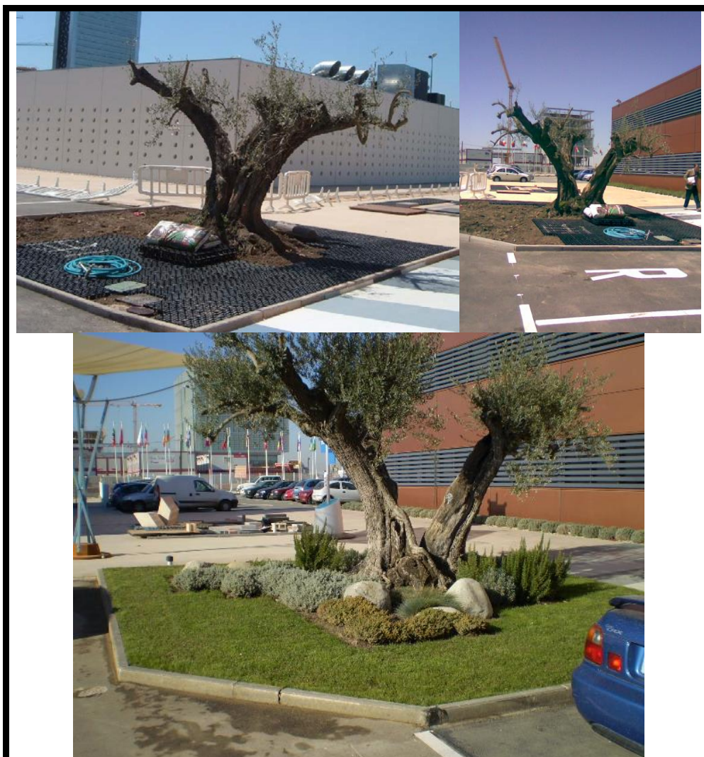
Celdas drenantes de 52 mm en superficie alcorques. Expo-Zaragoza. Años 2007-2008. Cortesía de «SUDS S.L - Atlantis».
