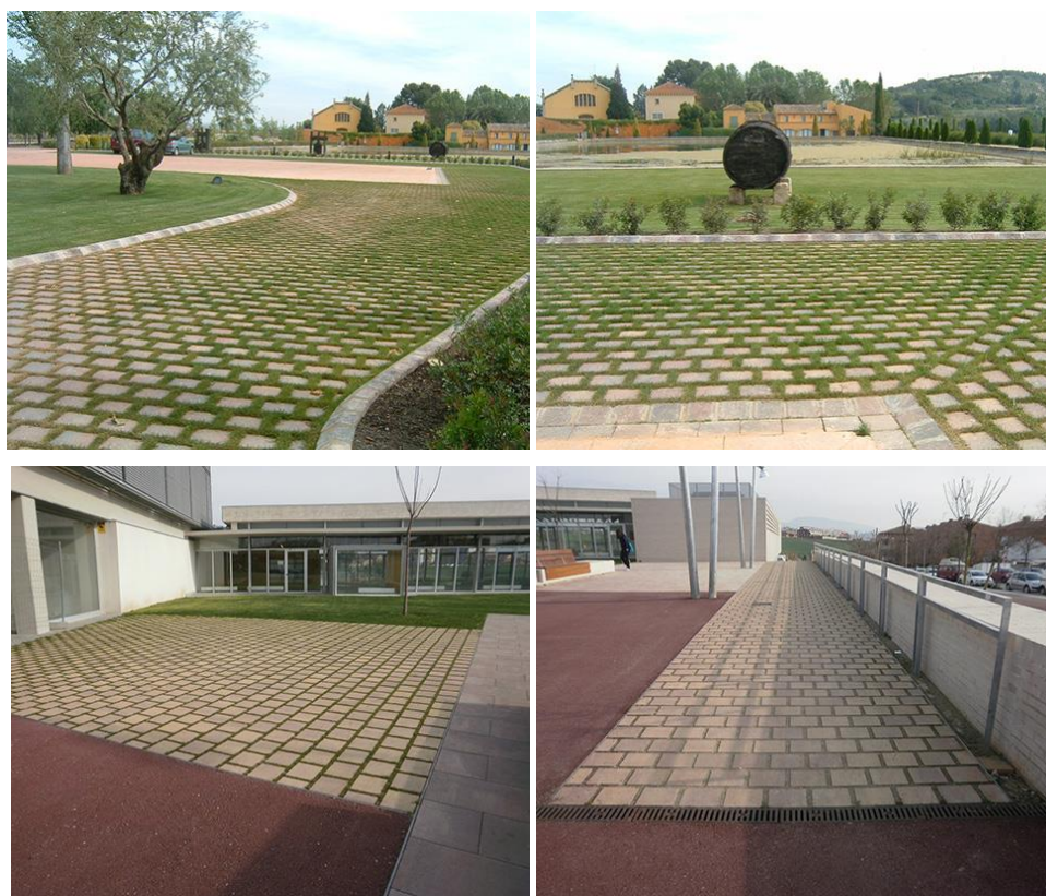
Pavimentos permeables (o drenantes): Adoquín Juntas Verdes. El adoquín con junta verde acumula el agua de lluvia y deja que se vuelva a evaporar. Aproximadamente el 25% del área es junta verde y el 75% es adoquín. Cortesía de Breinco.
