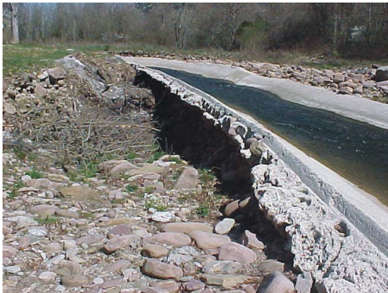
Foto 7: Primera fase de la canalización del río Urrobi en Zandueta
