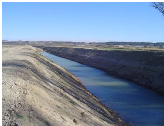
Foto 27: Detalle del mismo barranco tras las obras de emergencia
