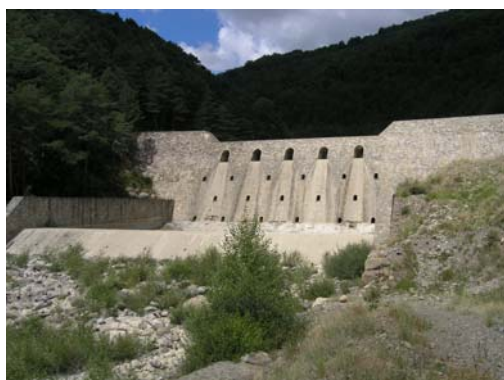
Foto 28: Nueva presa de sedimentos en el barranco de Arás (A.Ollero)
