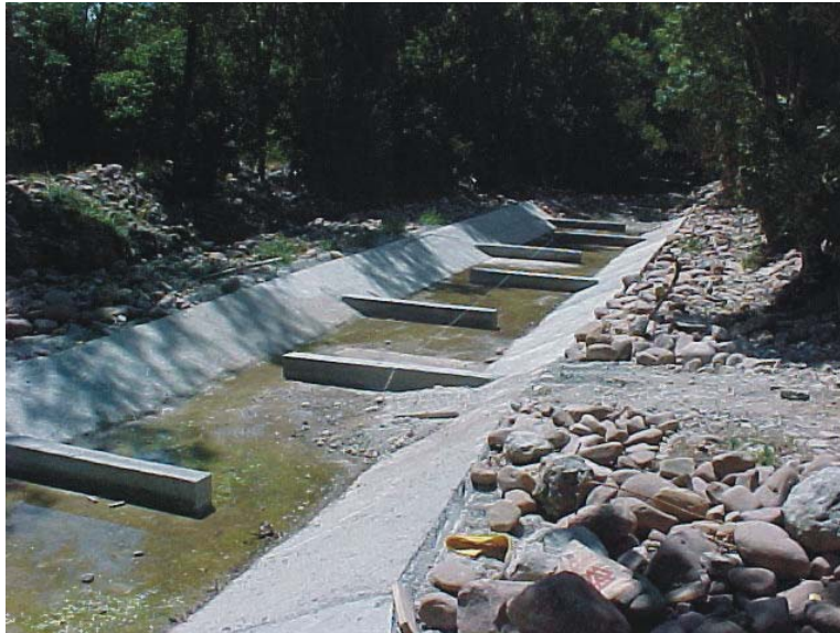
Foto 8: Segunda fase de la canalización del Urrobi en Zanduetta, con deflectores para reducir la velocidad del agua
