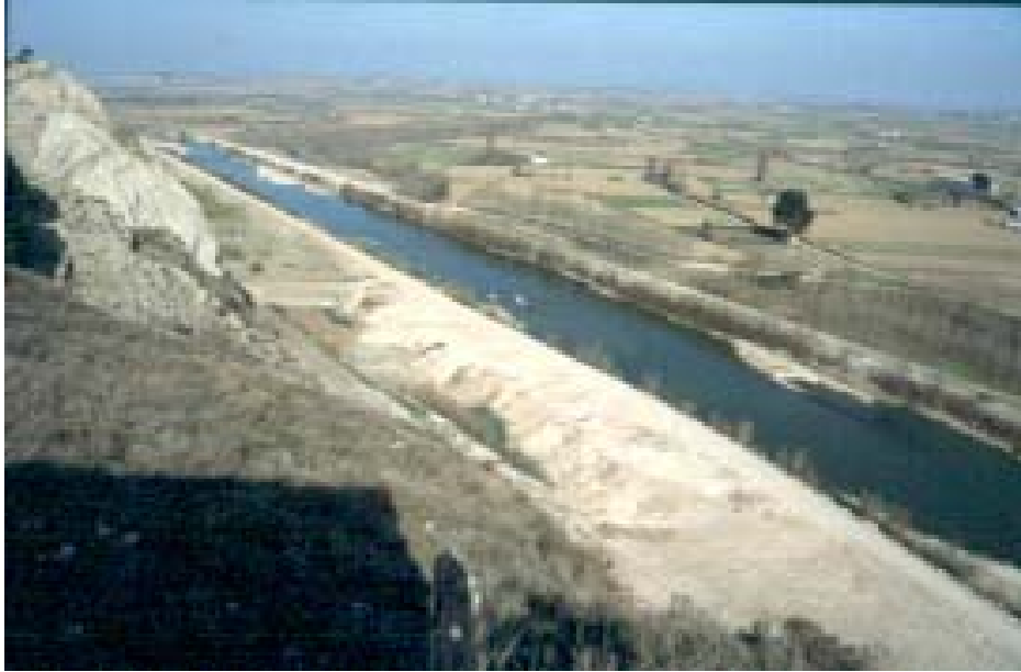
Foto 6: Bajo Arga canalizado (A.Ollero)
