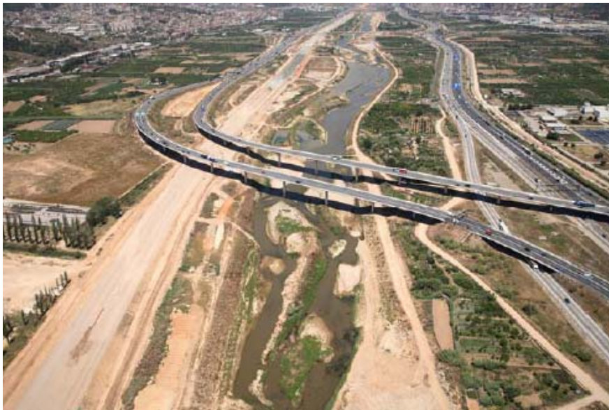
Foto 3: Vista general del tramo afectado por la Línea de Alta Velocidad en el Baix Llobregat (Consell Comarcal del Baix Llobregat)
