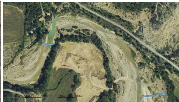
Foto 20: Extracción en el mismo meandro en 2006
