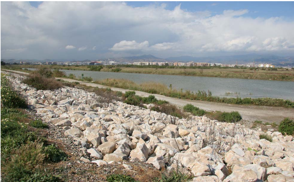
Foto 52: Curso bajo del Guadalhorce, escollera y canalización, con Málaga al fondo (A.Herrera)
