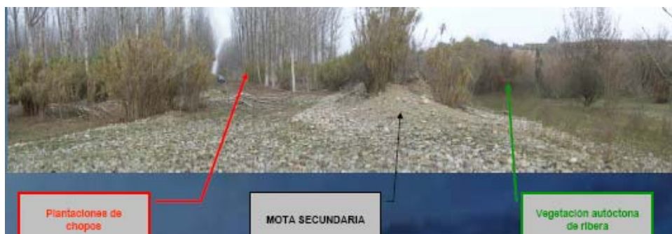
Foto 45: Imagen de la mota secundaria, conformada por acumulación de gravas en mal estado (Confederación Hidrográfica del Ebro)
