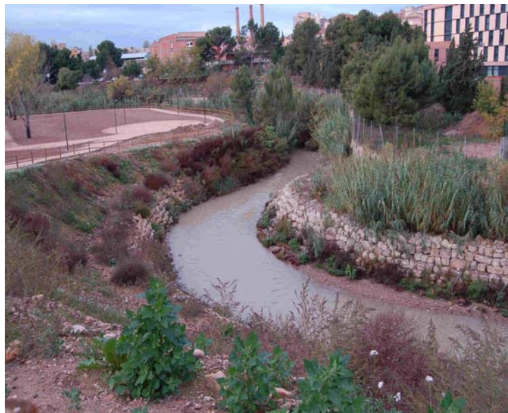
Foto 1: Escollera en ambas márgenes, protegiendo en la convexa (sedimentaria) un rodal de cañas, en el río Huerva (J.Bellosta)
