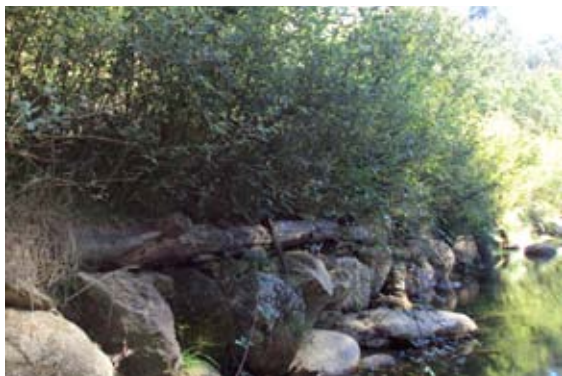
Tramo de Loureza, situación posterior a la restauración.
