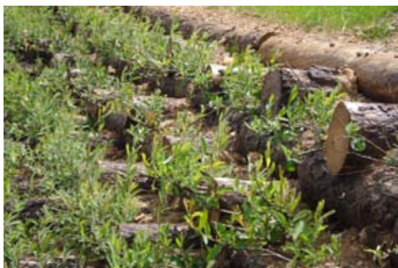
Detalle de empalizada de defensa reforzada.
