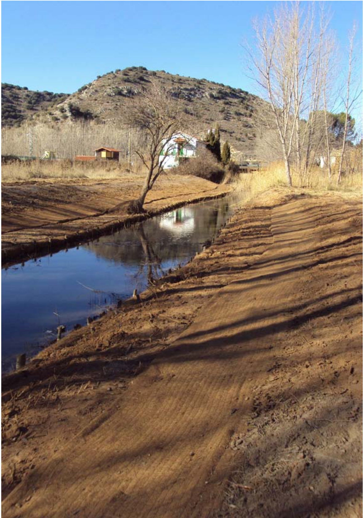
Estado del canal del molino tras la restauración.
