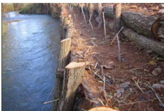
Detalle del estaquillado.
