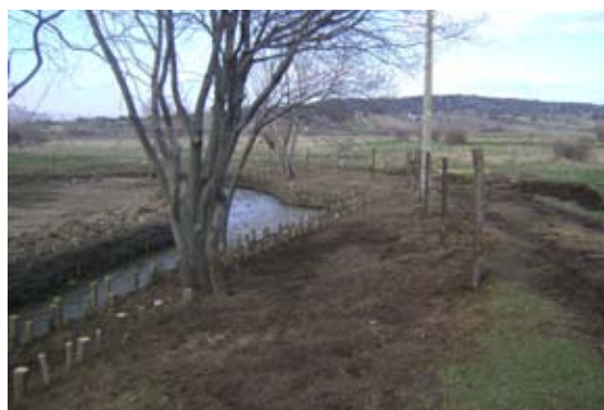
Situación tras la ejecución de la fajina de empalizada trenzada.
