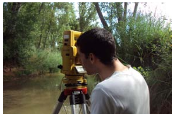
Realización de levantamiento topográfico.
