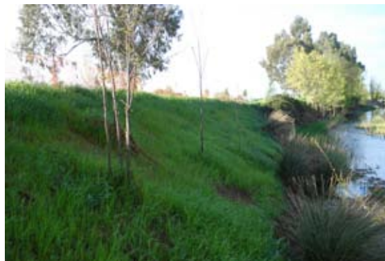
Talud restaurado mediante la utilización de una geomalla y plantación.
