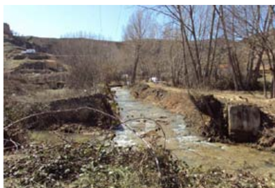
Situación inicial en el cauce del canal del molino.
