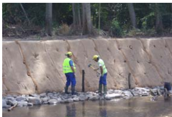
Taludes durante la ejecución de los trabajos.
