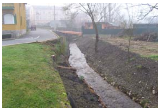
Situación de los taludes después de la restauración.
