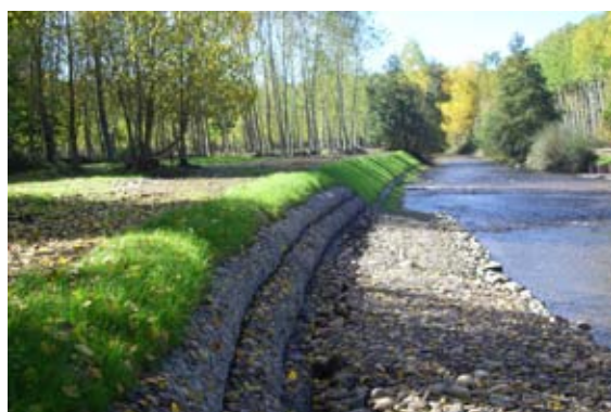
Taludes tras la finalización de los trabajos.
