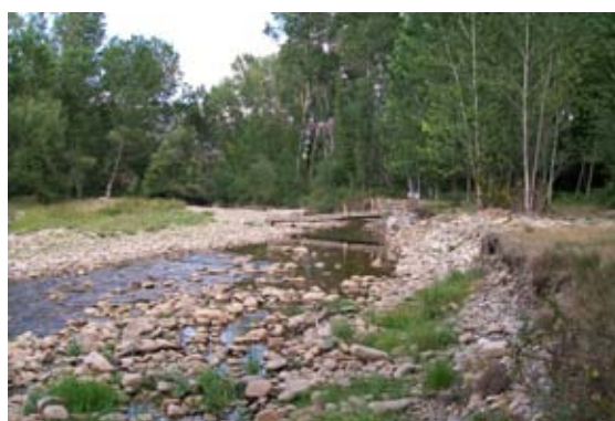
Estado previo a las actuaciones de restauración.
