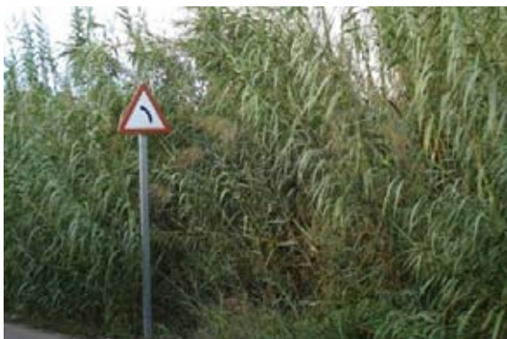
Invasión en el talud de la caña común.
