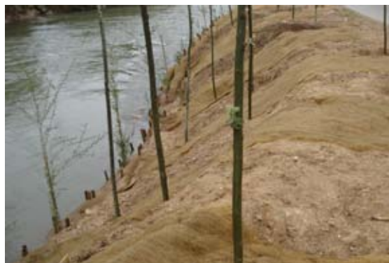
Colocación en el talud de las cubriciones orgánicas de forma alterna y plantaciones.
