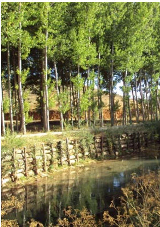
Restauración de taludes mediante la construcción de entramados vivos.
