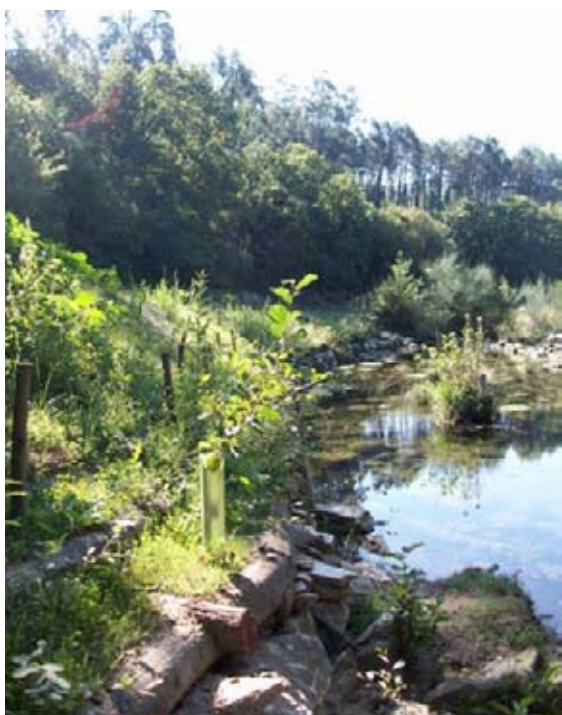
Tramo de Barrio Novo, después de la restauración del talud mediante empalizada trenzada reforzada, geomalla orgánica, estaquillado y plantación.
