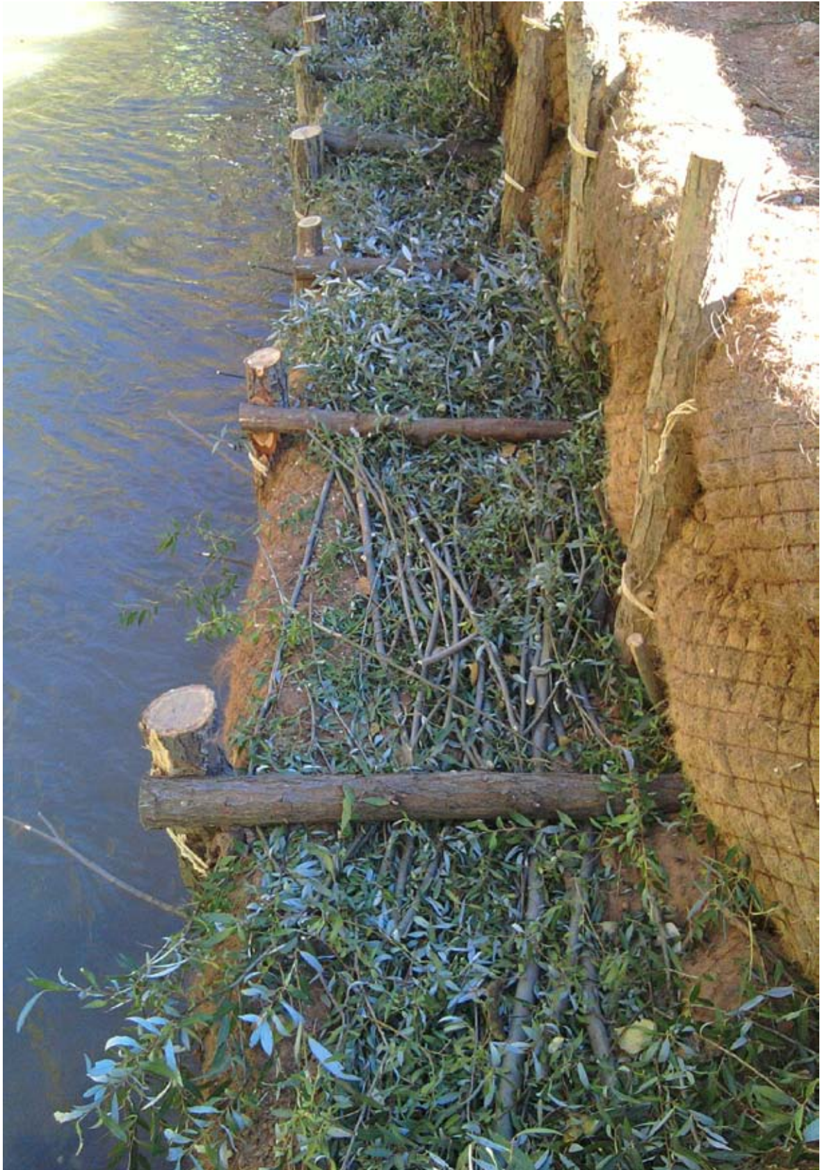
Detalle del talud restaurado, empalizada de rollos estructurados.
