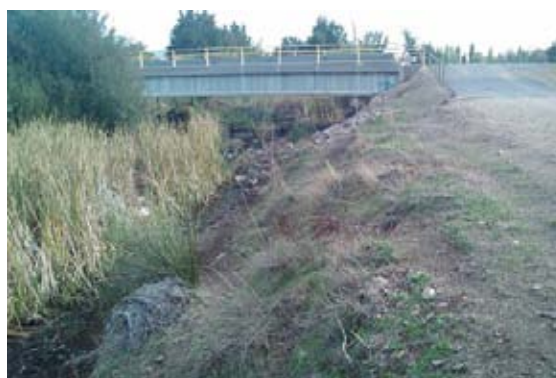
Situación inicial de los taludes.
