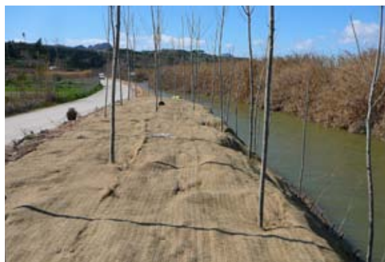
Plantación sobre cubrición orgánica y biorrollos en el pie de talud.
