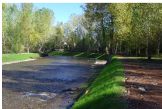
Estado final una vez ejecutadas las técnicas de bioingeniería.
