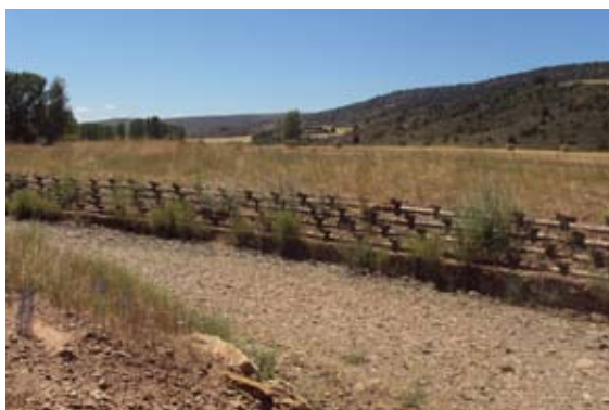
Talud restaurado mediante empalizada de defensa reforzada.
