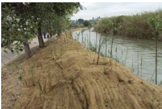
Colocación de cubriciones orgánicas de forma continua y plantaciones.
