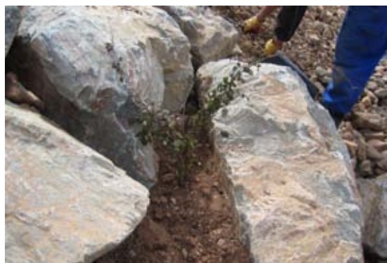
Detalle de la combinación de elementos inertes con estaquillado.
