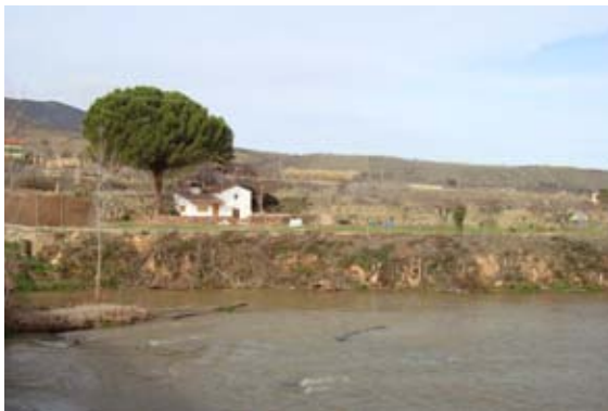
Situación inicial del talud.
