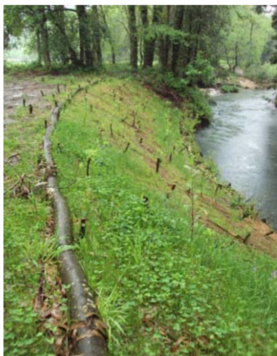
Restauración de tramo de Urgal mediante geomalla y estaquillado.
