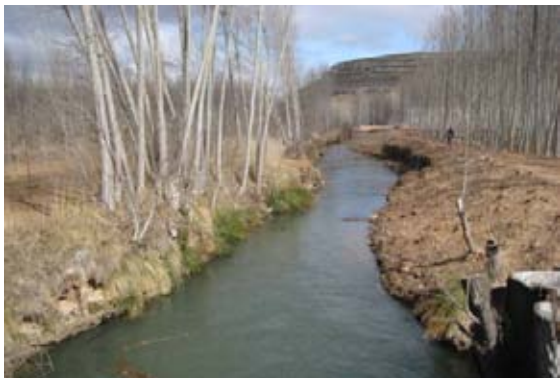
Estado del río Piedra tras la finalización de las obra de restauración.
