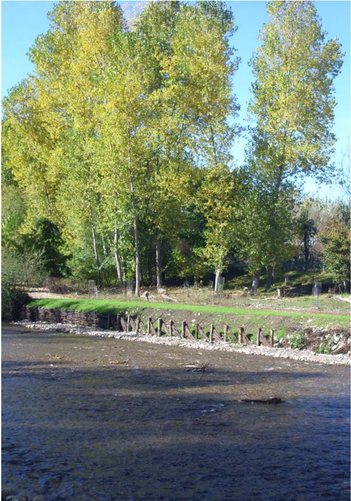
Situación final tras ejecutar las fajinas de tipo Pantalla Wolf.
