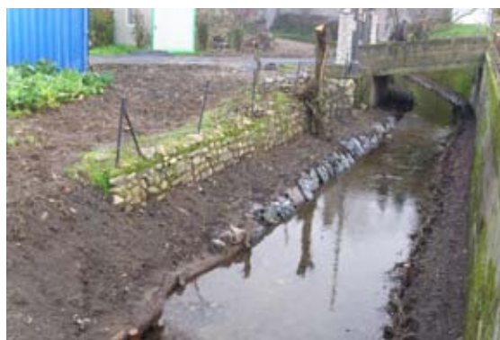
Tramo del cauce después de la restauración.
