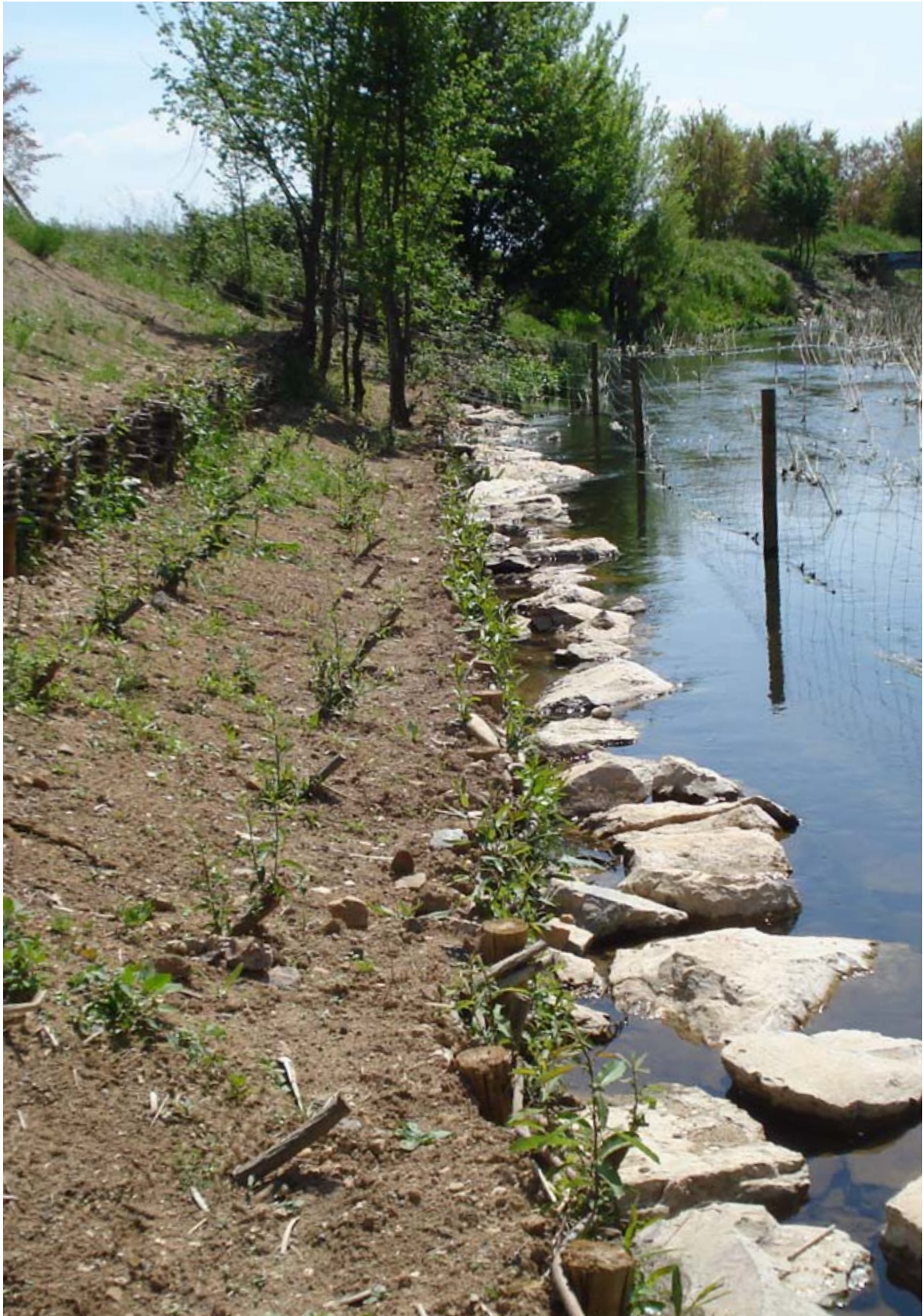
Talud restaurado mediante diversas técnicas.
