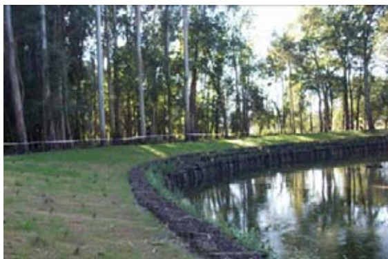
Tramo de Urgal, restauración del talud mediante empalizada de defensa reforzada, geomalla orgánica y estaquillado.
