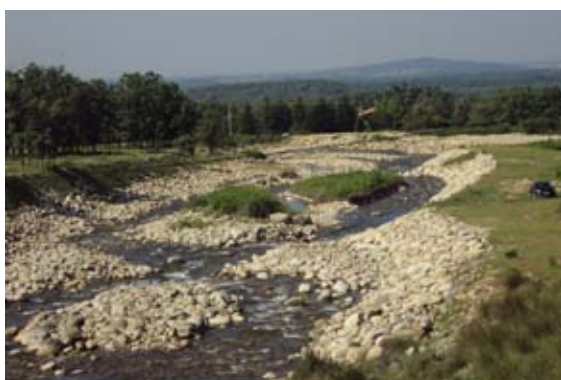
Estado posterior a la restauración del cauce.
