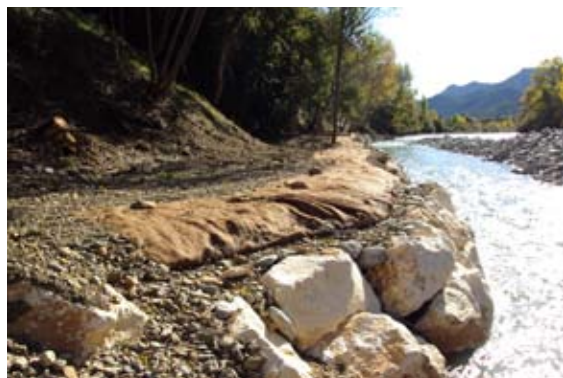
Detalle de la zona restaurada con la construcción de una escollera vegetada y la colocación de una geomalla.
