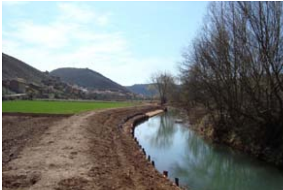
Estado del río Piedra tras la restauración.
