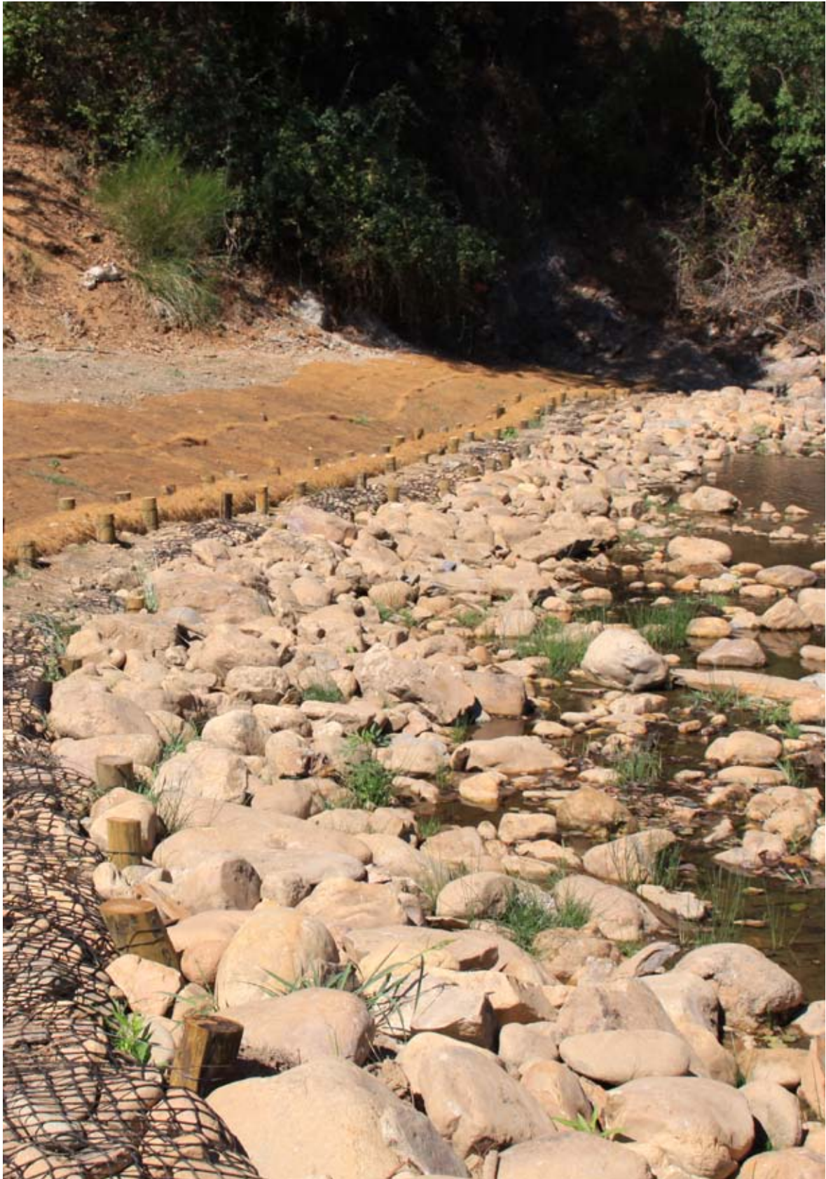
Gavión flexible con rollo estructurado y cubrimiento orgánico.
