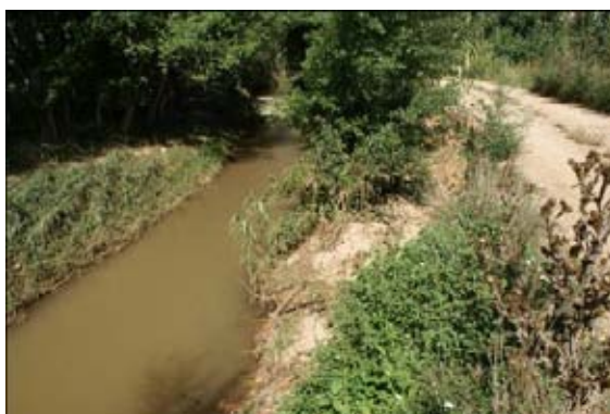
Situación inicial de los taludes.
