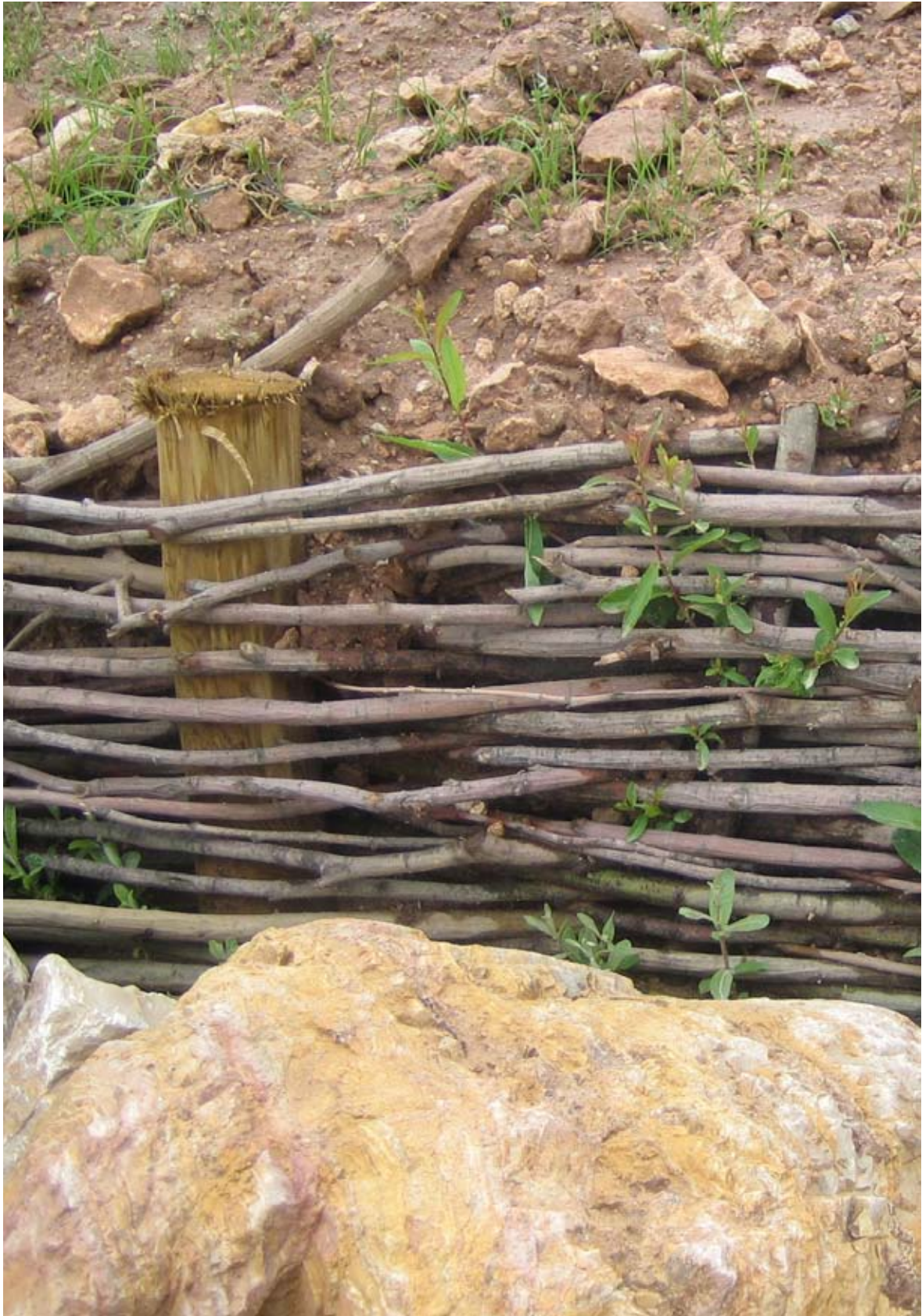
Talud con protección de fajina de empalizada trenzada.
