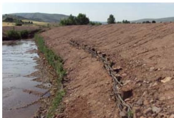
Construcción de una fajina de empalizada trenzada.
