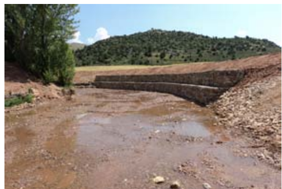
Muro de gaviones construido para contener talud.
