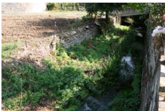
Tramo del cauce antes de la intervención de restauración.
