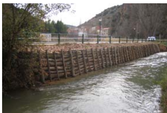
Entramado vivo con la finalidad paliar los problemas erosivos.
