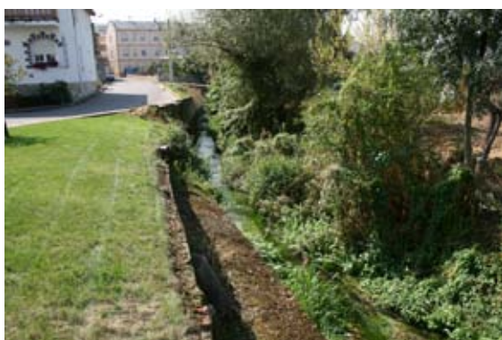
Situación de los taludes antes de la restauración.
