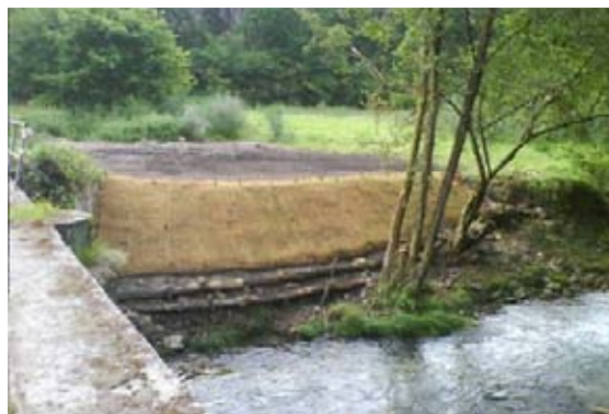
Tramo de Loureza, restauración a base de varias técnicas de bioingeniería: geomalla orgánica, empalizada de defensa reforzada y estaquillado.
