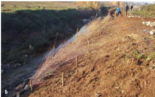
Figura 46. Ejemplo del entramado de alambres que se tienden entre estacas (a). Con este método se logra el doble objetivo de eliminar el cañaveral y restaurar la cubierta vegetal del talud, como puede verse en las imágenes (b, c) de la actuación desarrollada en Arroyo Harnina, Almendralejo (Badajoz). Imágenes: DGA (MAGRAMA) – TRAGSA.
