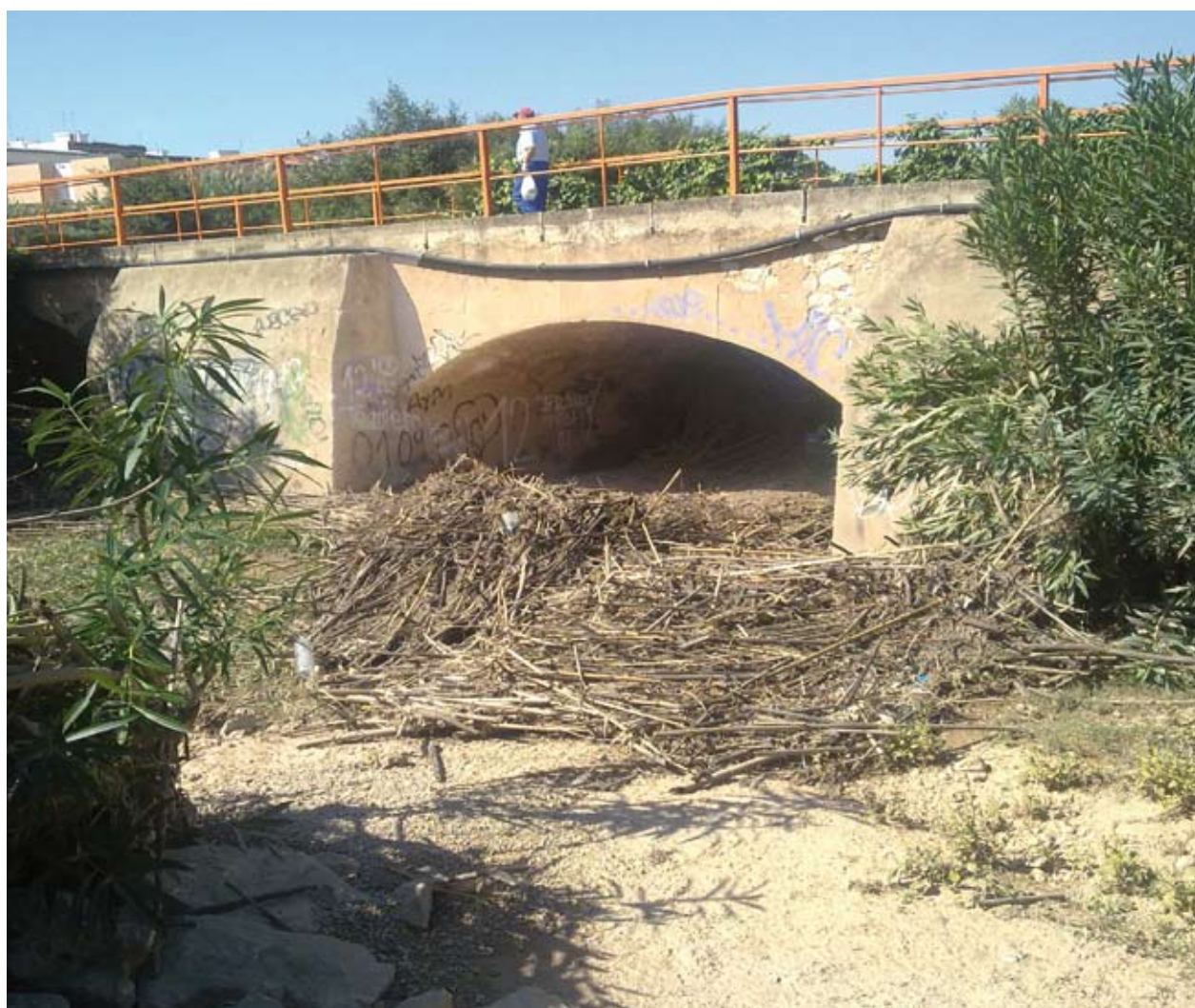
Figuras 13 y 14 (página siguiente). La formación de represas como consecuencia del arrastre de restos de cañas (arriba) durante las riadas es un factor de riesgo en base al cual se realizan múltiples intervenciones de gestión de cañaverales. Sin embargo, la colonización por parte de A. donax de las riberas fluviales provoca impactos negativos en el funcionamiento de los ecosistemas fluviales menos evidentes y rara vez evocados. Es el caso del incremento en la pérdida de agua por evapotranspiración como resultado del elevado consumo de agua de esta especie exótica unido a la gran superficie foliar de los cañaverales, como estos del río Turia a su paso por Vilamarxant, Valencia (página siguiente). Imágenes: Generalitat Valenciana.
