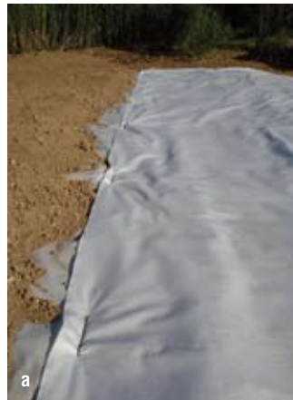
Figura 40 . Detalles de: (a) fijación mediante grapas de las coberturas; (b) grapas utilizadas; (c) solapamiento entre fragmentos y (d) fijación de los extremos de las coberturas mediante la realización de una zanja en la que se introduce el plástico de polietileno que, posteriormente, es cubierto por sustrato. Imágenes: DGA (MAGRAMA) – TRAGSA.
