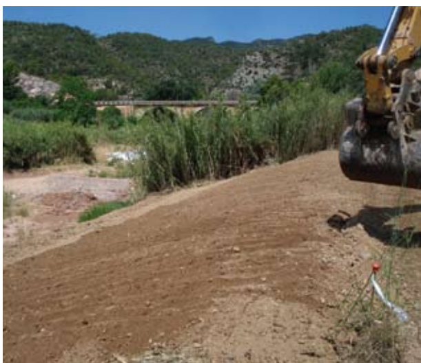
Figura 41. La longevidad de las coberturas, como estos geotextiles no tejidos, puede prolongarse cubriéndolas con el sustrato que se obtenga en el mismo lugar de la actuación. Imágenes: DGA (MAGRAMA) – TRAGSA.
