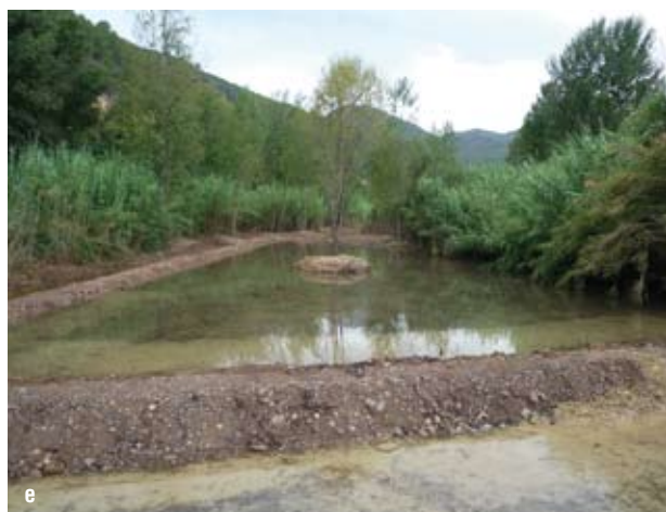
Figura 43 . La puesta en práctica del método de inundación requiere el desbroce del cañaveral y la retirada de los restos vegetales (a, b). Posteriormente, debe construirse una mota perpendicular al curso fluvial (c, d) que permitirá retener el agua y mantener inundada la superficie ocupada por A. donax (e). El resultado es la completa eliminación del cañaveral una vez retirada el agua (f). Nótese cómo en la isleta que permanece emergida como parcela control se produce la recuperación del cañaveral. Localización: Río Mijares, Espadilla (Castellón). Imágenes: DGA (MAGRAMA) – TRAGSA.
