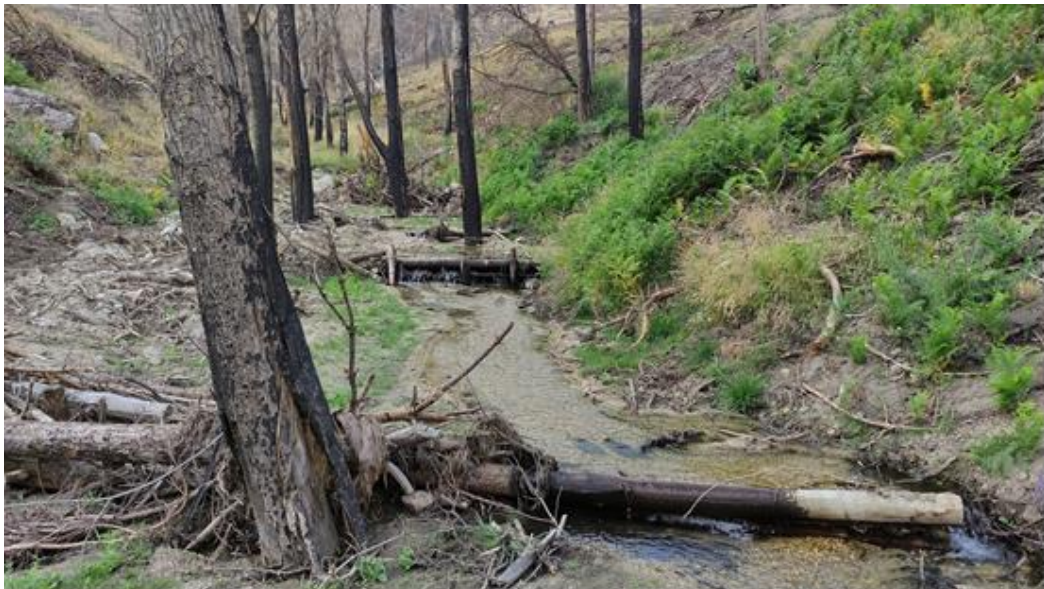
Fotografía 25. Albornadas para el control de la erosión en un cauce afectado por el incendio forestal de La Paramera, Ávila (2021).
