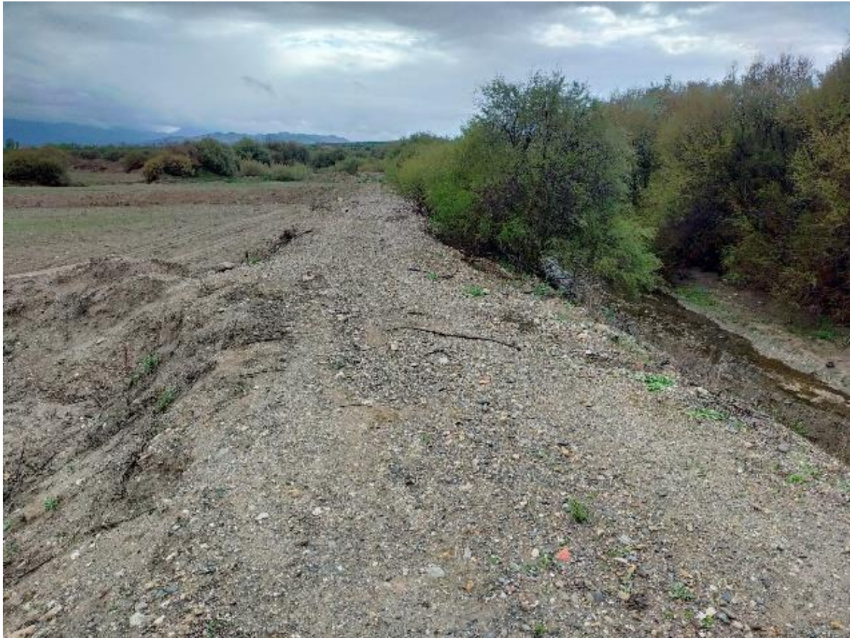
Fotografía 20. Alteración de la conectividad lateral. Mota de tierra en las proximidades del cauce del río Baza.
