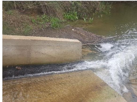
Fotografía 9. Mejora de la continuidad longitudinal de las poblaciones piscícolas mediante la permeabilización de azudes y presas. Escala de vertedero sumergido y orificio de fondo en el río Segura (izq.) y paso específico para anguilas en estación de aforo del río Guadiamar (dcha.).
