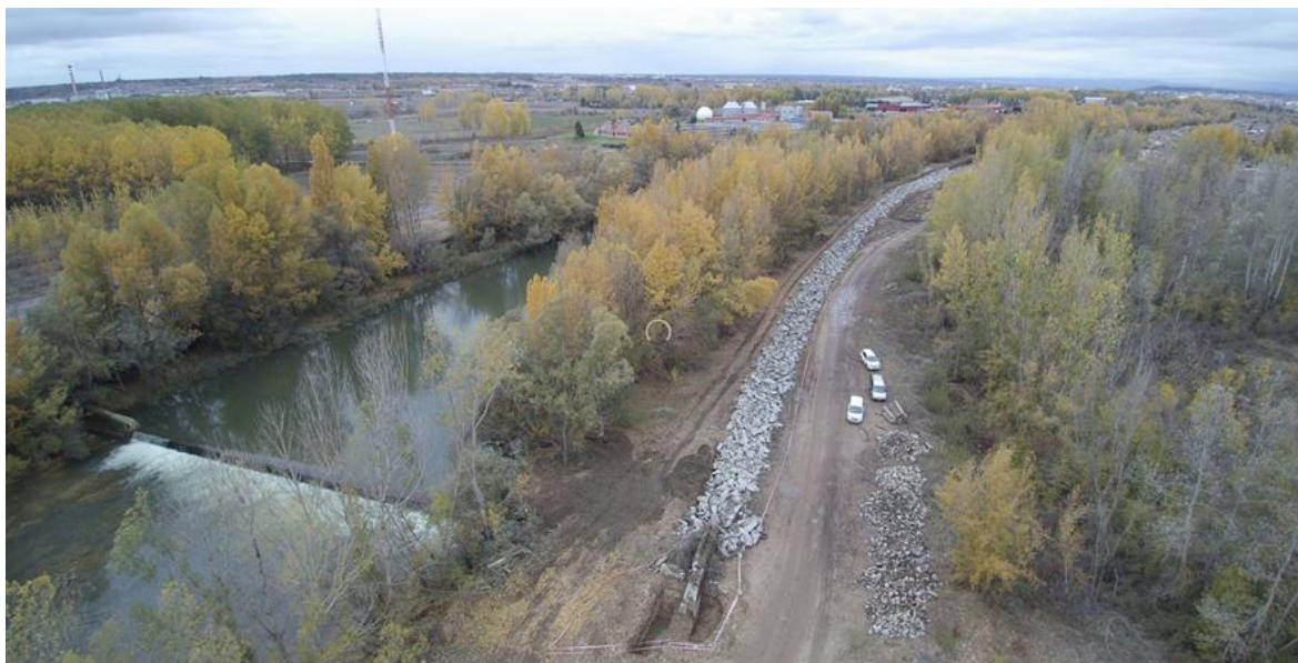
Fotografía 30. Recuperación del espacio fluvial mediante la demolición de mota de defensa en el río Bernesga.
