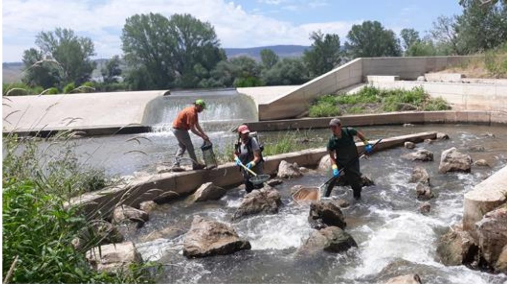
Fotografía 28. Trabajos de seguimiento en un sistema de paso para peces de tipo rampa mediante su evaluación biológica.
