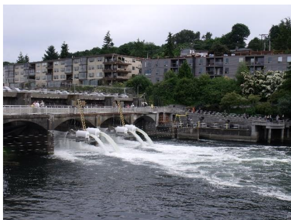
Fotografía 2. Permeabilización mediante un sistema de paso para peces de una compuerta en Puget Sound, Seattle (izq.) y detalle de la presa de Glines Canyon previo a su demolición. Río Elwha, Washington (dcha.)
