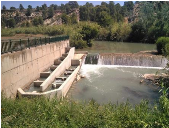
Fotografía 9. Mejora de la continuidad longitudinal de las poblaciones piscícolas mediante la permeabilización de azudes y presas. Escala de vertedero sumergido y orificio de fondo en el río Segura (izq.) y paso específico para anguilas en estación de aforo del río Guadiamar (dcha.).
