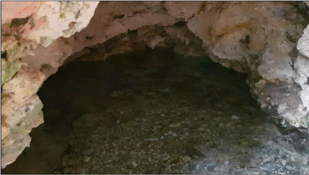
Principal punto de descarga de la nueva RNS
