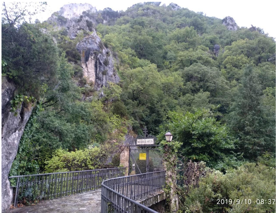
Principal punto de descarga de la nueva RNS
