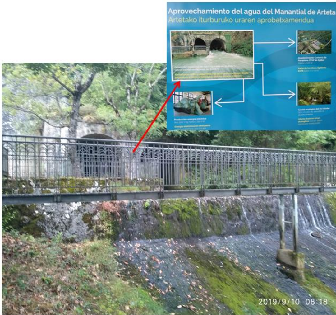
Azud para derivación a abastecimiento
