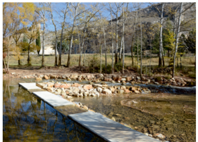
Rampa para peces en El Burgo de Osma.
