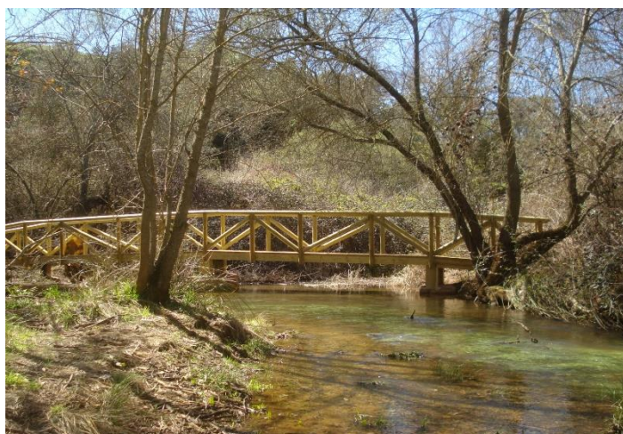
Imagen 23: Construcción de pasarelas en la senda de la RNF Río Milagro.
