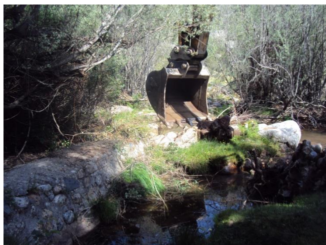
Imagen 19: Demolición de obstáculos transversales en la RNF Río Manzanares.
