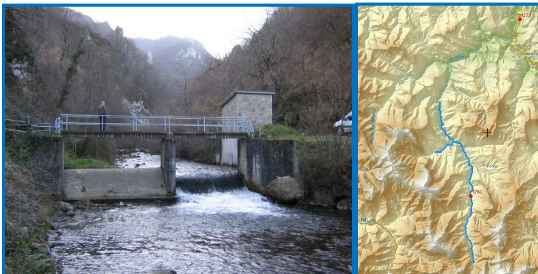
Imagen 5: Estación de aforos 1296 del Río Ponga en Sobrefoz (Asturias), con datos desde 1994, situada en la reserva natural fluvial de la Cabecera del Ponga, permite el análisis de las aportaciones en régimen natural y su variabilidad temporal, siendo un punto de seguimiento de los efectos del cambio climático en los recursos hídricos.
