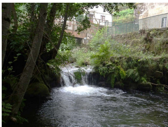
Foto 4: Azud de Regueiro
