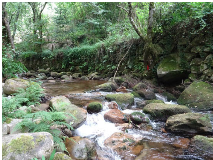
Foto 2: Tramo con muros de protección en el río Trancoso
