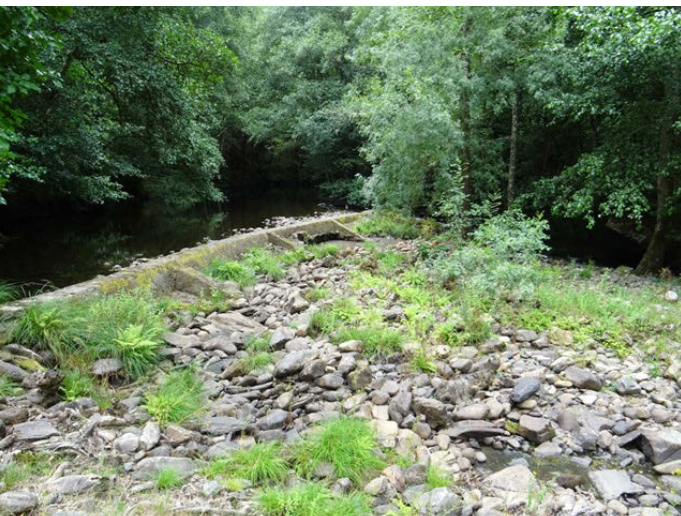
Foto 5: Obra transversal al cauce del río Agüeira (Zona 1).
