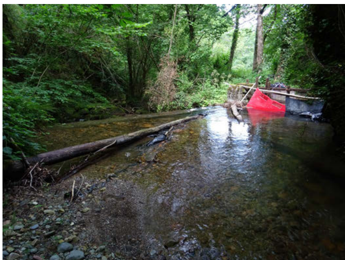
Foto 9: Azud de hormigón con canal de derivación
