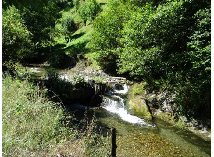
Foto 8: Obstáculo transversal aguas abajo de San Julián de Arbás, río Naviego (Zona 3).
