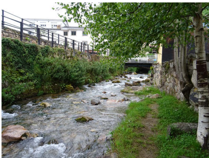
Foto 11: Canalización del río Somiedo a su paso por Pola de Somiedo
