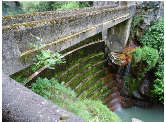
Foto 6: Presa del Río Somiedo
